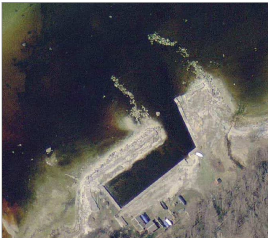
Kärdla Vetelpääste harbour (2012)
