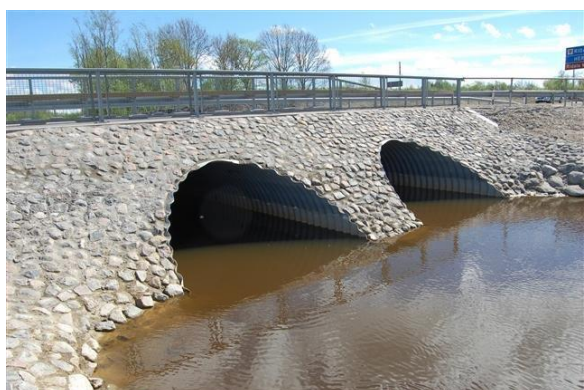
Foto 12. Betooniseguga seotud kivisillutis, mitme toru korral
