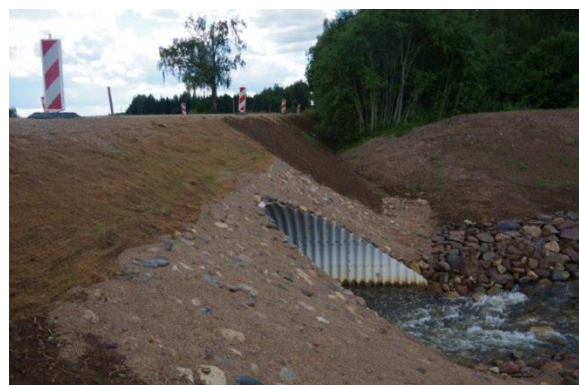
Foto 8. Erosioonitõkke matiga kindlustamine
