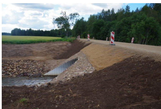
Foto 8. Erosioonitõkke matiga kindlustamine
