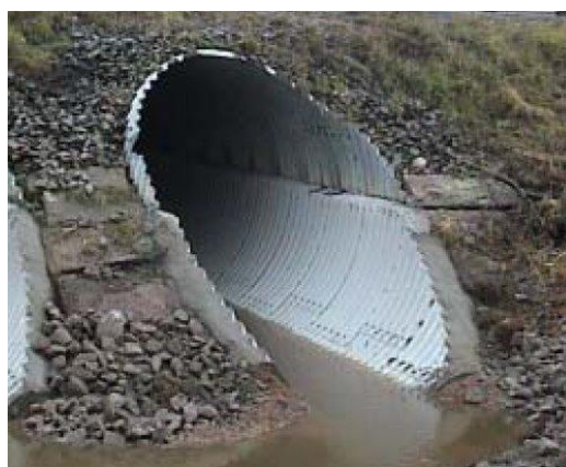
Foto 23. Toru renoveerimine uue põhja ehitamisega
