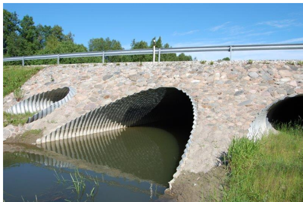
Foto 12. Betooniseguga seotud kivisillutis, mitme toru korral
