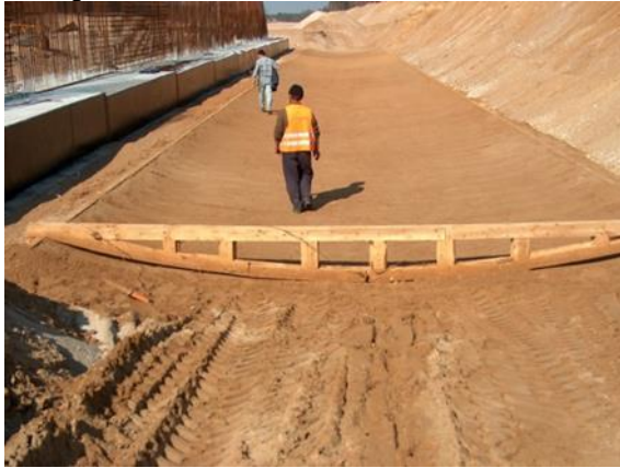
Foto 19. Toru aluspinna kujuline sängituskiht
