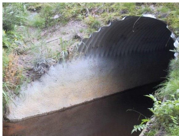
Foto 25. Toru alaosa renoveerimine pritsbetooniga
