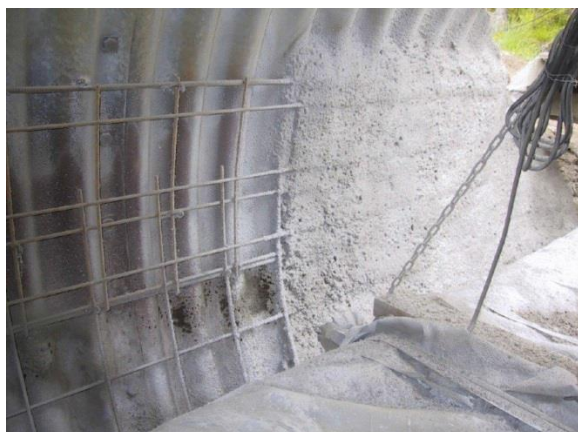
Foto 24. Toru alaosa renoveerimine pritsbetooniga
