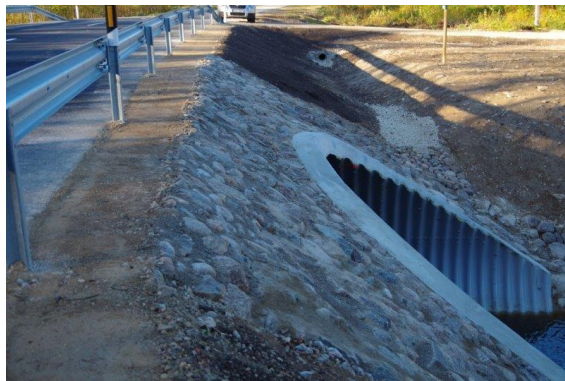
Foto 2. Torusillal arvestada pikkusega, kus tagatud kindlustatud nõlvad ja ohutud peenrad
