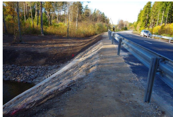
Foto 2. Torusillal arvestada pikkusega, kus tagatud kindlustatud nõlvad ja ohutud peenrad
