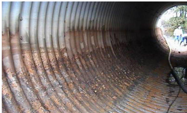
Foto 20. Pöördumatult kahjustatud terastoru alaosa
