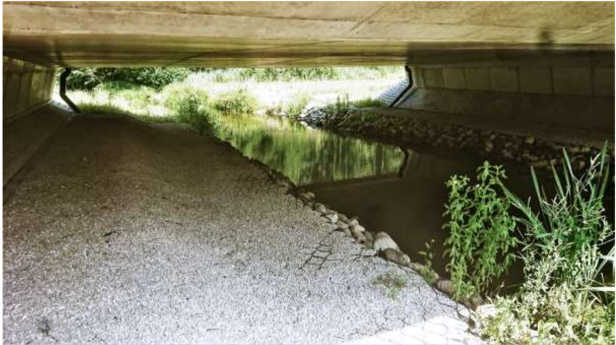
Foto 26. Suudari sild Umbusi jõel, üsna hea lahendus väikeulukite läbipääsuks kallastadadel. Foto: L. Naagel
