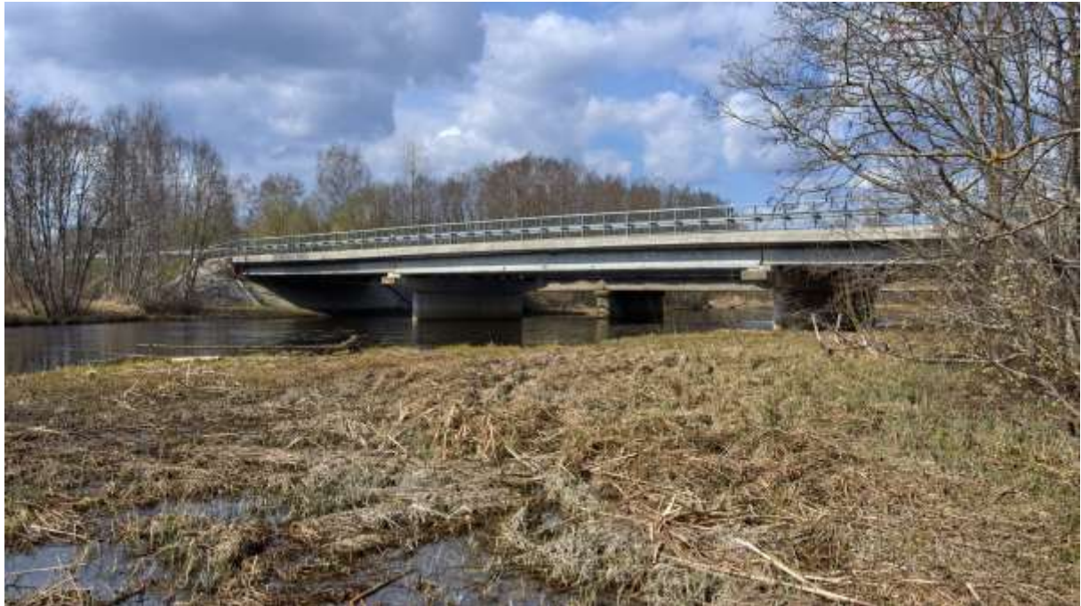
Foto 20. Põltsamaa jõe sild. Eespool on liiklusele avatud uus sild ja tagapool liiklusele suletud vana sild, mis vastavalt hetkekavale lammutatakse. Foto: J. Remm
