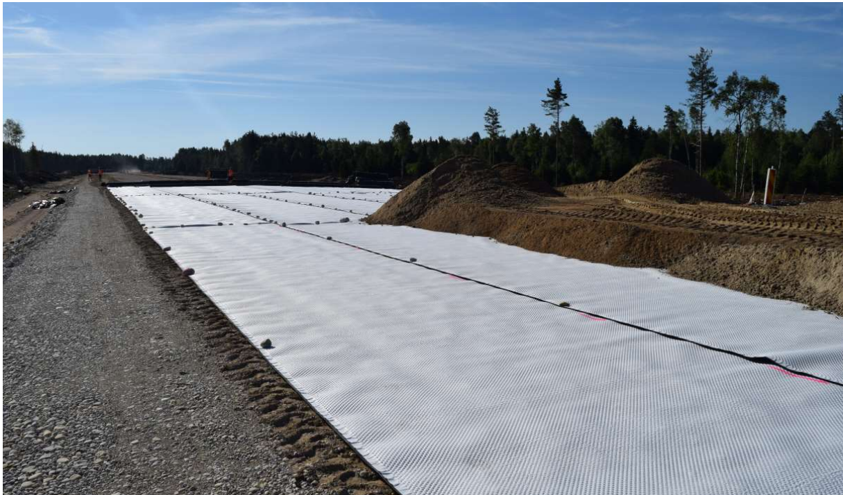
Joonis 14. Dreneaži geokomposiidiga Grilltex GXP Dren 8 SP paigaldus (foto: TREV-2)
