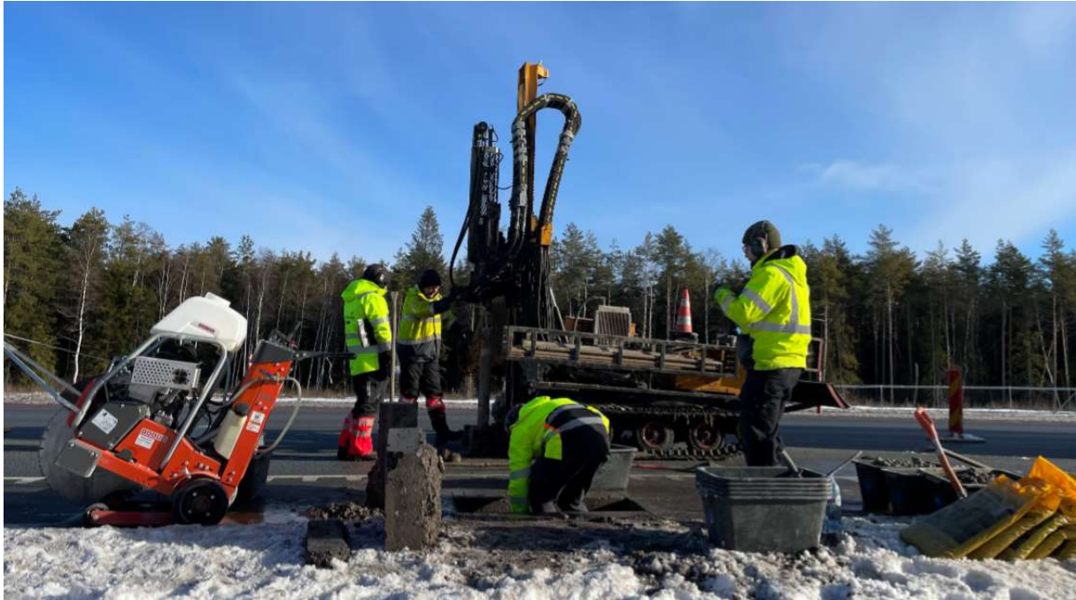
Joonis 20. Katte puurimised ja surfimistööd
