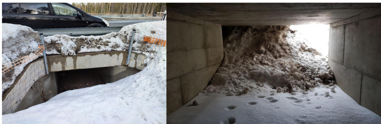
Fotod 80 ja 81 Lumekoristustööde tagajärjel oli talvel ulukite pääs Liiva väikeulukitunnelisse takistatud.
