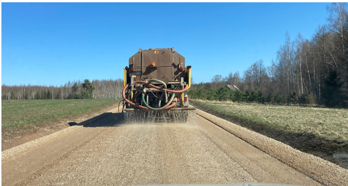
Joonis 5. Töödeldud tee kastetakse, et kloriid lahustuks paremini kulumiskihis.
