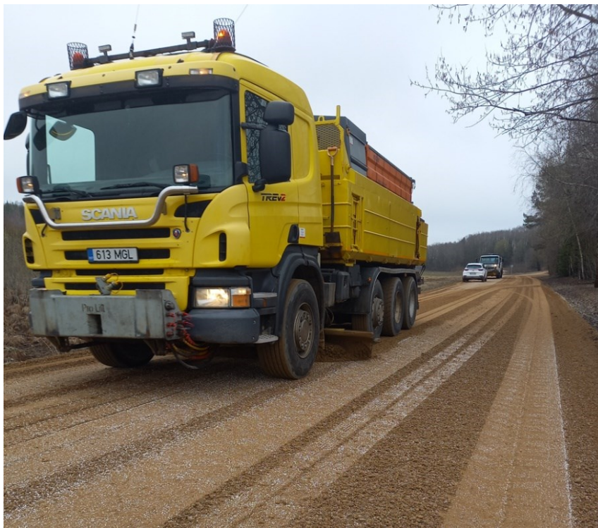
Joonis 4. Kulumiskiht segatakse ja viimistletakse baasauto alussahaga.
