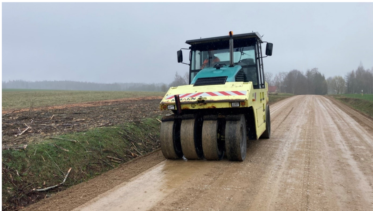
Joonis 6. Kloriididega töödeldud tee tihendamine.
