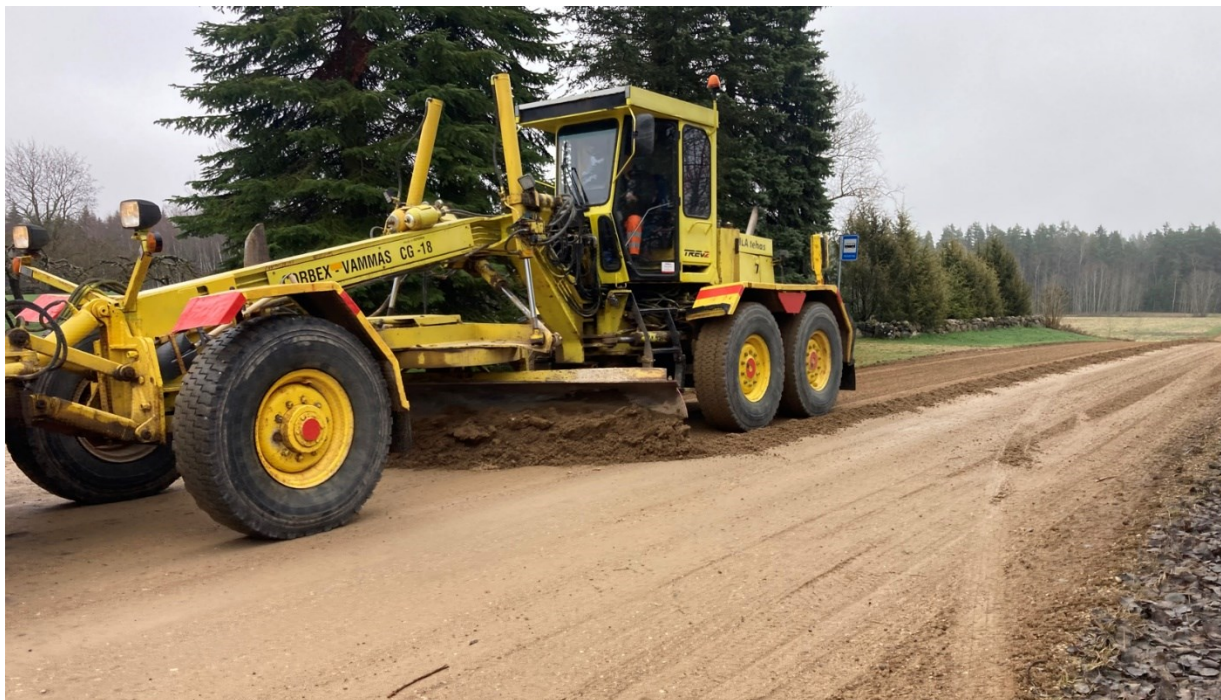
Joonis 2. Kruuskatte kobestamine ja profileerimine enne tolmutõrjet.
