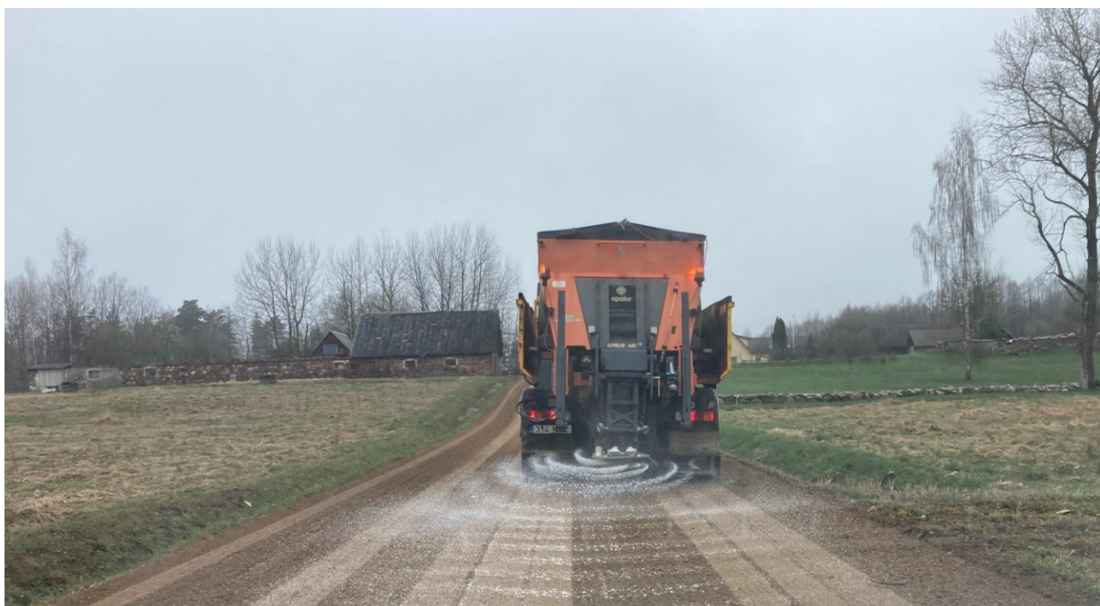
Joonis 3. Kloriid laotatakse kruusa peale ühe või kahe laotuskorraga, olenevalt tee laiuselt.
