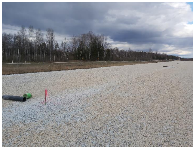
Foto 8. Tsentraalreepereite pikendamine aprillis 2020, enne katendi paigaldamist
