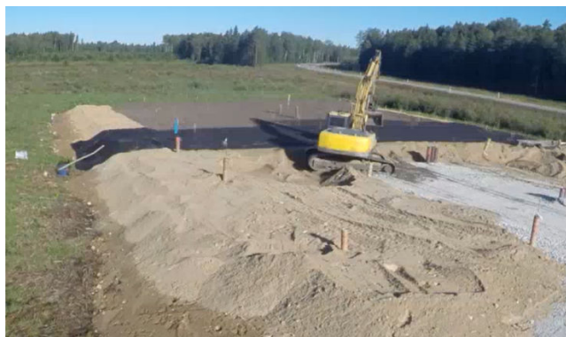
Fotod 3 ja 4. Kergkruusaga sektsioon selle ehitamise ajal (esiplaanil on geokärje sektsioon).
