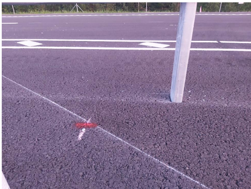
Foto 5. Põrkepiirde lähedusse paigutatud katendireeperite tähistus.
