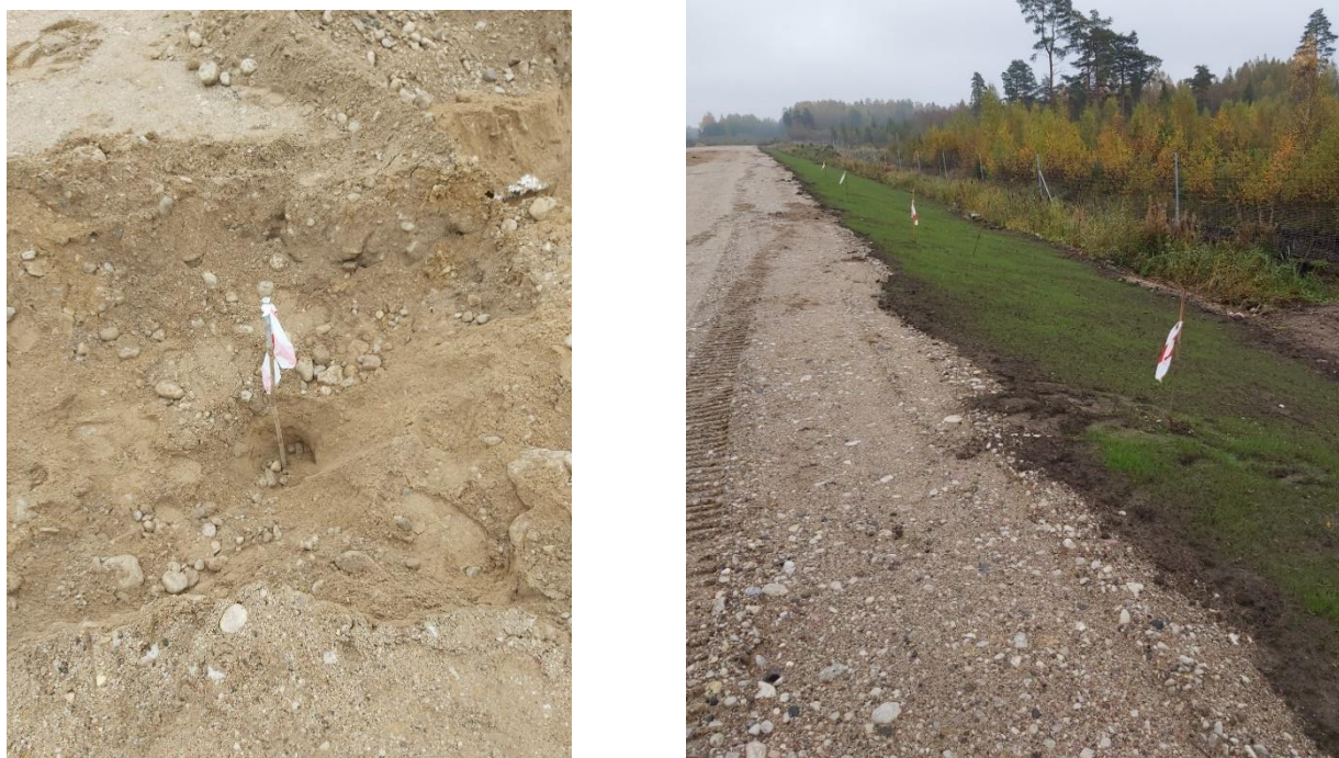
Foto 7. Tsentraalreepereite pikendamine (vasakul), vaade kolmanda sektsiooni säilinud nõlvareperitele (paremal), oktoobris 2019.
