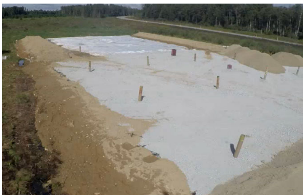
Fotod 3 ja 4. Kergkruusaga sektsioon selle ehitamise ajal (esiplaanil on geokärje sektsioon).
