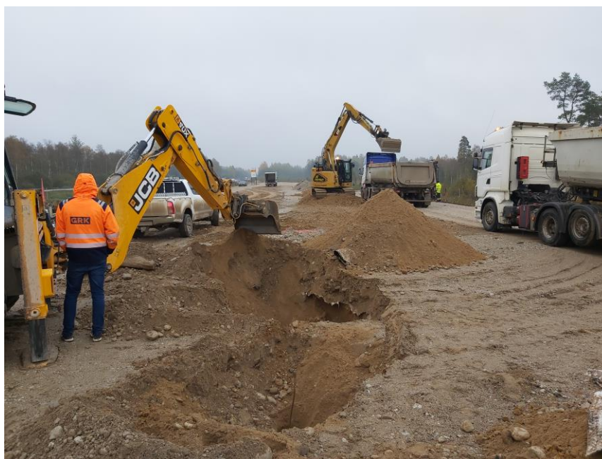
Foto 2. Tiivikkatsete jaoks paigaldatud torude otsimine
