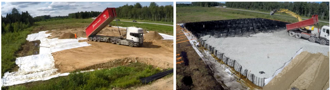
Fotod 1 ja 2. Geotekstiilide ja geokärje sektsioonid nende ehitamise ajal.
