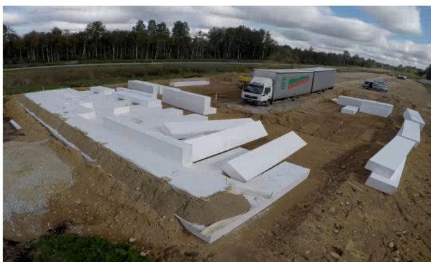
Fotod 5 ja 6. EPS sektsioon selle ehitamise ajal.
