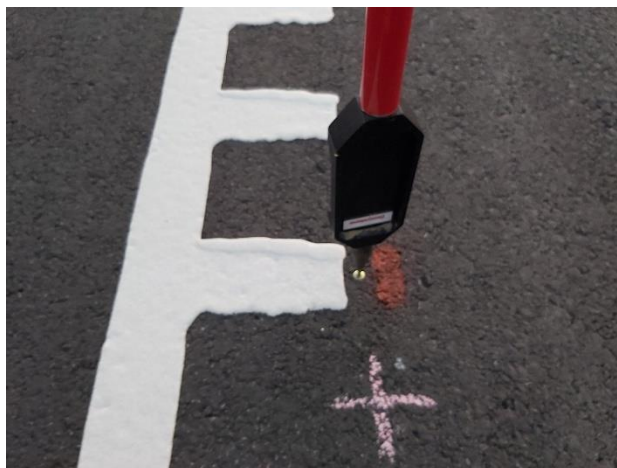
Foto 15. Twin Target tähis paigutatuna koordineeritud asukohta katendil.
