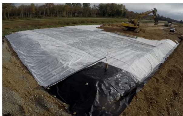
Fotod 3 ja 4. Kergkruusaga sektsioon selle ehitamise ajal (esiplaanil on geokärje sektsioon).
