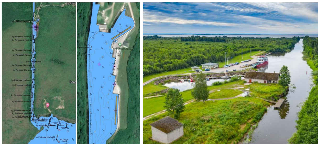
Joonis 48. Piirissaare sadam – juurdepääsukanal (vasakul), sadam (keskel), vaade sadamast ja juurdepääsukanalist (paremal) (allikas: Saarte Liinid)
