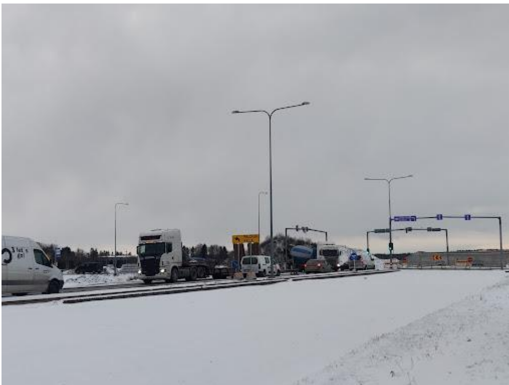
Foto 1. Saue Olerexi parkimisplatsilt vaade Keila poolt tulevatele raskeveokitele, mis suunduvad Kanama viaduktile. ELLE OÜ
