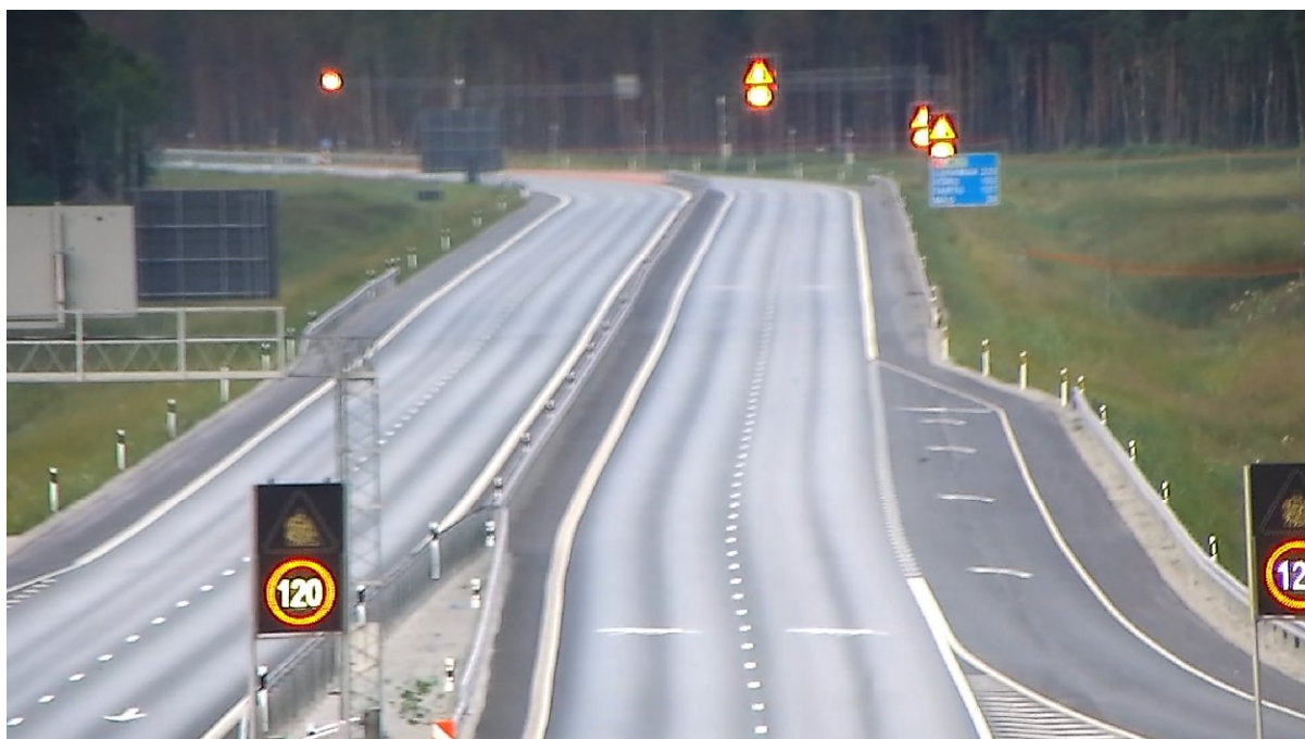
Joonis 25 LTS häire on aktiveerunud, kuid eelmises VMS ristlõikes on endiselt suurim lubatud kiirus 120 km/h. Soovitus on ka eelnevad VMS-d integreerida LTS süsteemiga toimima.
