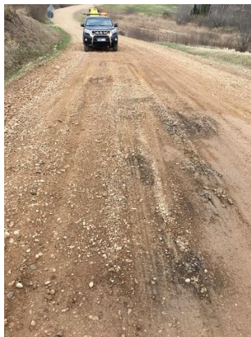
Foto 8. Vaade künkale, millele on paigaldatud hiljuti uus kruusakiht, kuid see on juba segunenud all oleva savika materjaliga.
