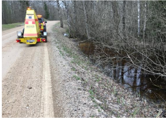
Foto 1. Tee alguses on paremal pool metsa all väga palju vett, mida saaks juhtida teisele poole teed kasutades truupi ja parandades nii niiskuselusi
