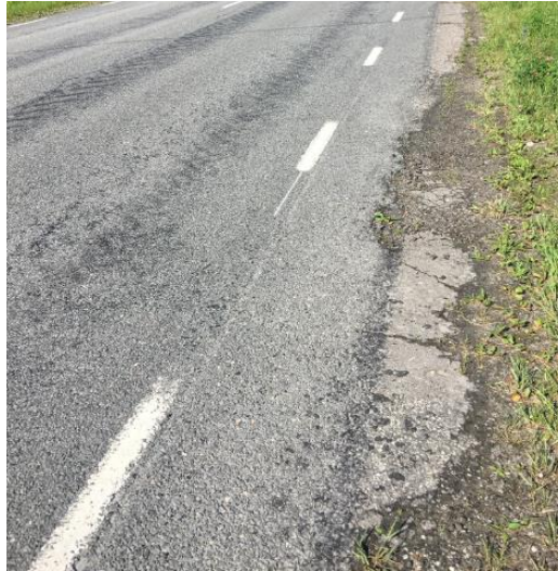
Foto 2.13. Pinnatud katte alt paljastuv stabiliseeritud kiht.
