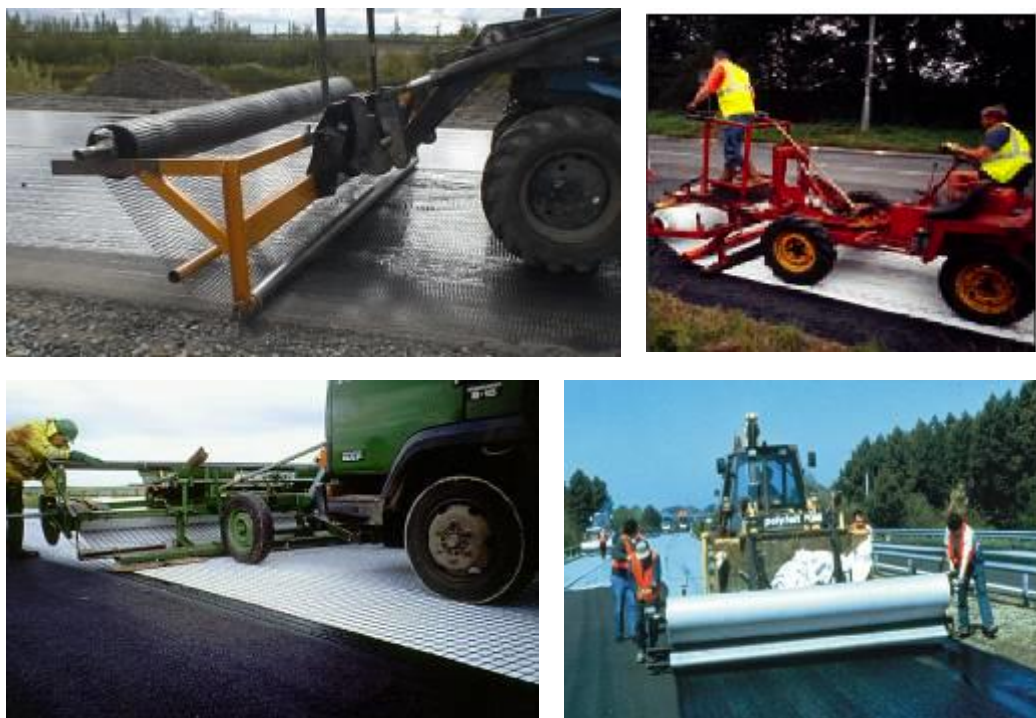
Joonis 6 – Rippmehhanismid armeerivate materjalide paigaldamiseks
