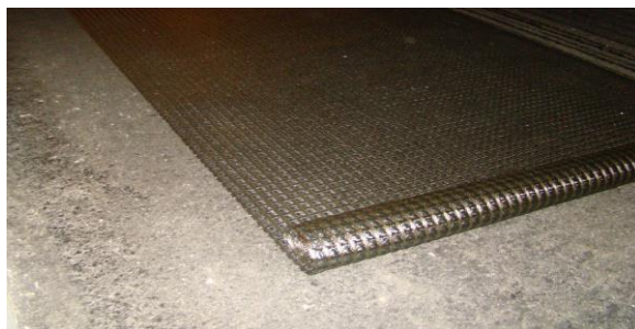
Joonis 4 – Näide geovõrgu laotamisest aluspinnale
