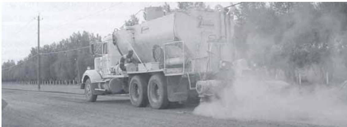
Joonis 4.4 Tsemendi laotamine laoturiga
