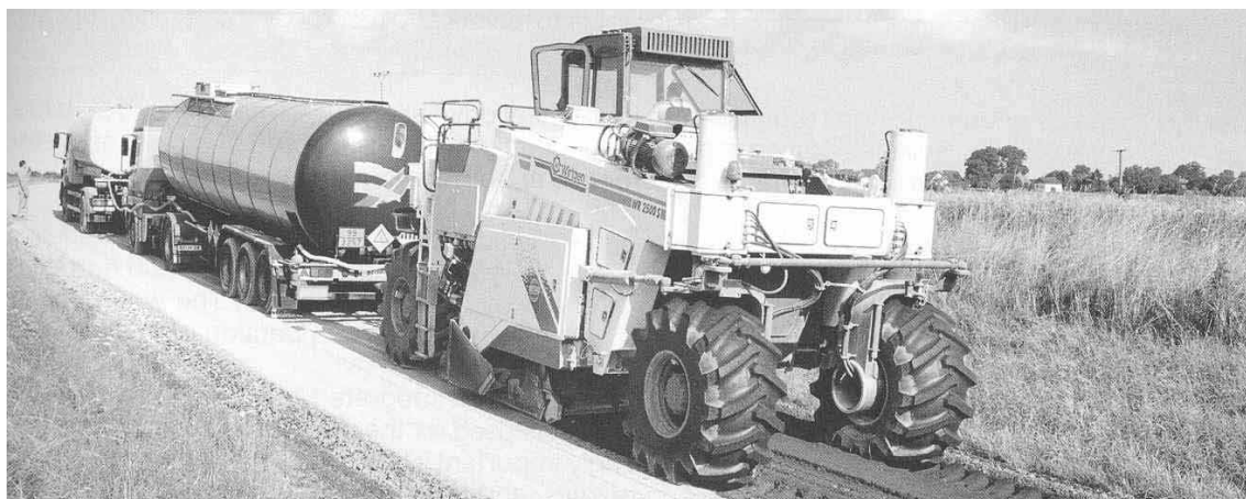
Joonis 2.6 Segamisfrees Wirtgen WR 2500 S
