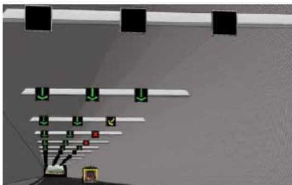
Foto 6. "TMS-DG01" DLM tunnelis
