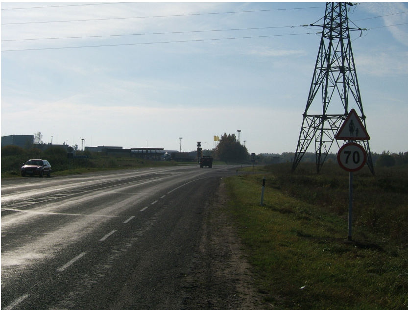
Foto 25. Ringtee ja Metsküla tee ristmik. Vaade Tallinna suunalt. Ristmiku ette on paigutatud liiklusmärgid 172 Jalakäijad ja 351 Suurim kiirus 70 km/h.
