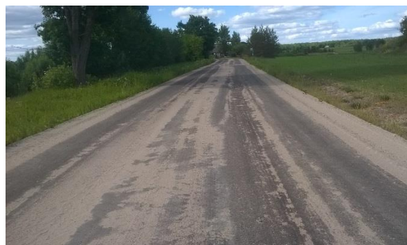
Pilt 15. Bituumenemulsiooniga töödeldud kruuskate 10 päeva peale tolmutõrjet.
