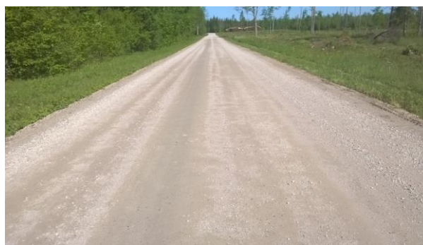
Pilt 1. 2016.a. kaltsiumkloriidi lahusega teostatud tolmutõrje katselõik, 2017
