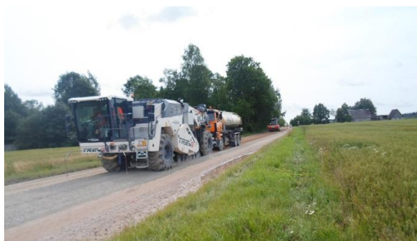
Pilt 22. Kruuskatte stabiliseerimine M10+50 TM ja LBS polümeeride ning tsemendiga
