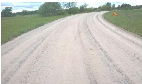
Pilt 14. Bituumenemulsiooniga töödeldud kruuskate vahetult peale tolmutõrjet. Bituumenemulsioon on kaetud sõelutud liivaga.
