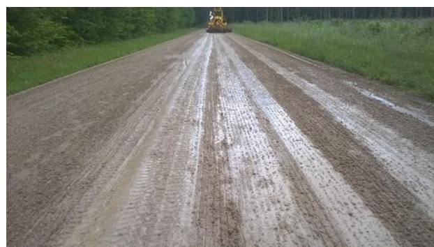
Pilt 8. Kopolümeeridega LBS ja LDC töödeldud kruuskatte vahetult peale teostust. Kate on vihma tõttu üleniiskunud.
