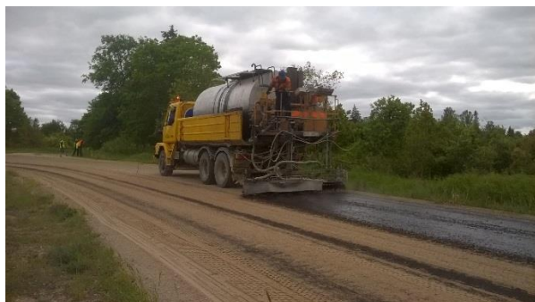
Pilt 12. Tolmutõrje bituumenemulsiooniga.
