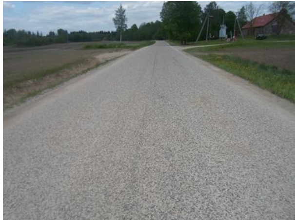
Pilt 20. InfraCrete ja tsemendiga stabiliseeritud ja 2015 pinnatud kruuskate, 2016
