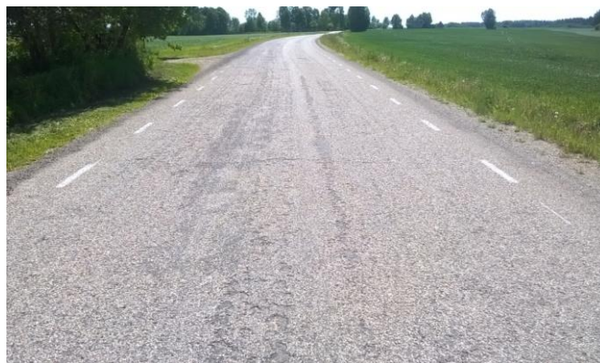
Pilt 21. InfraCrete ja tsemendiga stabiliseeritud ja pinnatud kruuskate, 2017
