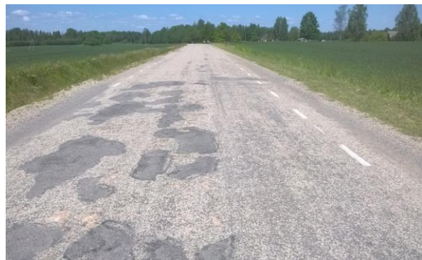
Pilt 26. M10+50™ ja LBS polümeeridega stabiliseeritud ning 2015 pinnatud kruuskate. Taamal InfraCrete'ga stabiliseeritud kruuskate, 2017
