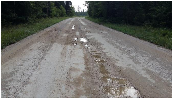
Pilt 4. Rapsiõliga töödeldud kruuskate kolm kuud pärast tolmutõrjet.
