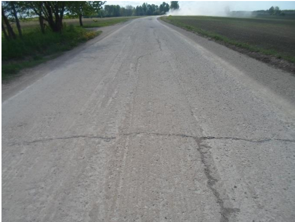
Pilt 19. Pindamata InfraCrete ja tsemendiga stabiliseeritud ja kruuskate, 2016
