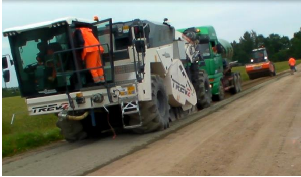
Pilt 17. Pinnase stabiliseerimine InfraCrete ja tsemendiga.
