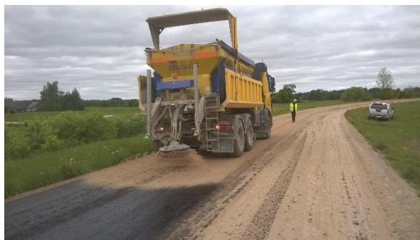
Pilt 13. Bituumenemulsiooni katmine sõelutud liivaga
