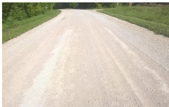
Pilt 6. Rapsiõliga töödeldud kruuskate aasta pärast tolmutõrjet, juuni 2017. Kohati on kruuspinnas rapsiõliga tugevasti seotud, märgata on hõõvli tapitera jälgi.
