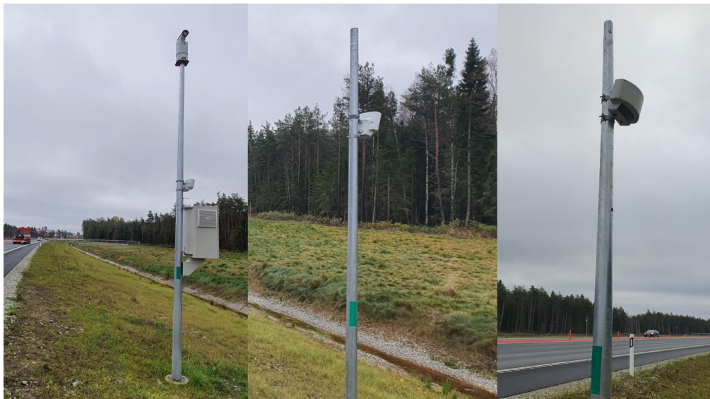
Joonis 2.7 Suurulukite tuvastussüsteem Kose-Võõbu teelõigul
