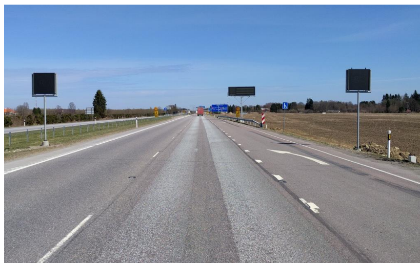
Joonis 3.7 Erilahendusega ümarmastid üksikutele kiirusmuutemärkidele
