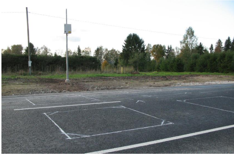
Joonis 3.5 Mäo liiklusloendur 4 m pikkusel mastil
