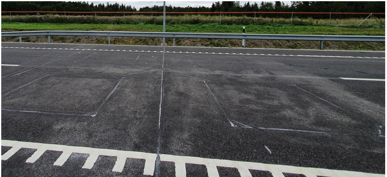
Joonis 2.5 Püsiloenduspunkti silmusandurid Kose-Võõbu teelõigult
