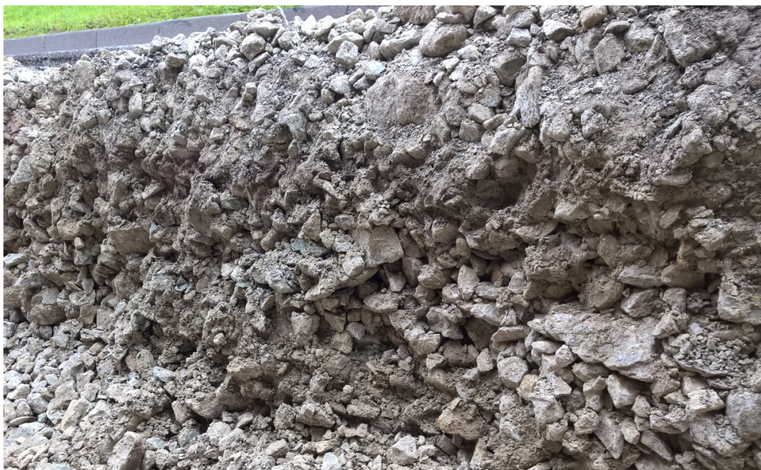
Joonis 3.69. Tammsaare teel Pärnu mnt viadukti all oli lubjakivikillustikust alus purunenud.
