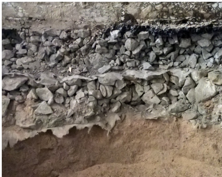
Joonis 3.59. Killustikusektsiooni ristlõige.
