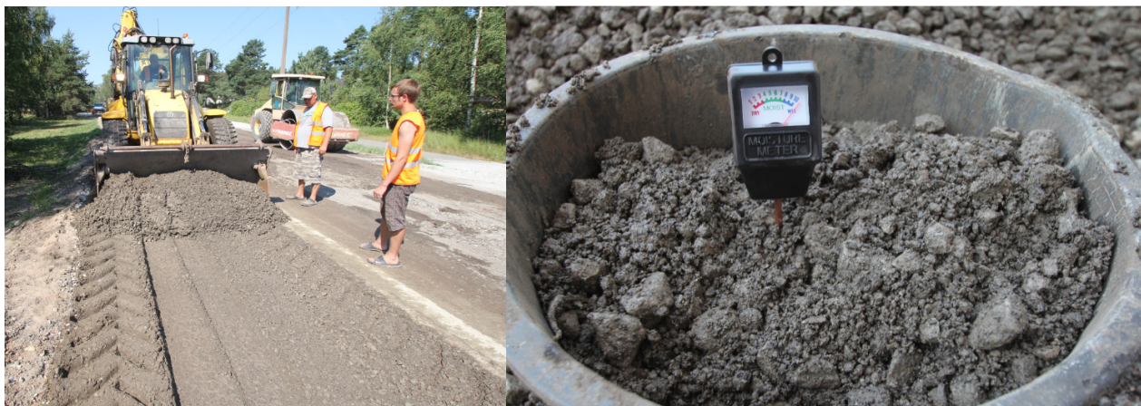
Joonised 3.9 ja 3.10. Stabiliseeritud segu hankimine objektilt ja niiskuse mõõtmine niiskusvardaga.
