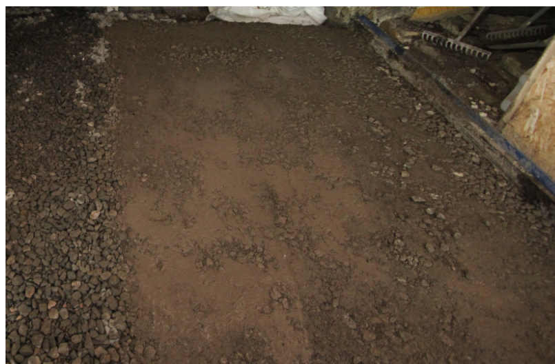
Joonis 3.13. Viimistletud ja tihendatud stabiliseeritud kiht.
