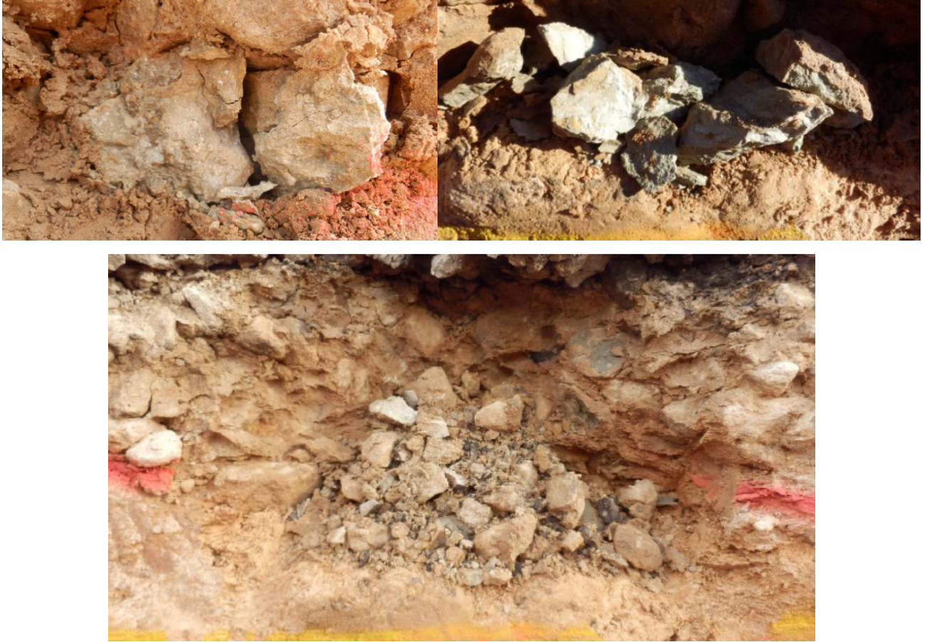
Joonised 3.65 ... 3.67. Uuringust [44] pärit fotod seoses vana killustikaluse seisukorraga.
