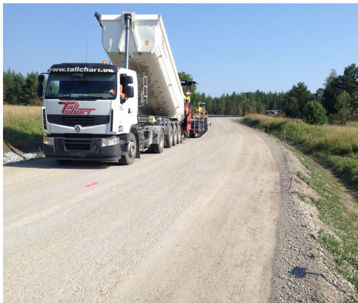
Joonis 1.15 Asfalteerimine KS32 alusele. Stabiliseeritud kihtide pinnal on alati tolmu, mis võib kahjustada asfaltbetooni naket alusega. [foto: Laas Õun]
