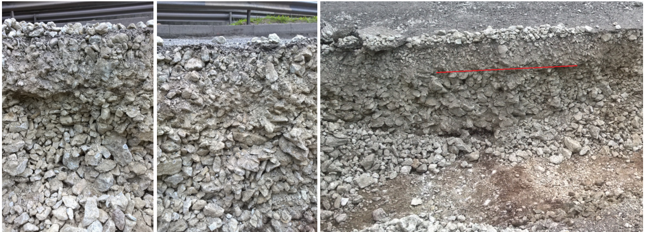
Joonised 3.70, 3.71 ja 3.72. Tammsaare tee Pärnu maantee viadukti all olnud killustikaluse ülemine osa oli väga peenosisterikas.
