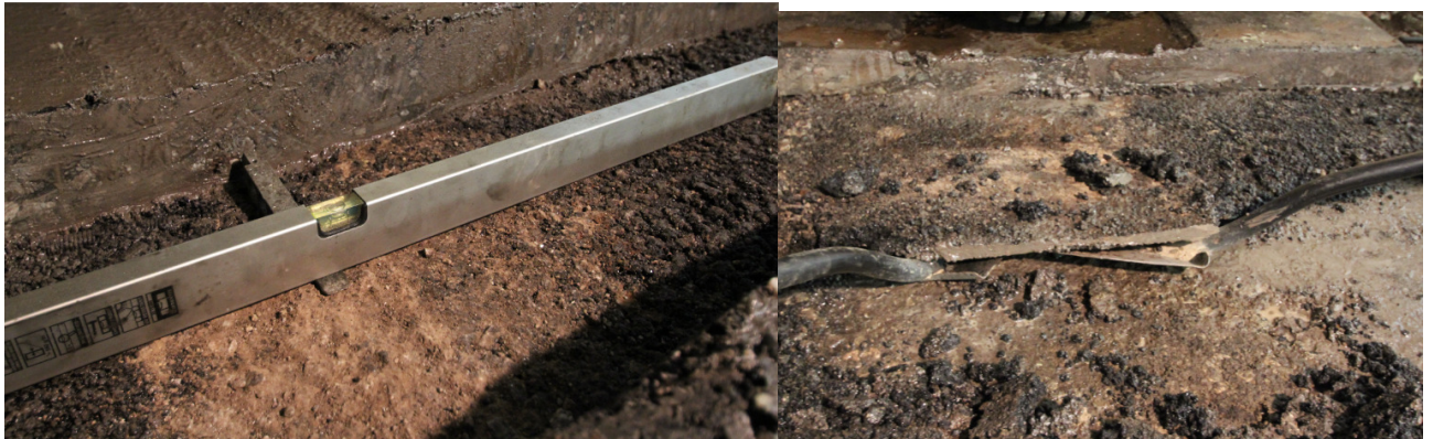
Joonised 3.50 ja 3.51. Tasanduskihi paksus oli vähenenud kuni ca 10 mm võrra.
