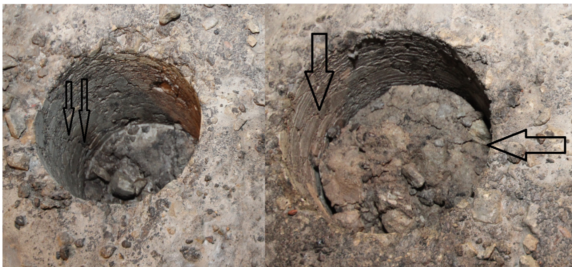
Joonised 3.57 ja 3.58. Stabiliseeritud kihti pingete leevendumisest tekkinud pragu.
