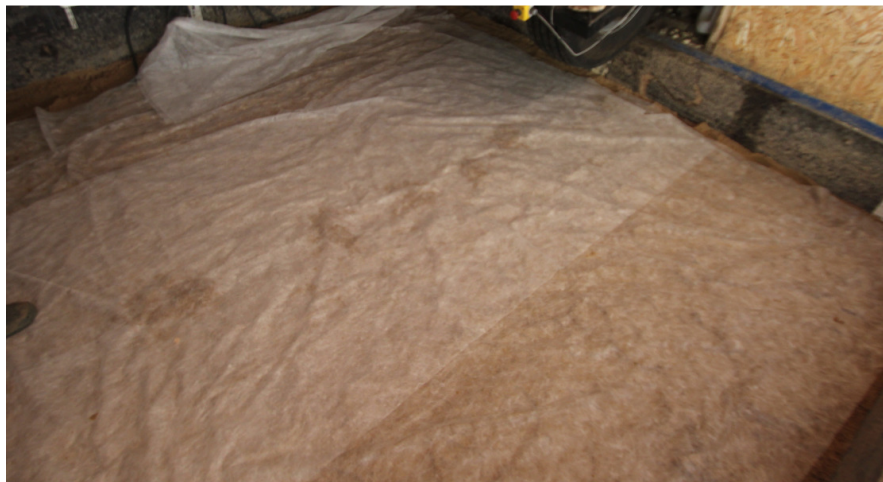
Joonis 3.17. Eraldamiseks kasutati väga kerget kahekordselt paigaldatud geotekstiili vältimaks mingilgi määral pingeolukorra mõjutamist.
