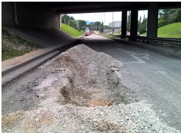
Joonis 3.68. Tammsaare teel Pärnu mnt viadukti alla kaevatud auk
