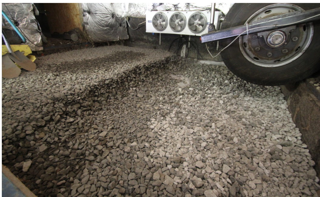
Joonis 3.8. Olukord peale killustikkihi valmimist ja enne stabiliseeritud kihi paigaldamist.
