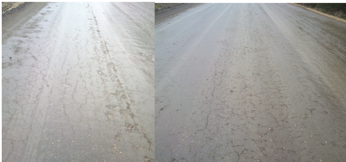
Joonised 2.1 ja 2.2. Võrkpraod kompleksstabiliseeritud kihis seoses sellega, et kihi alla jäänud teekonstruktsioonil ei olnud selle toetamiseks piisavat kandevõimet.
