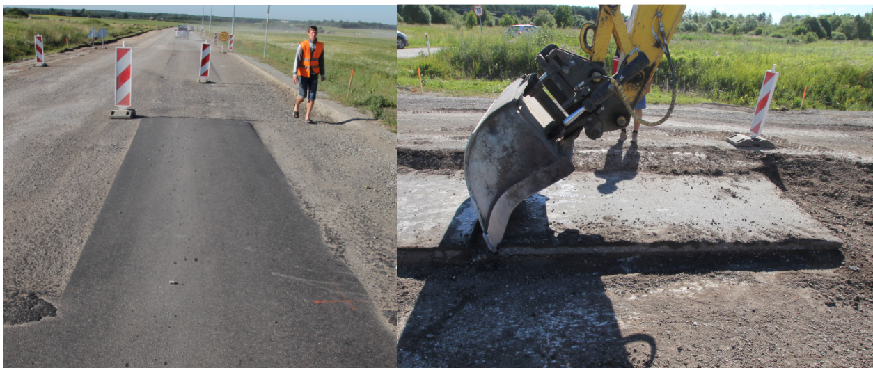
Joonised 3.1 ja 3.2. Asfaldiplaadi hankimine. Plaadi all asus KS32 kiht, mis raskendas plaadi kättesaamist.
