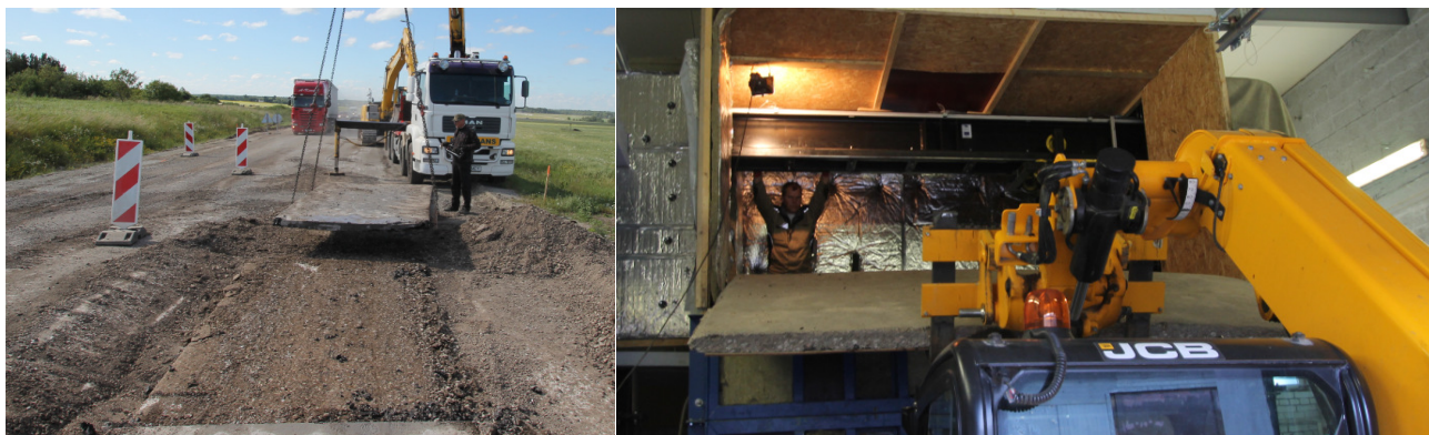
Joonised 3.2. ja 3.3. Plaat lohistati metallist plaadile, mille abil see veeti TTK labori juurde, kus sissetõtsimine toimus laaduriga.
