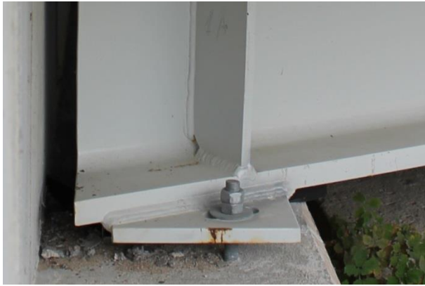
Foto 19. Kanali sild, ankrupolt ühel kaldasambal
