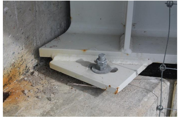
Foto 20. Kanali sild, ankrupolt teisel kaldasambal
