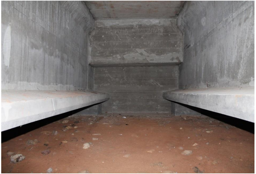
Foto 24. Kärkna sild, talad ja otsasein
