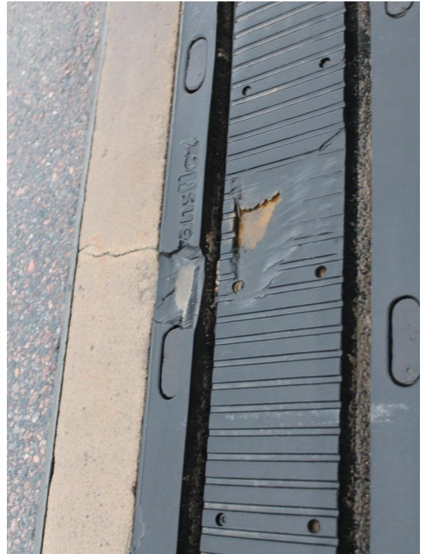
Foto 149. Kobratu sild, sahkamiskahjustused
