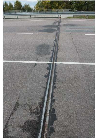
Foto 118. Kuusalu I viadukt, vuuk
