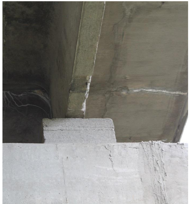
Foto 8. Ääsmäe I viadukt, avaehitus vahesambal
