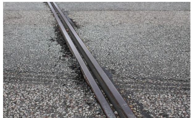
Foto 116. Kiiu I viadukt, tühimik kattes
