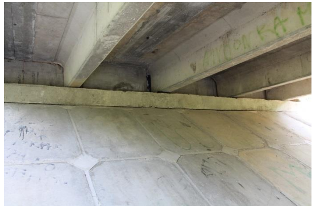
Foto 48. Puurmani II sild, talade otsad kaldasambal
