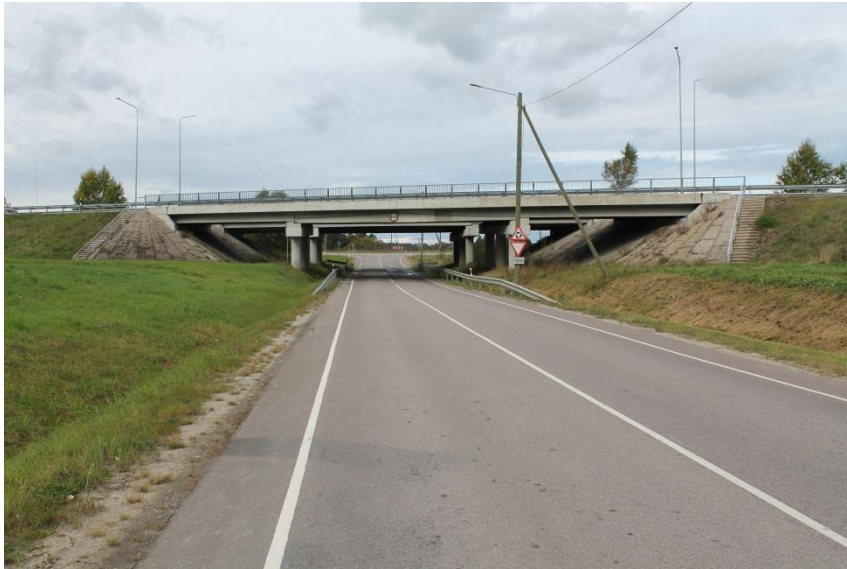
Foto 113. Kiiu I viadukt, üldvaade
