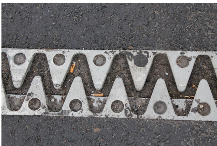
Foto 131. Variku viadukt, sodi vuugis
