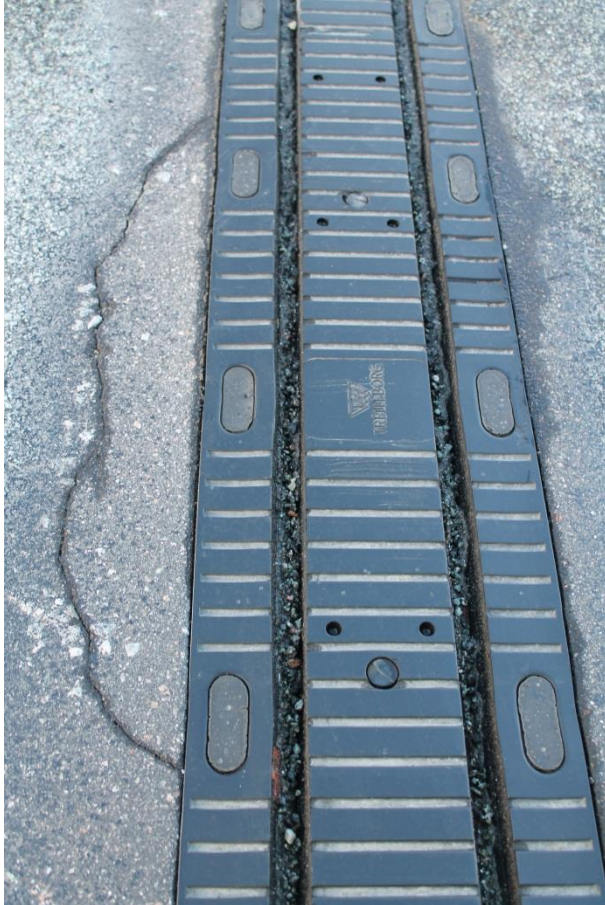
Foto 135. Kadrina viadukt, pragu üleminekuribas
