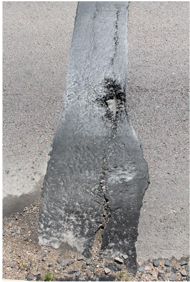
Foto 198. Elastse täitega vuuk, Šventoji jõe sild, Leedu
