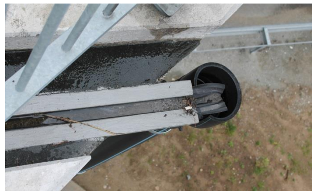
Foto 124. Luige viadukt, sademevee toru algus
