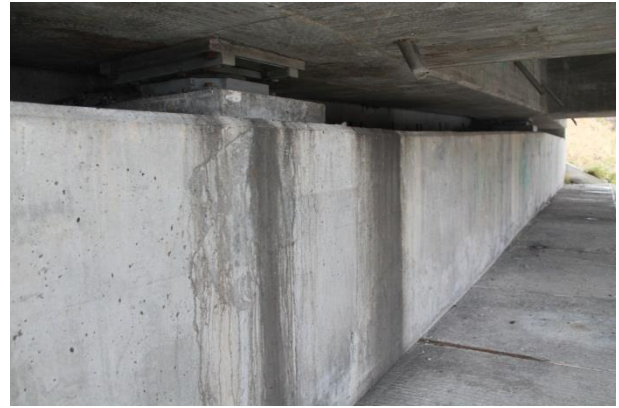
Foto 144. Kärevere III sild, vee läbijooksu jäljed
