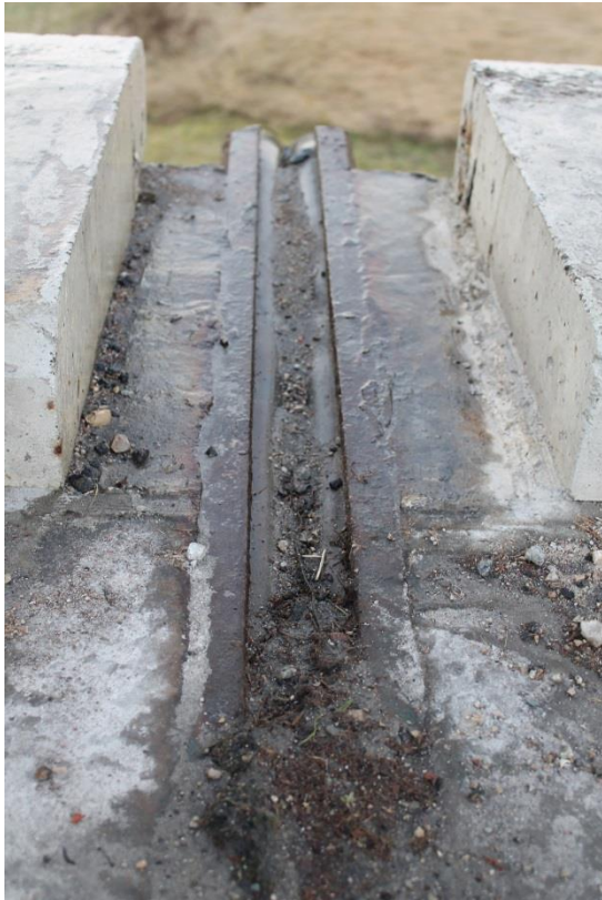
Foto 109. Kanama viadukt, sodi vuugiprofiilil
