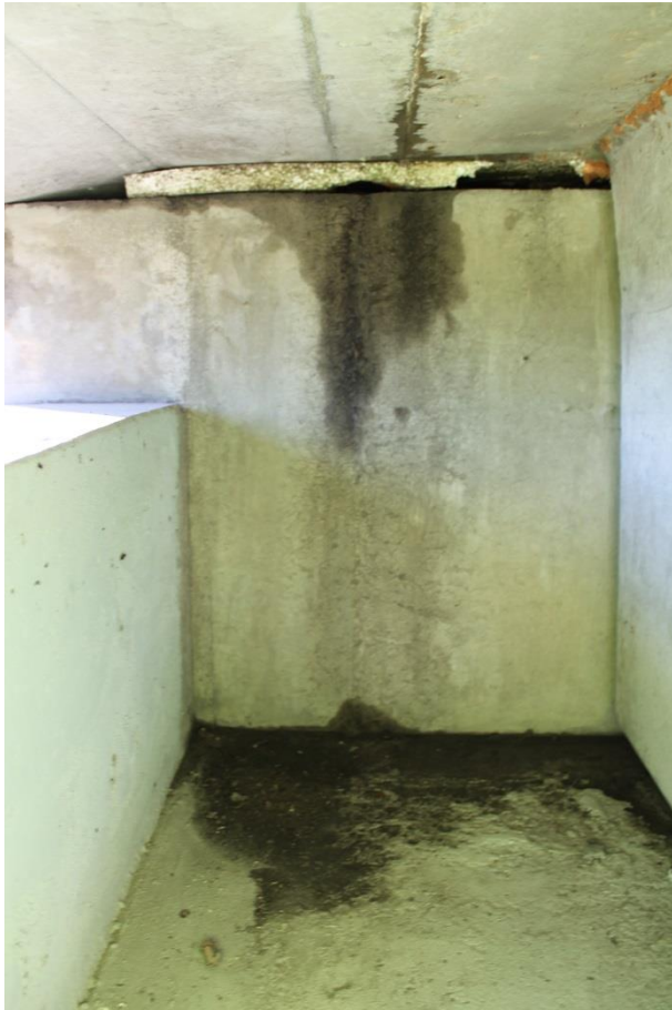
Foto 53. Sõmeru viadukt, märgunud kaldasammas
