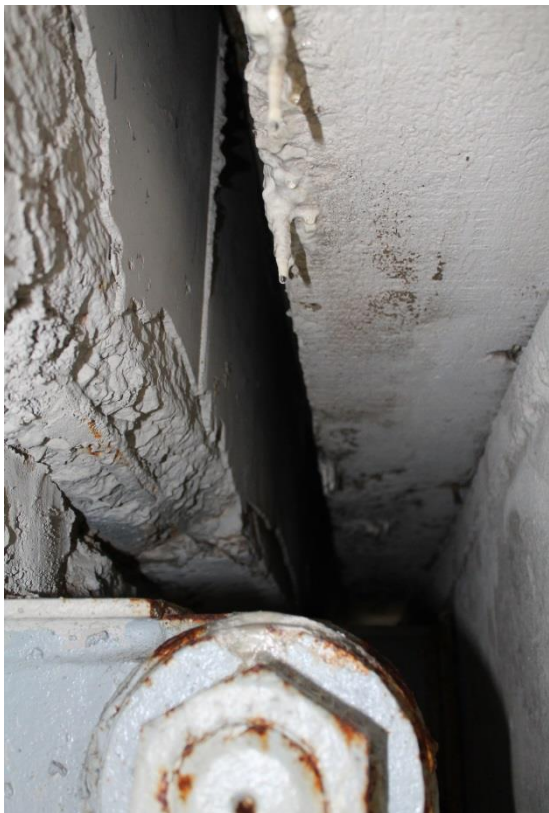
Foto 111. Kanama viadukt, vuugiava alt
