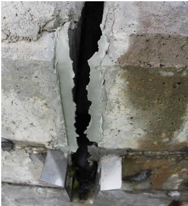
Foto 7. Ääsmäe I viadukt, servaprussi tihend
