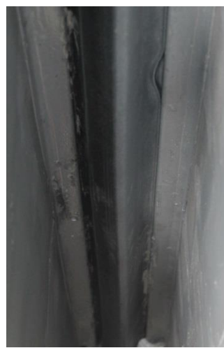
Foto 132. Variku viadukt, vuugiprofiil
