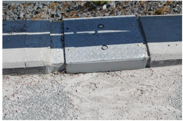
Foto 208. Katteplaat servaprussi kohal
