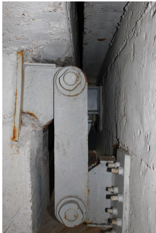
Foto 112. Kanama viadukt, tugilaager
