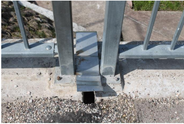
Foto 79. Röpina sild, vuugi katteplaat servaprussil
