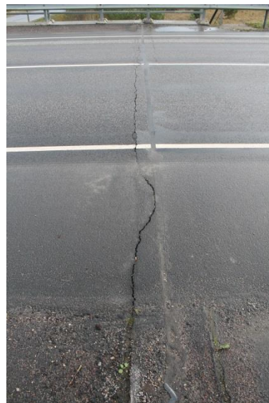
Foto 2. Ääsmäe I viadukt, vuuk
