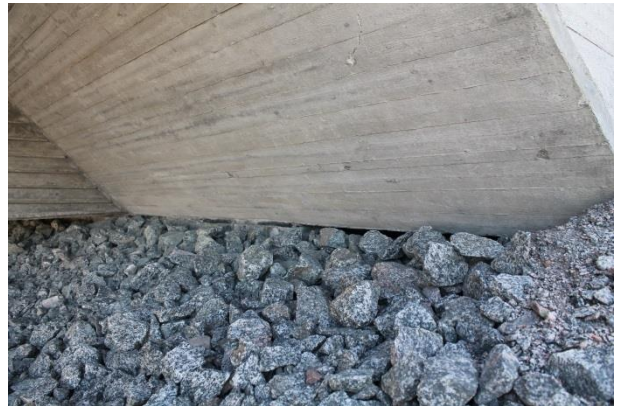
Foto 182. Pool-integraalsild Rootsis, kaldasammas
