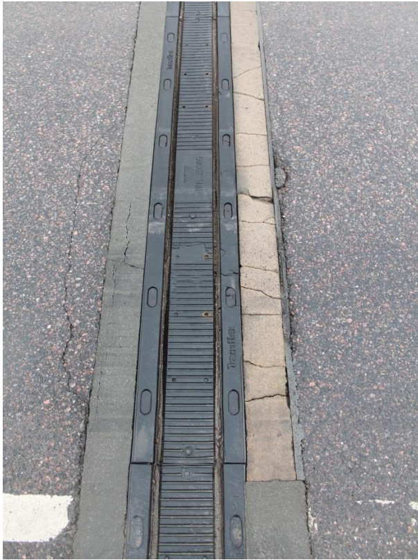
Foto 148. Kobratu sild, praod üleminekuribas ja asfaltkattes
