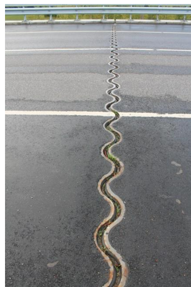
Foto 126. Riisipere viadukt, vuuk
