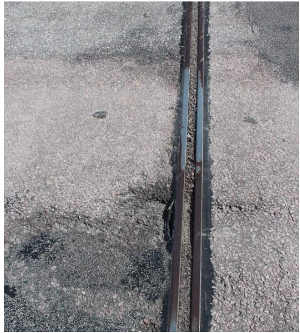
Foto 200. Avatud profiiliga teras-kumm vuuk Rootsis
