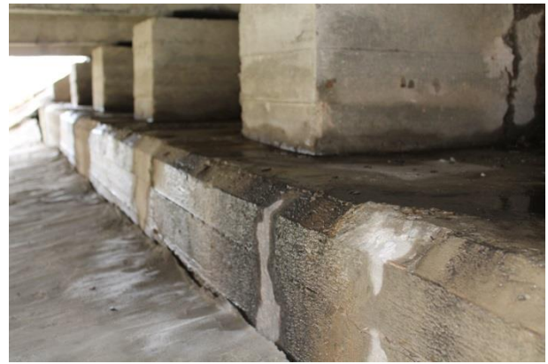
Foto 4. Ääsmäe I viadukt, kaldasammas
