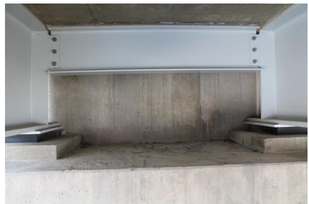
Foto 171. Purtse sild, kaldasammas ja talade otsad
