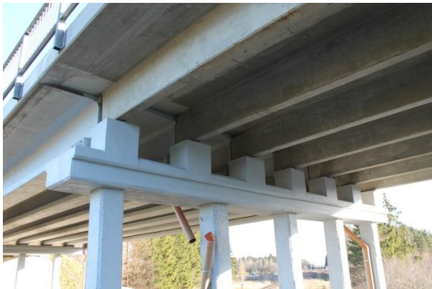
Foto 51. Sõmeru viadukt, silla vahesammas ja talad
