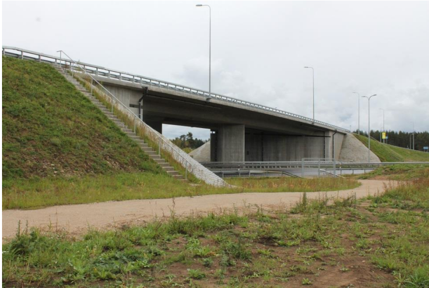
Foto 121. Luige viadukt, üldvaade
