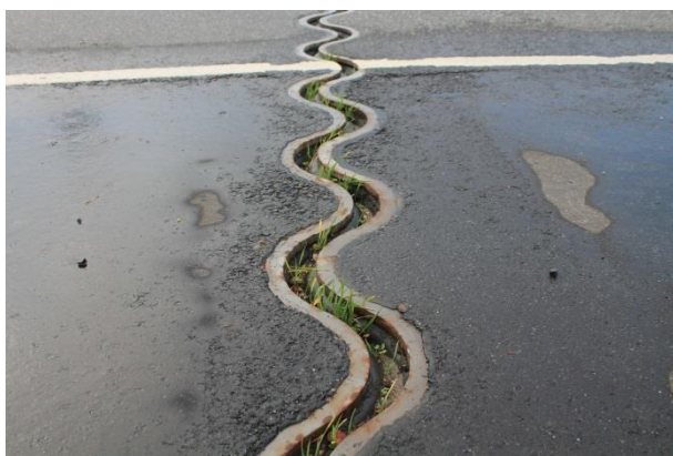
Foto 127. Riisipere viadukt, vuuk
