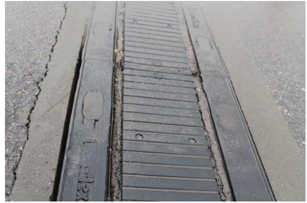
Foto 142. Kärevere III sild, vahe üleminekuriba juures
