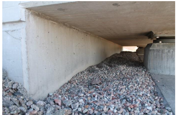
Foto 184. Pool-integraalsild Rootsis, kaldasammas
