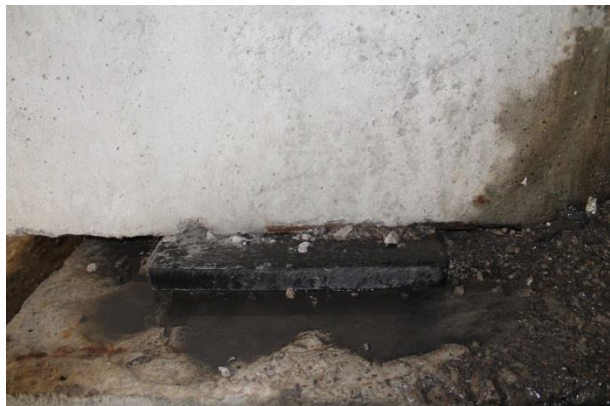
Foto 13. Jõgisoo I sild, tugilaager kaldasambal
