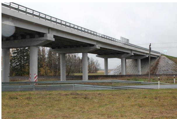
Foto 133. Kadrina viadukt, üldvaade
