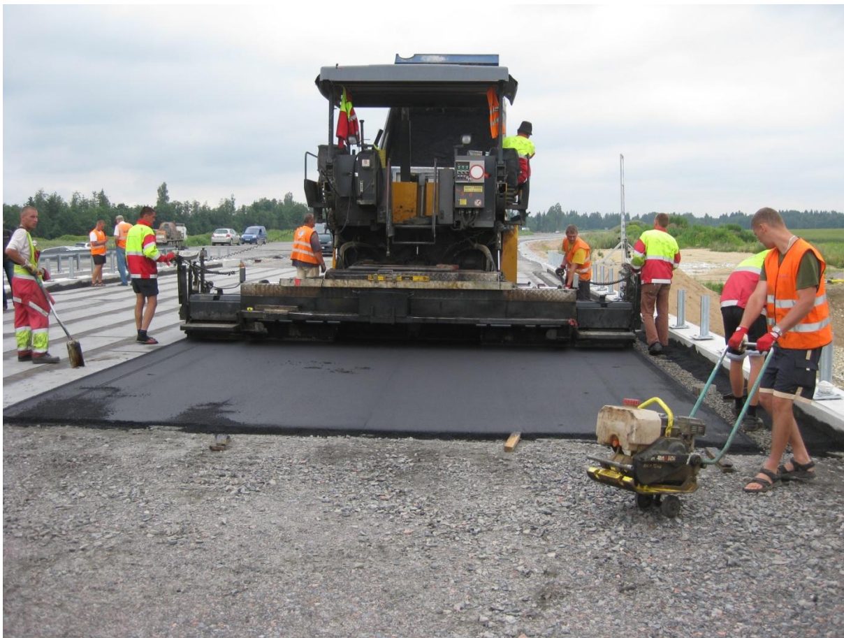
Foto 18 – Liivasfalt paigaldatakse asfaldilaoturiga
