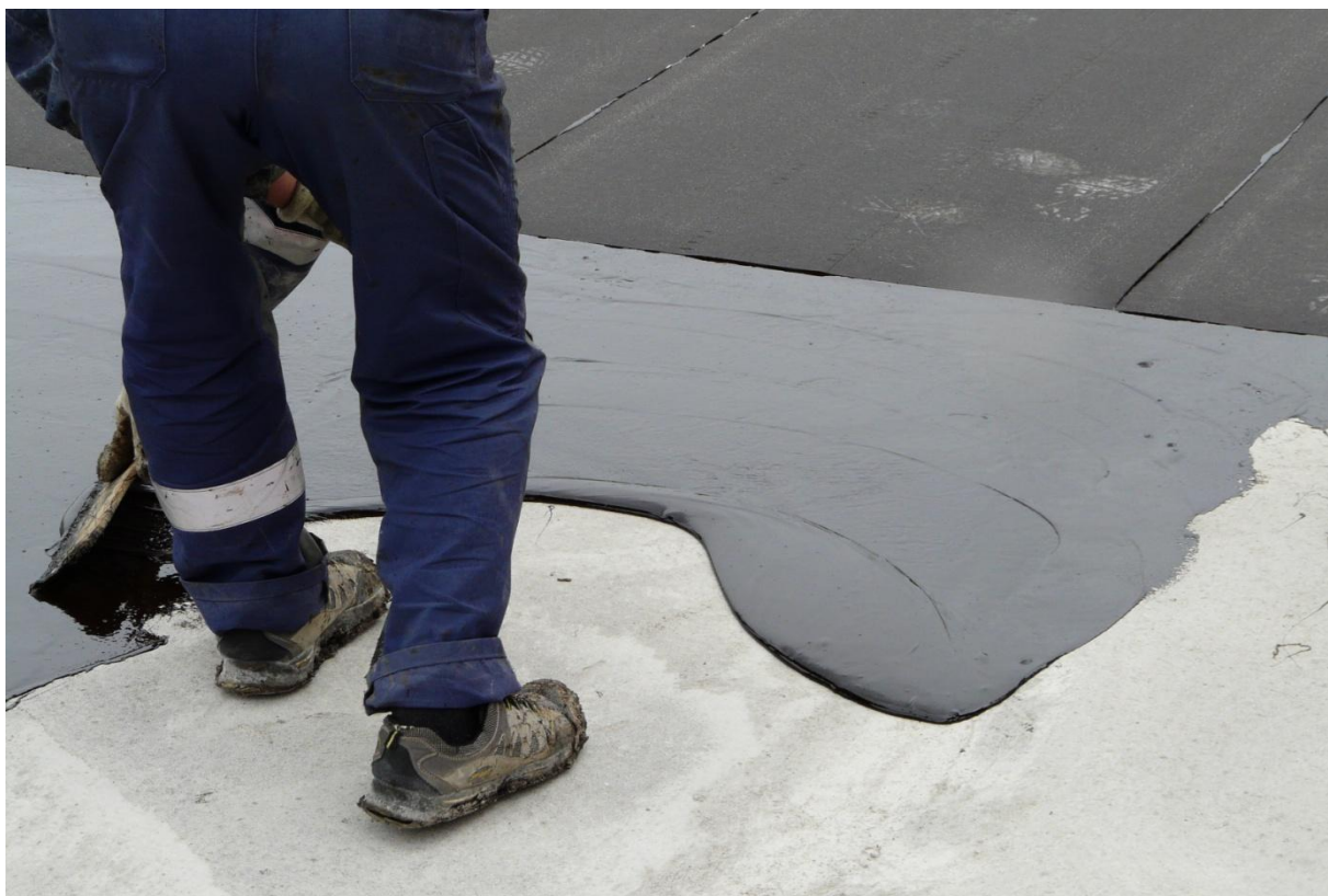
Foto 14 – Vedelmembraani kaitsetahvliga võib paigaldada kohe puhastatud aluspinnale
