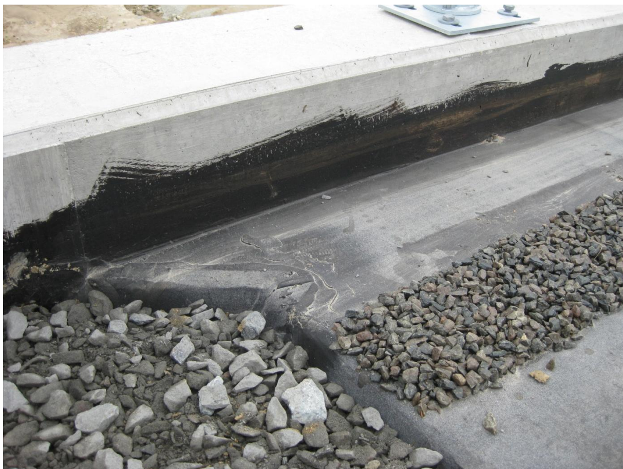
Foto 15 – Servapruss isoleeritakse bituumen- või epoksiidkrunti peale vööbates
