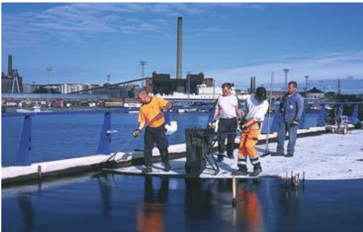
Foto 7 – Mastiksfalti on Eestis sillateki hüdroisolatsiooniks vähesel määral kasutatud.
