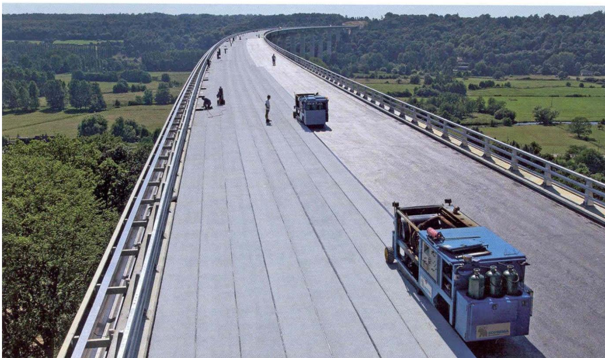
Foto 23 – Masinaga paigaldatakse kuni 200 m pikkuseid rullmembraane
