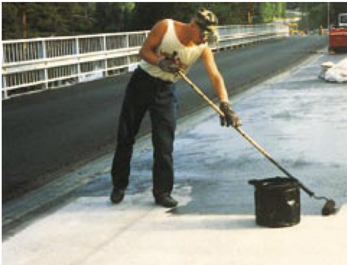
Foto 13 – Nakke parandamiseks tuleb aluspind kruntida
