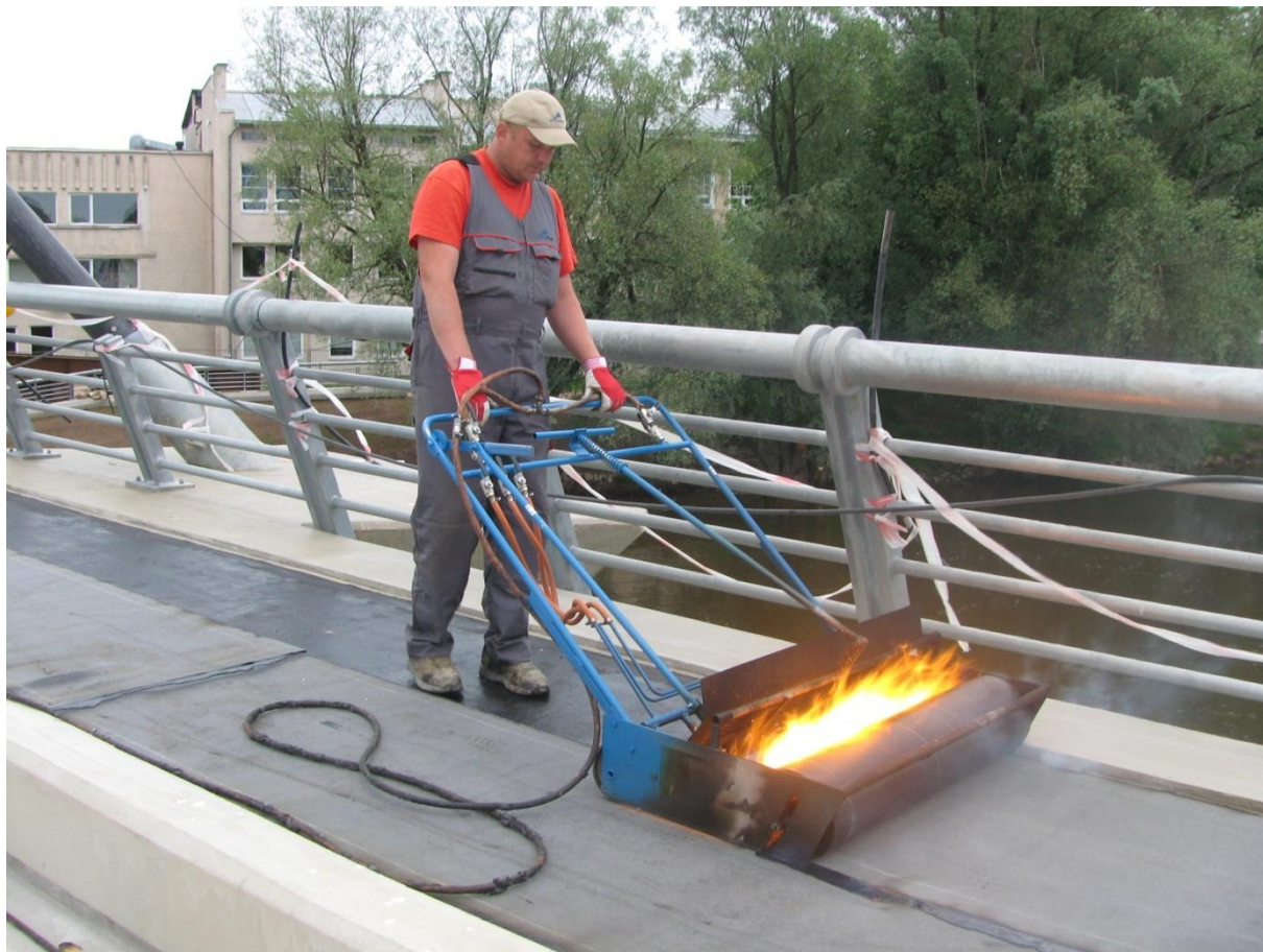
Foto 9 – Rullmaterjal sulatatakse aluse külge, kasutades mitme düüsiga propaanpõletit
