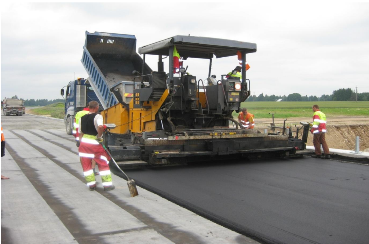
Foto 19 – Kuum labidas võib läbi hüdroisolatsiooni sulada
