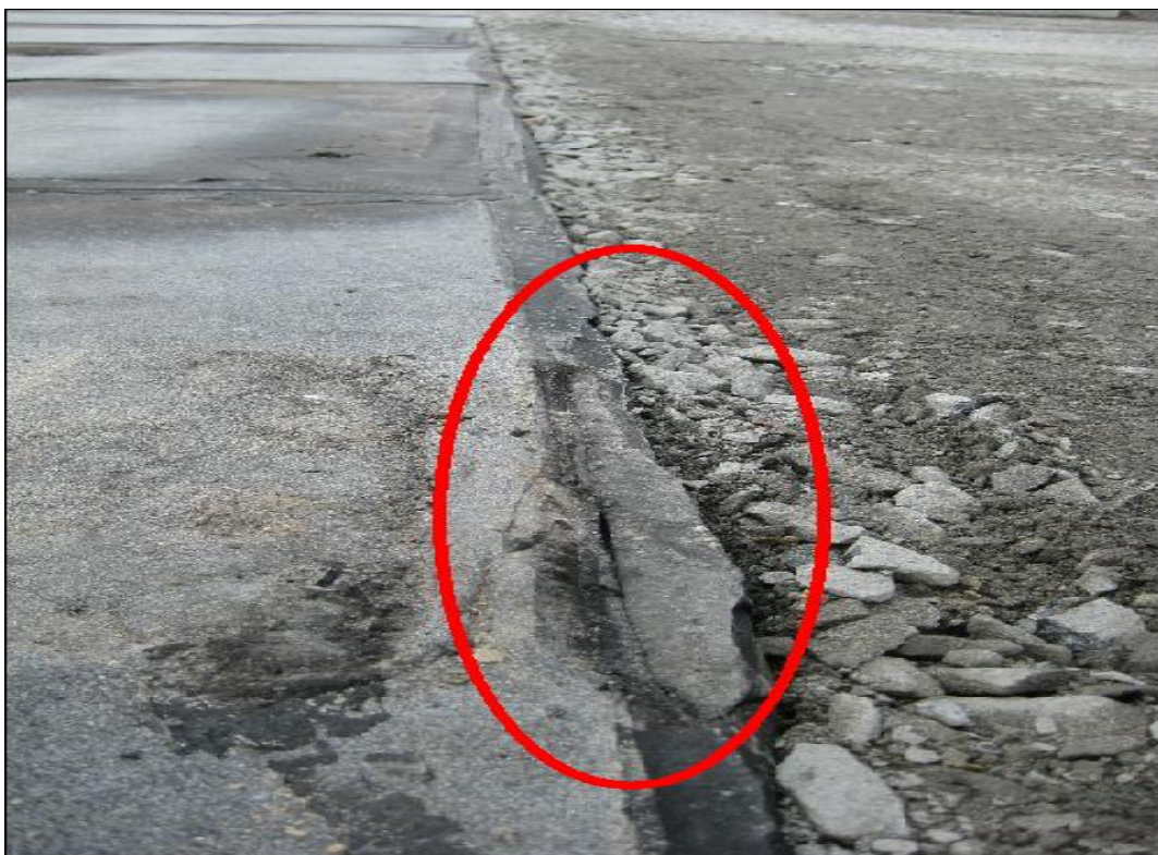
Foto 20 – Asfaldilaotur võib kahjustada hüdroisolatsioonimaterjali
