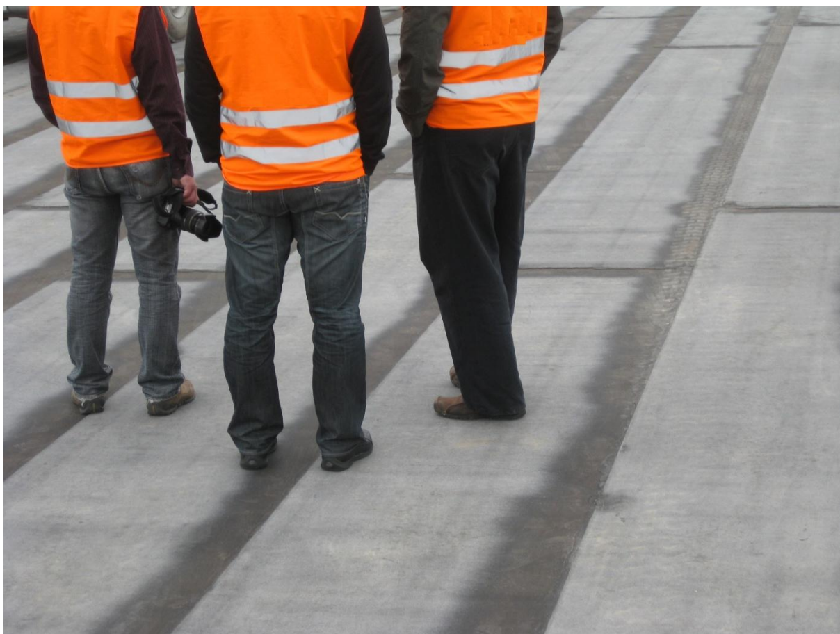
Foto 17 – Peale hüdroisolatsiooni puhastamist ei tohiks peale paigaldajate keegi sillal viibida
