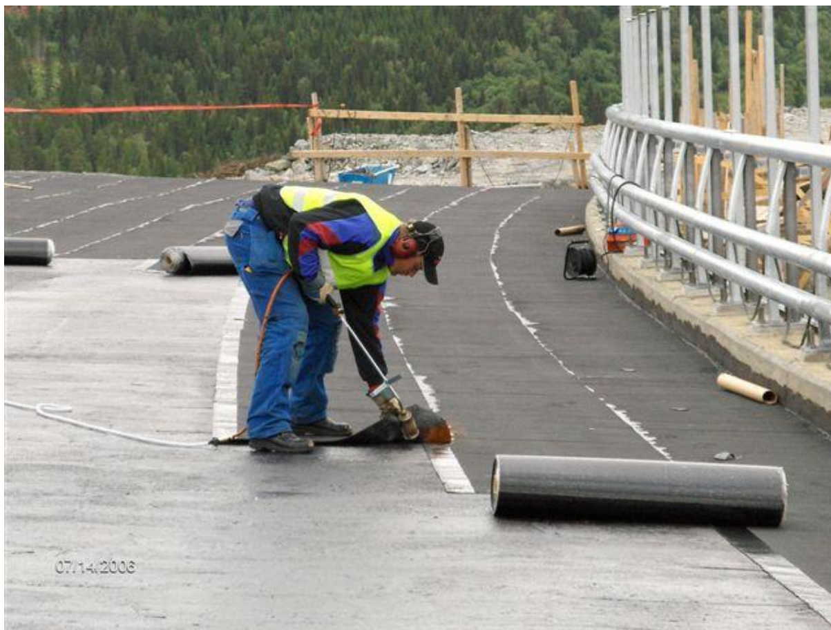
Foto 10 – Ühe düüsiga propaanpõletit kasutatakse väiksemate tööde korral
