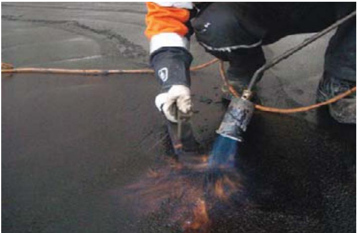
Foto 21 – Mastiks- ja valuasfaldi töövuugid kuumutatakse ja tihendatakse kummibituumeniga
