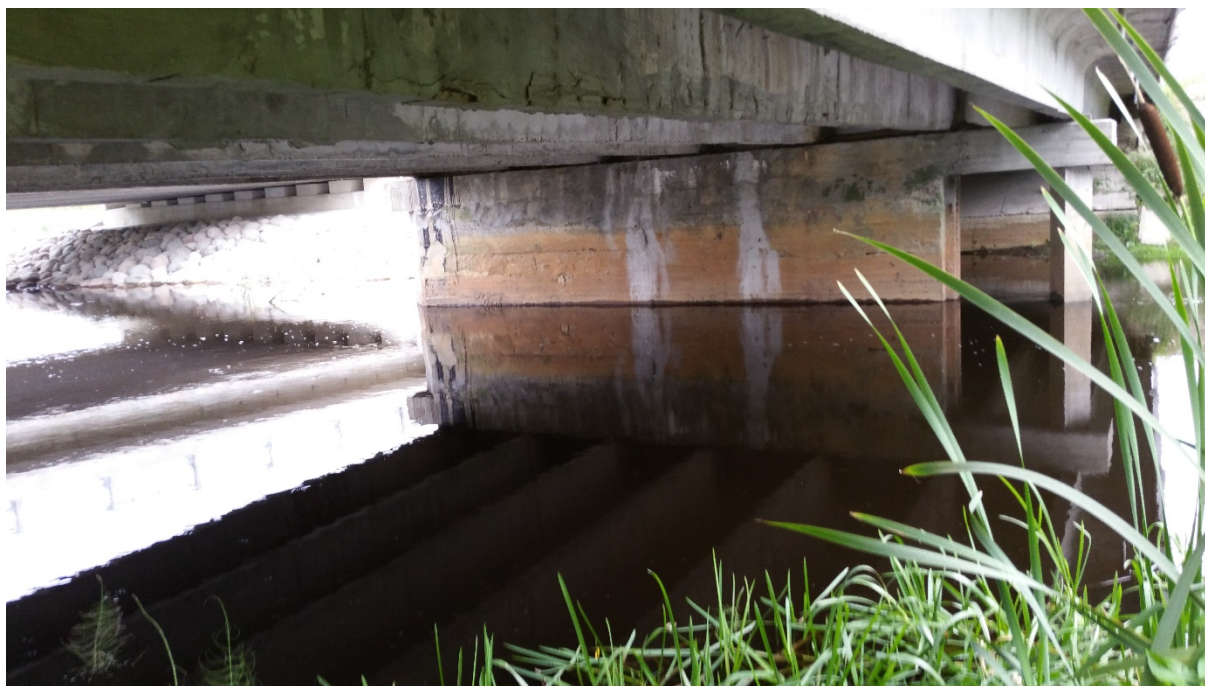
Joonis 3. Särevere silla Türi poolse ava dekiehitus. Mõõdistus 23. september 2015.
