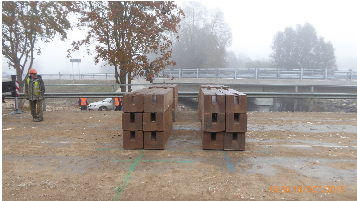
Joonis 21. Koormus N-30, kahe kõrvuti seisva 30t auto tagumised teljed Särevere silla esimesel aval
