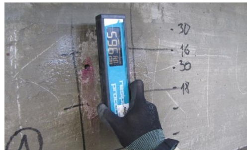
Foto 26. Armatuuri korrosioonitaseme mõõtmine seadmega Proceq Resipod
