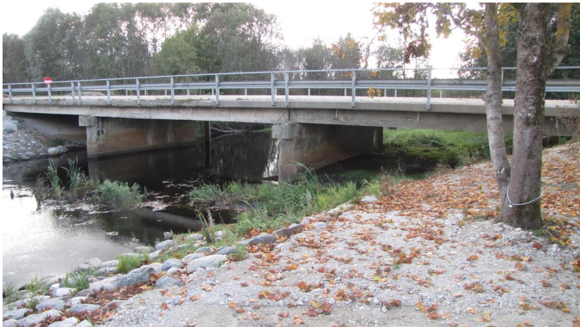
Foto 3. Vaade vanale Särevere sillale
