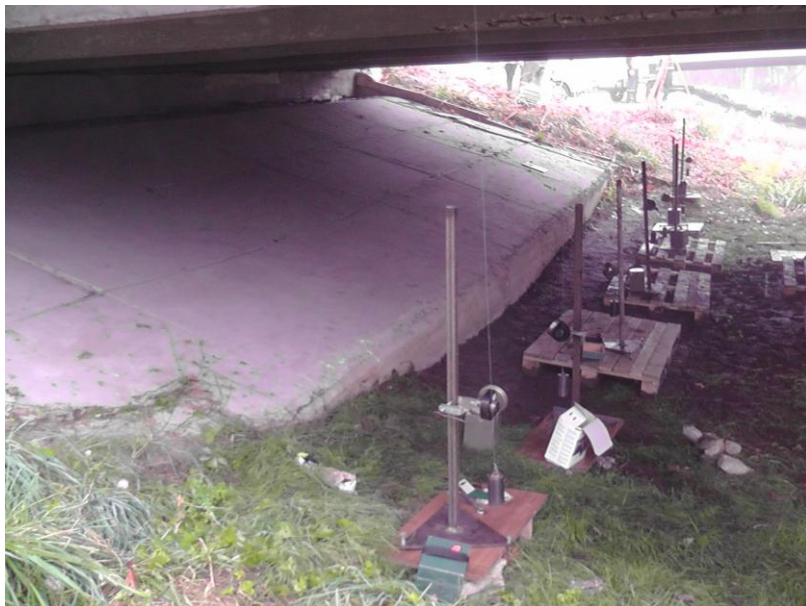
Joonis 30. Särevere silla äärmise ava taladele keskohta kinnitatud mõõtekellad.
