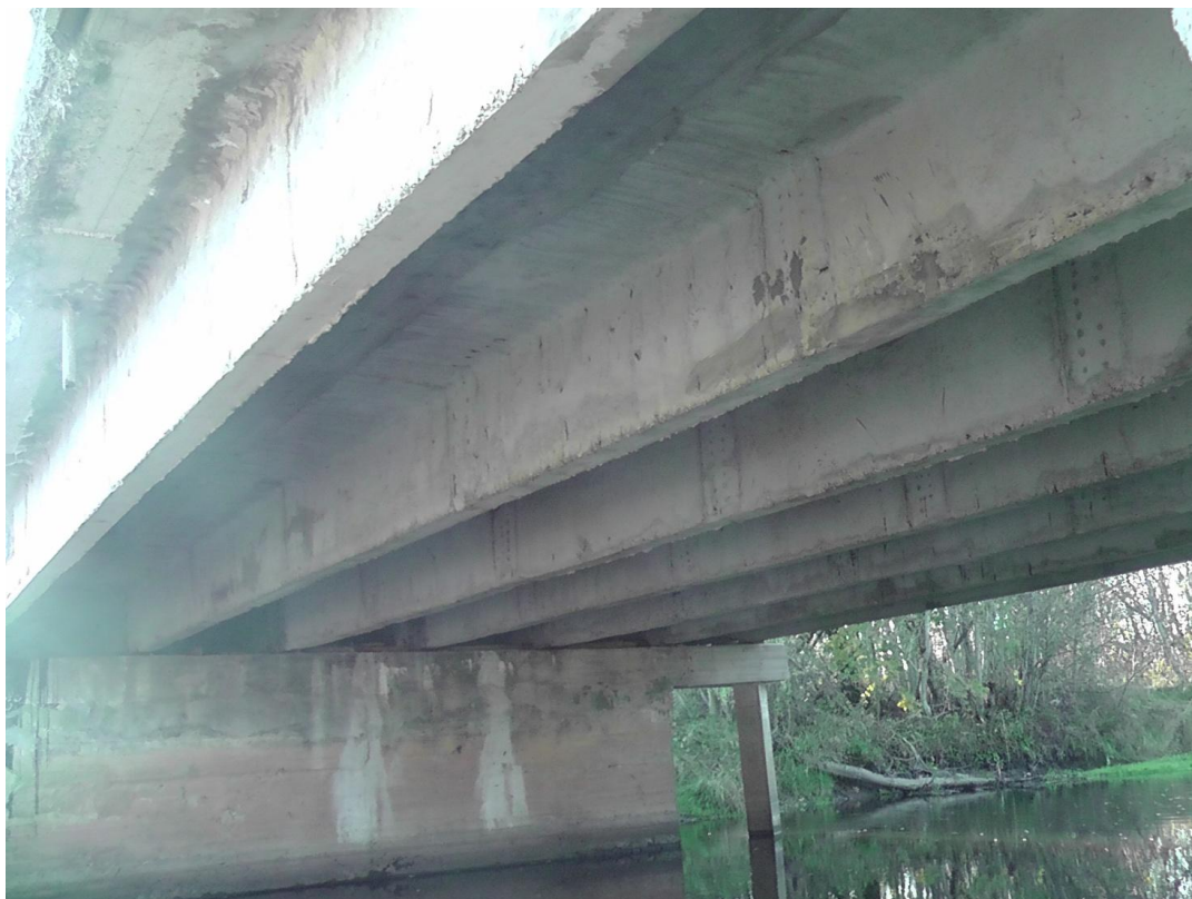
Joonis 24. Silla keskmise ava talad
