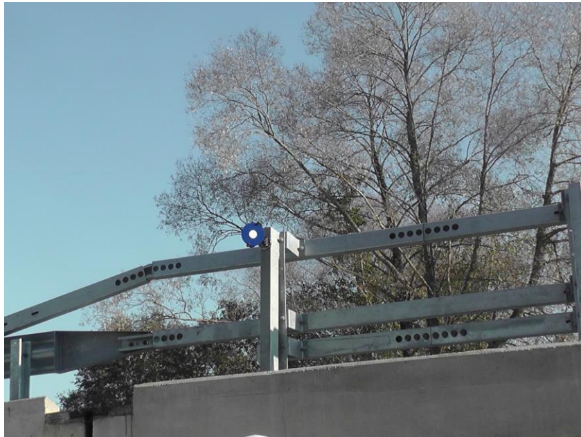
Joonis 26. Magnetallustega skaneerimistäht t1 kinnitatuna uue silla piirdekonstruktsioonile
