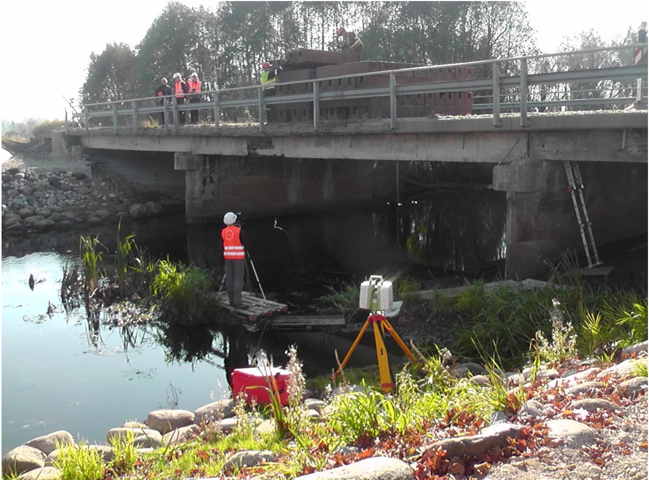
Joonis 6. Katsetatav Säreve maantee sild, esimesel katsetuspäeval on metallkoormused laotud silla keskmise ava kohale idapoolsele sõidurajale. Vaade läänesuunda, esiplaanil laserskaneerimise seisupunkt
