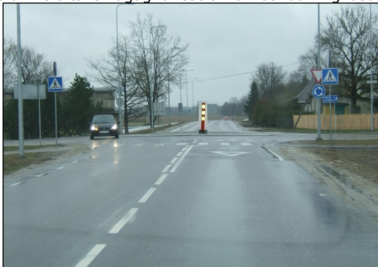
Foto 18. Miniring Sakus. Lm 544 varjab ringristmikust teavitavat liiklusmärki 424. Sõidukijuhi vaateväli ei ole „läbi lõigatud“, teekattel on näha väga palju hädapidurduse jälgi, nagu ka selgeid märke ringi keskosast üle sõitmisest.
