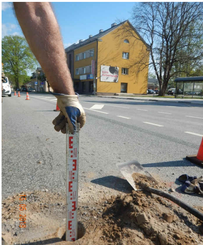
Foto 19. Türi II RR puurauk
