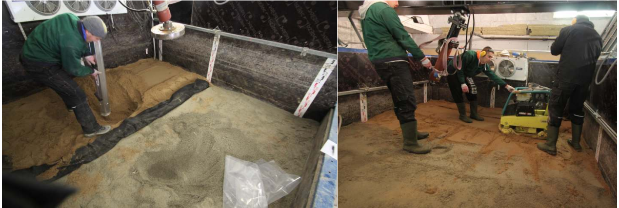
Fotod 11 ja 12. Paesõelmed ja kvartslüiv eraldatü üksteisest geotekstiiliga. Muldkeha oli jagatud katsekeha pikisuunas täpselt pooleks. Tihendatid 255kg vibroplaadiga ja tihedust kontrolliti Inspectoriga. Autor Sven Sillamäe
