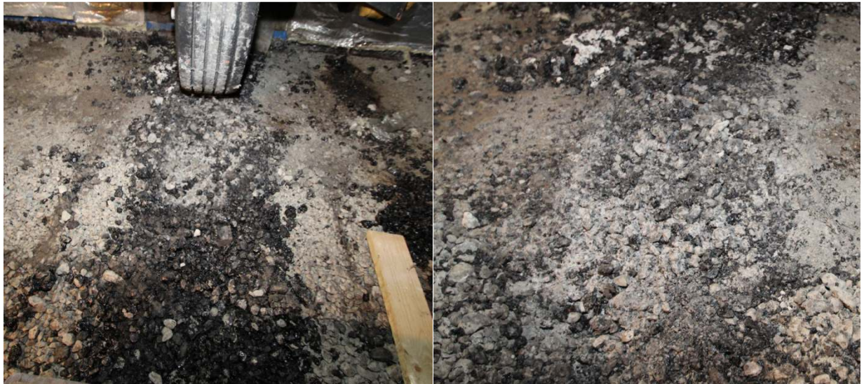
Fotod 44 ja 45. Dūnaamiline koormus ja vesi on pesnud 0...32 killustikust peenosise kõrvalolevasse 16/32 peale ja asfaltkihi vahele. Autor Sven Sillamäe
