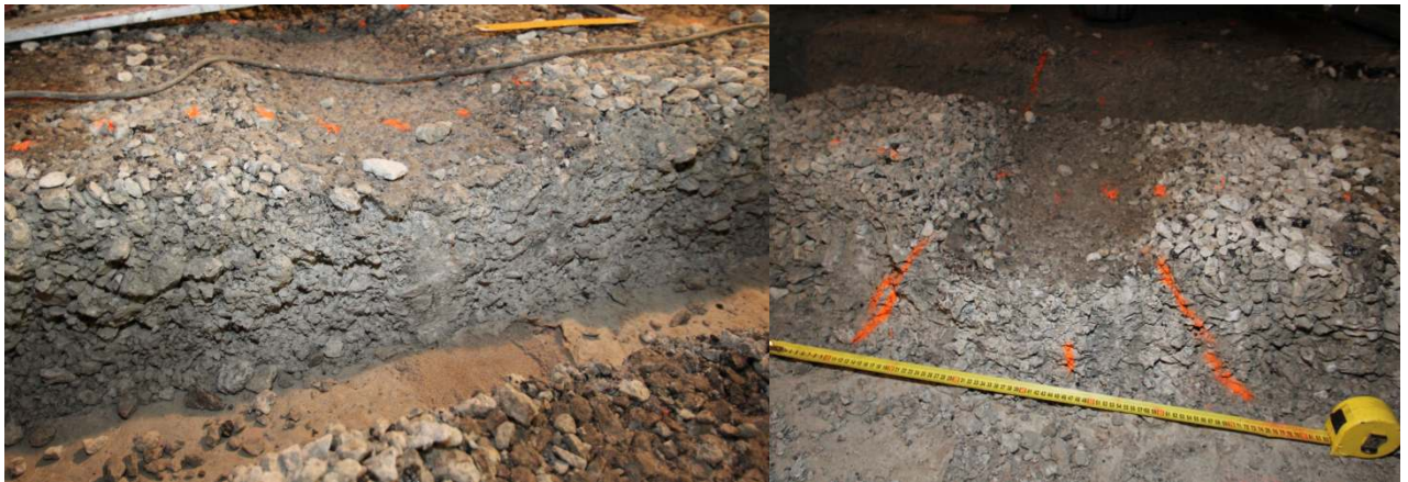
Fotod 34 ja 35. Fotod killustike 4...32 ja 16/32 pealt. Autor Sven Sillamäe
