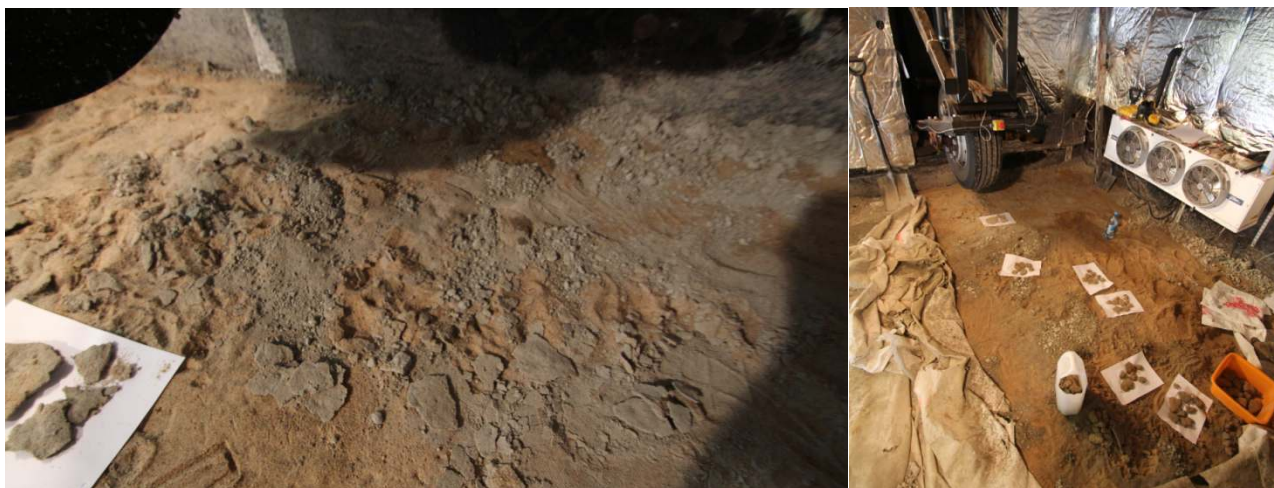
Fotod 40 ja 41. Tolm, mis oli settinud killustikukihtide alla. Autor Sven Sillamäe
