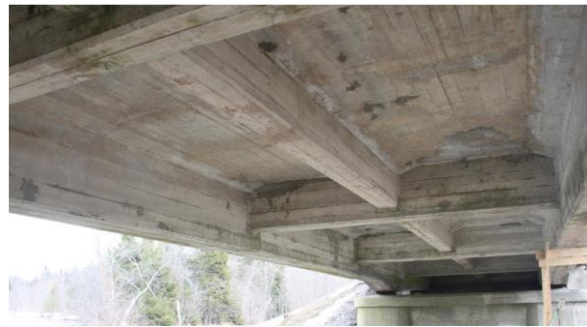
Foto 2. Loobu II silla altvaade peataladele ja tekiplaadile [10]
