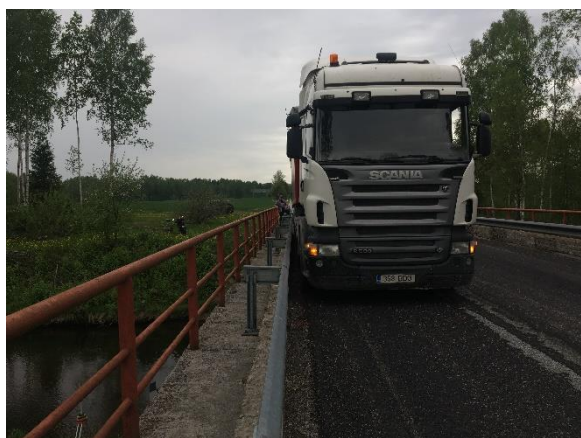
Foto 4. Piibe silla katsetamine
