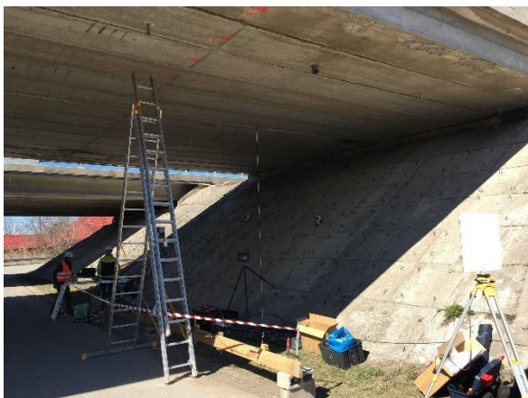
Foto 5. Jõgisoo II silla (äärmine ava) katsetamine
