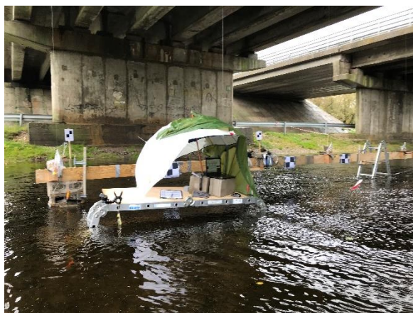
Foto 6. Jõgisoo I silla katsetamine
