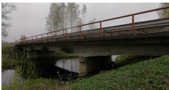
Foto 53. Konsoolidega talasildadel osutuvad probleemiks suured paindemomendid peatalade tugele
