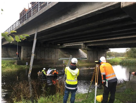
Foto 4. Jõgisoo I silla katsetamine
