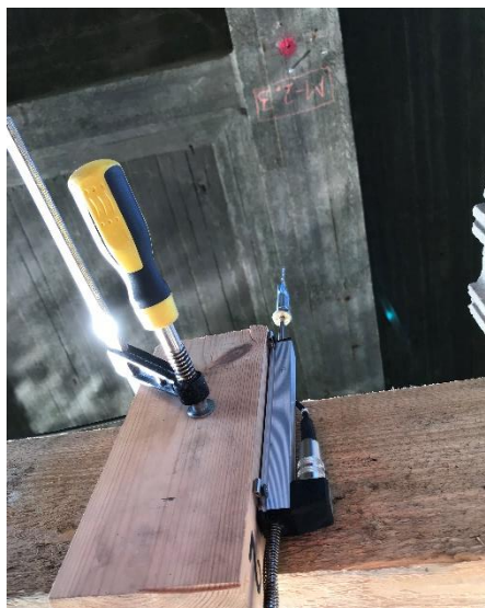
Foto 35. Siirdeanduri ühendamine talaga
