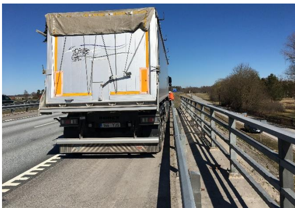
Foto 3. Jõgisoo II silla (äärmine ava) katsetamine
