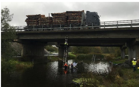
Foto 1. Jõgisoo I silla katsetamine
