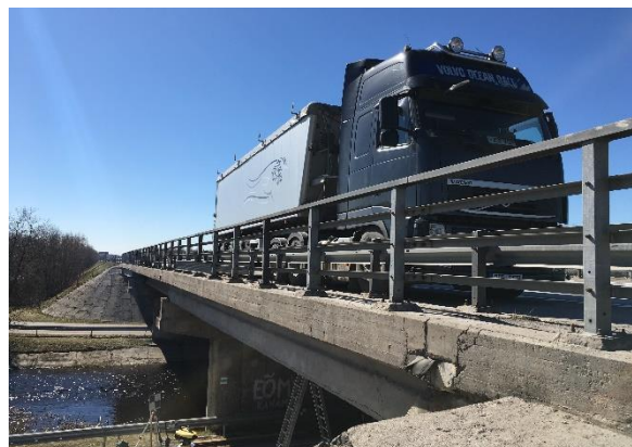
Foto 4. Jõgisoo II silla (äärmine ava) katsetamine
