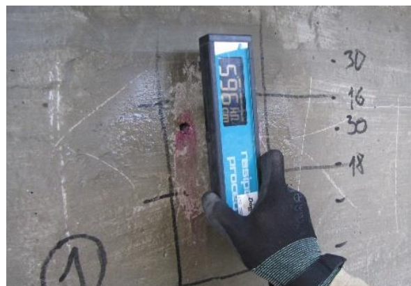
Foto 52. Armatuuri korrosioonitaseme mõõtmine seadmega Proceq Resipod
