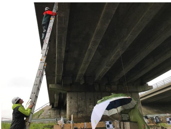
Foto 5. Jõgisoo I silla katsetamine
