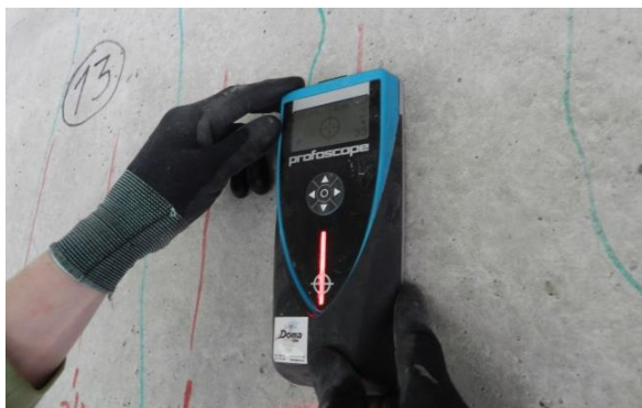
Foto 49. Terasarmatuuri paiknemise, betoonist kaitsekihi ja terasarmatuuri läbimõõdu määramine seadmega Proceq Profoscope+
