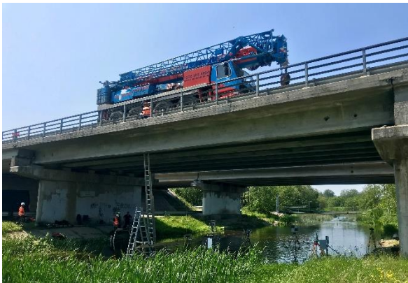
Foto 3. Jõgisoo II silla (keskmise ava) katsetamine
