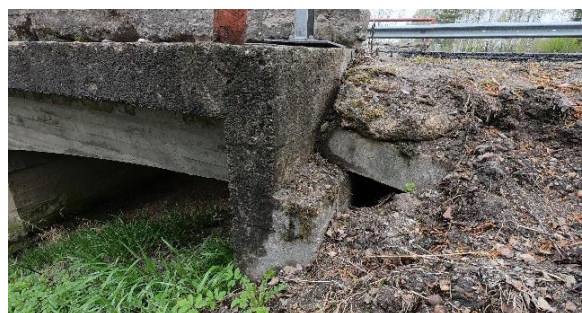
Foto 54. Pinnase äravajumine konsooli otsa piirkonnas (pealesõiduplaadi alt)
