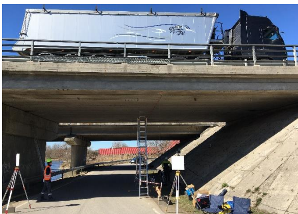
Foto 1. Jõgisoo II silla (äärmine ava) katsetamine
