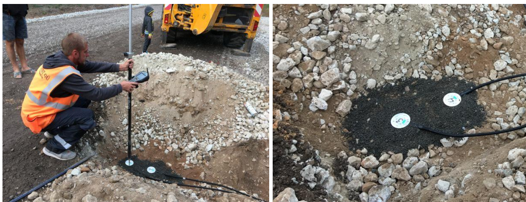
Joonis 11. Surveandurite paigaldus ja nende asukoha fikseerimine.
