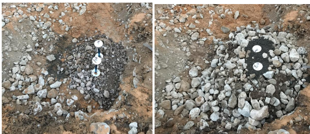
Joonis 12. Deformatsiooniandurite paigaldus killustikalusesse.
