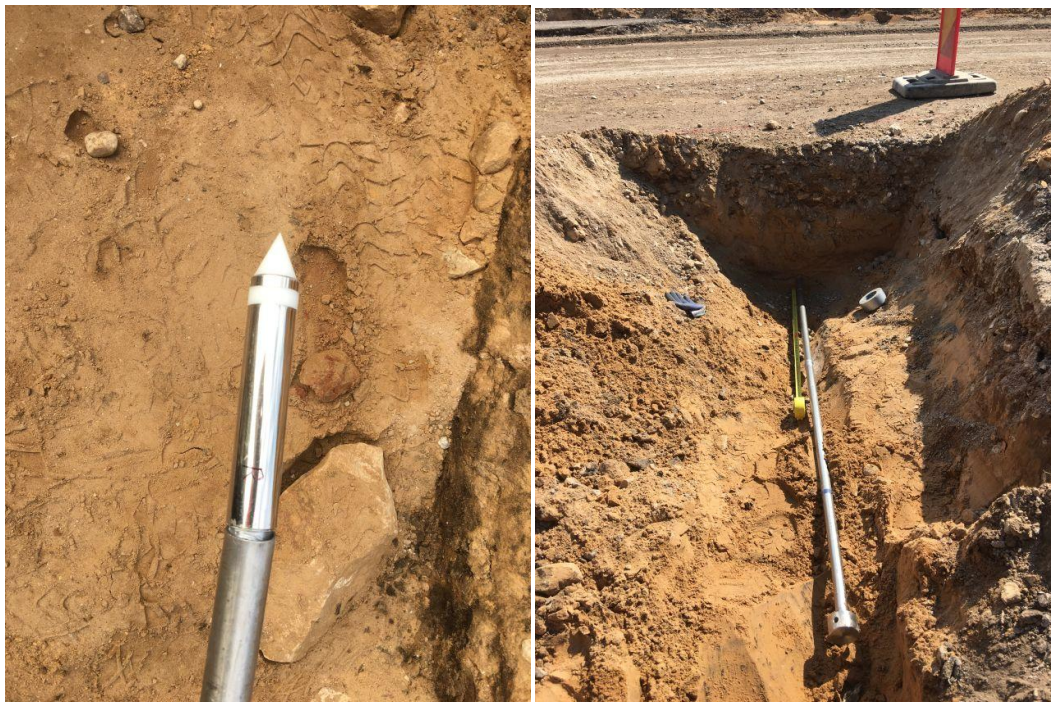
Joonis 10. Percoandur ja selle paigaldus (km 7.5)
