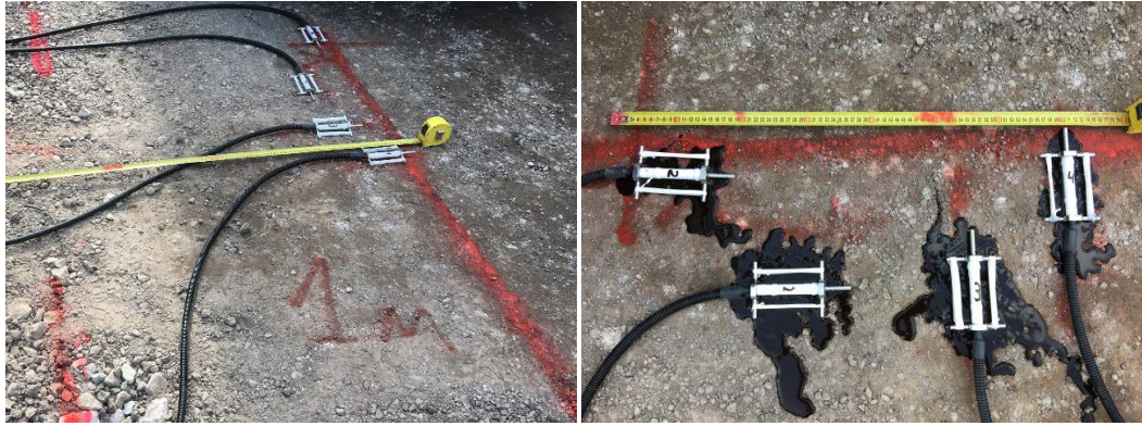
Joonis 13. Tõmbeandurite paigaldus asfaltkatte alla.
