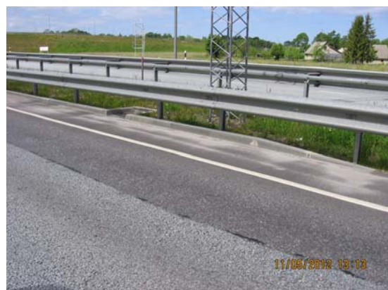
Foto 9. Remonditud koht PK 66 juures püsib korras
