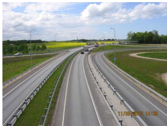
Foto 17. Üldine seisukord, vaade Jõhvi ristmiku viaduktilt
