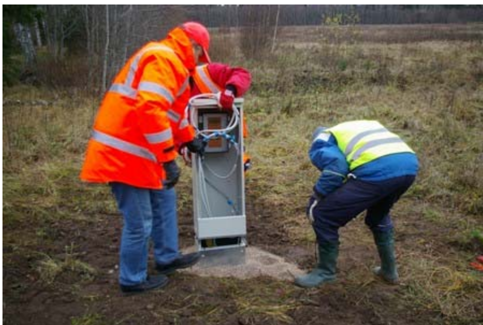
Percostation mõõtejaama seadmete kapi paigaldamine
