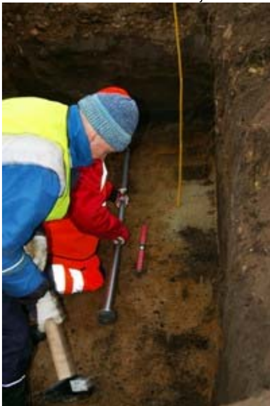
Percostation jaama horisontaalsete andurite paigaldamiseks avause tegemine
