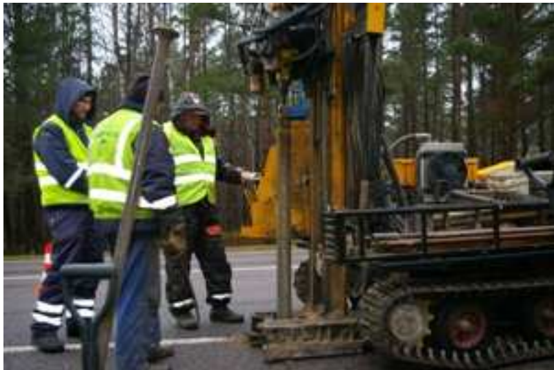
Pilt 5. Valjala temperatuurianduri paigaldamine, puuraugu puurimine
