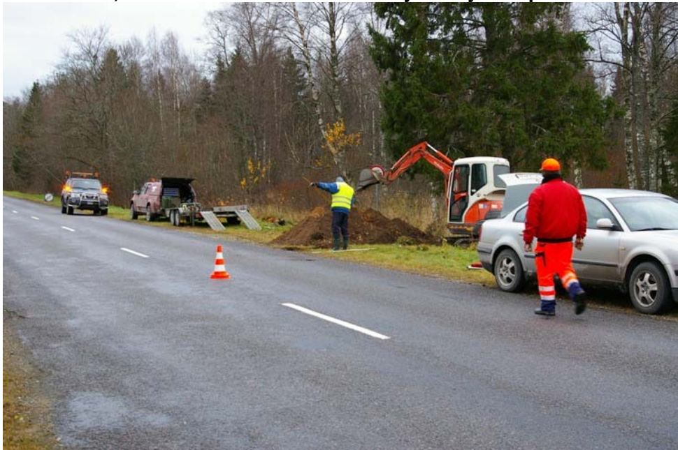
Kaeviku kaevamine Percostation jaama horisontaalsete andurite paigaldamiseks
