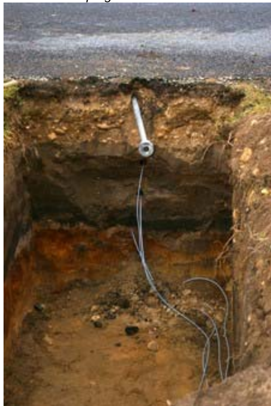
Percostation jaama horisontaalsete andurite paigaldamine
