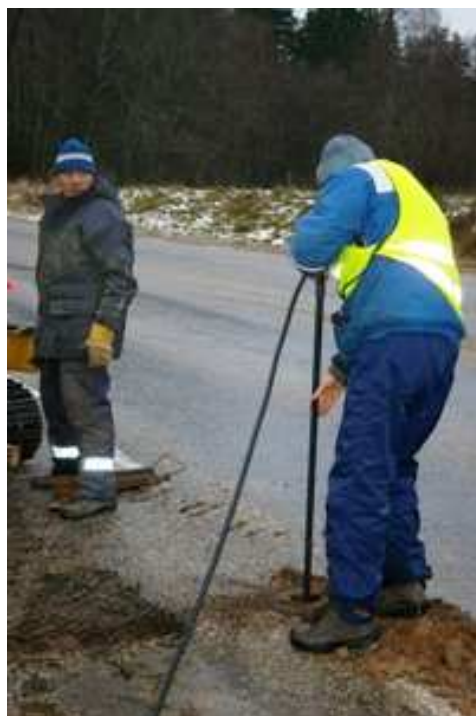
Pilt 3. Vertikaalse temperatuurianduri paigaldamine (Karisilla temperatuuriandur)
