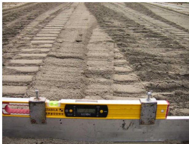
Foto 3 Kalde mõõtmine paekiviliiva katselõikudel
