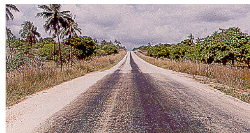
Teelõik, kus Otta pindkatte kivimaterjaliks kasutati korallkivi. Esimene lõik on olnud kasutusel mõned kuud - kivimaterjal on kinnistunud, moodustades meeldiva ja ühtlase välimuse. Teine lõik on värskest ehitatud – korallkivimaterjal vajab veel aega kinnistumiseks. Enam kui 14 kasutusaasta järel näevad need lõigud välja suurepärased. (Keenia).
