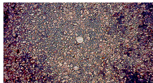
Ülaltoodud Otta pindkatte sulgunud poorid. Pöörake tähelepanu tihedale pinnatekstuurile, mis moodustab veekindla katte. (Lõuna-aafrika).
