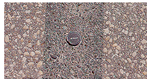
Otta pindkate liivpuistekihiga, kus tihe mastiks on tõusnud kõrgemale. (Botswana).
