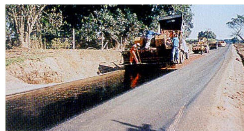
Otta pindamise katsetöö, kasutatud suure tolmu sisaldusega purustatud kvartskivimaterjali. Kivimaterjal laotati iseliikva laoturiga. (Lõuna-Aafrika).
