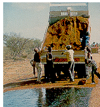
Kohalike teede programmi raames kasutati Otta pindamist laialdaselt ning kombinatsioon käsitsitööga. Otta pindamise kivimaterjalina kasutatud looduslikku porsunud graniiti sõeluti ja kasutati käsitsi. (Botswana).
