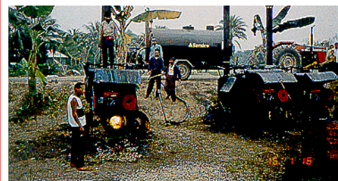
Vedeldamine sideaine viskoossuse ja omaduste parandamiseks on võimalik isegi "primitiivsetes" tingimustes. (Bangladesh).
