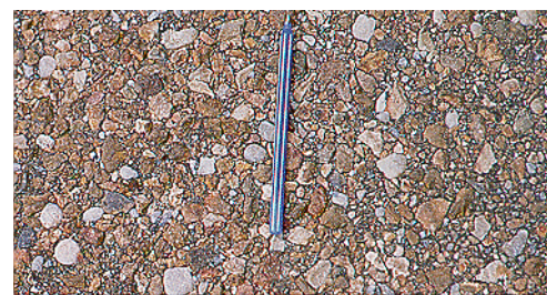
Ridakillustikust skeleti pooride sulgumine Otta pindkattes. Pange tähele tihedat mastiksit ja kiilumist. (Botswana).
