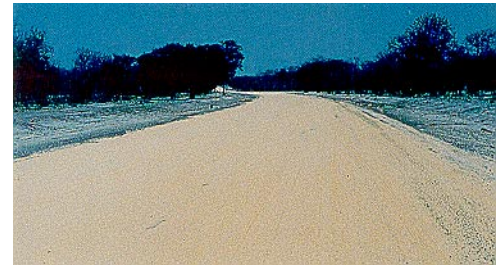
Liiva liia kasutamine on oluline, kui ühekordne Otta pindkate kaetakse liivpuistekihiga. (Botswana).
