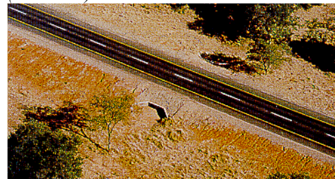
Sama tee, mis ülal, linnulennult. Pöörake tähelepanu meeldivale ühtlasele välimusele - parem kui asfaltbetoon. (Botswana).
