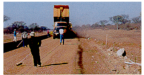
Otta pindamistööde teostus. Küllaldane kivimaterjali hulk on oluline, et sideaine saaks ülespoole tõustes katta kõik osakesed. (Botswana).
