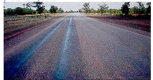
Mõningane leemendamine paiguti ja rattajälgedes on formeerumisprotsessis normaalne nähtus. Tugevat leemendmist saab parandada liiva või täiendava kivimaterjali rullimisega leemendavale alale. (Botswana).
