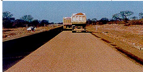
Pneumorullide puudumisel või neile lisaks võib tihendamiseks edukalt kasutada koormatud veoautosid, vastavalt eelnevalt määratletud rullimismudelile, haarates kogu pinnatud ala. (Botswana).
