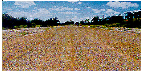
Otta pindkate 2 – 3 päeva pärast ehitamist, kus kohe pärast ehitust lubati peale katte moodustumisele kaasaaitav liiklus. (Botswana).
