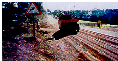
Ulatuslik rullimine pneumorullidega on heade tulemuste saavutamiseks oluline. (Lõuna-Aafrika).
