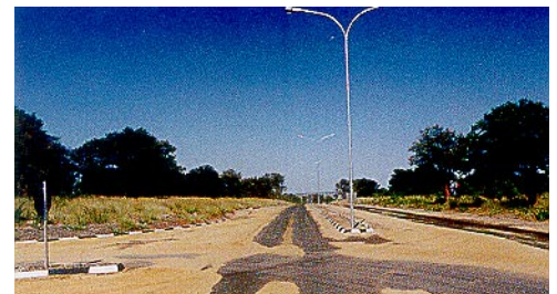
Liiklusega ärapuhutud liiv tuleks harjata tagasi kogu pinnale, kuni on saavutatud täielik kinnistumine. (Botswana).
