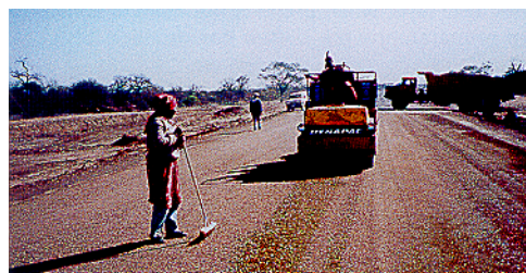
Üks käik staatilise tandemrulliga parandab jämedama killustiku kinnistumist. (Botswana).
