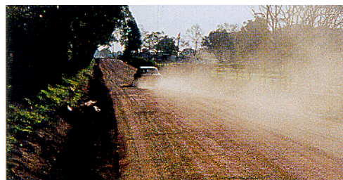
Värskest laotatud, kõrge peenosiste sisaldusega Otta pindkate tolmab esimesed 2 – 4 nädalat. (Lõuna-Aafrika).
