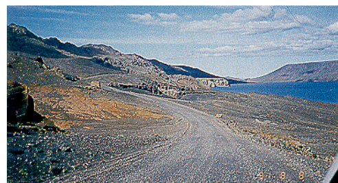
Värske Otta pindkate purustatud basaltkruusast. (Island).
