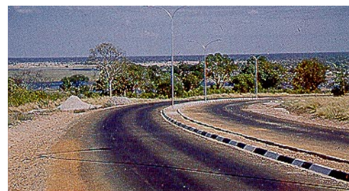
Valmis tee pärast 8 kuud kasutust, ühekordne Otta pindkate (purustatud kivimaterjal) kaetud Kalahari liivast puistekihiga. (Botswana).
