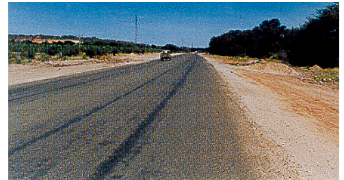
8 – 10 nädala pärast (sõltuvalt liiklusest) on Otta pindkate formeerunud ja näeb välja nagu eelsegatud segust asfaltbetoon. (Botswana).
