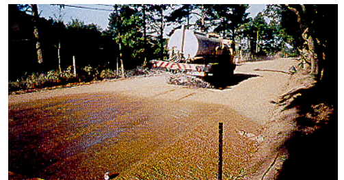
Puhitud aluse kerge kastmine veega enne sideaine pihustamist parandab sidet aluse ja Otta pindkatte vahel. (Lõuna-Aafrika).
