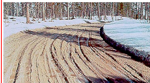
Katteta teede võrk oli Norras kuuekümnendate algul halvas seisukorras. Sula perioodil olid teed sageli läbitamatud nii kergetele kui ka rasketele sõidukitele. (Norra).
