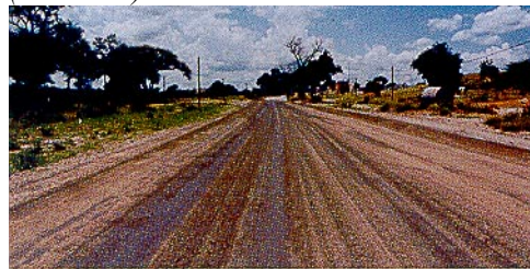
Killustik, mis on liikluse mõjul välja löödud, tuleks rattajälgedesse tagasi harjata. See kindlustab killustiku maksimaalse kinnistumise pehmesse sideainesse. (Botswana).
