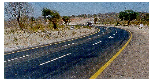
Mõne kuu pärast on liivpuistekihiga Otta pindkate täielikult formeerunud ja näeb suurepärase välja. (Botswana).
