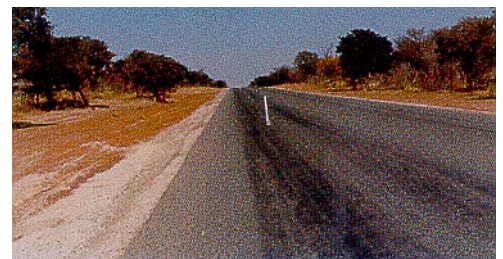
Otta pindkate tuleks eelistatult katta liiklusega võrdselt kogu pinnatud alal, kuna see tõstab välimuse ühtlust. Seda on võimalik saavutada liikluse suunamisega tähiskoonuste abil alale, mis vajab liiklust. (Botswana).
