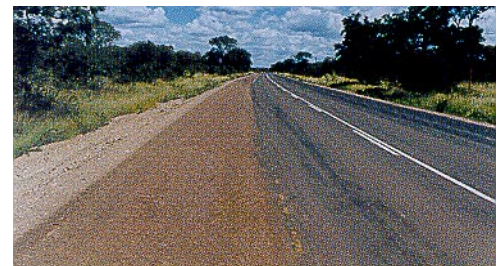
Otta pindkattes on visuaalselt näha peenarde ja sõidutee silmnähtavalt oluline erinevus. Liikluse toime tõuseb sõidureal sideaine ülespoole pinnale ja siit tuleneb värvuse erinevus. See värvide erinevus parandab liiklusohutust. (Botswana).
