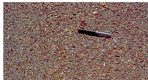
Ühekordse Otta pindkate sulgunud poorid ülal pildil. Pöörake tähelepanu, et mõned nõrgad terad on liikluse all purunenud, kuid ehitusjärgses varases staadiumis on sideaine absorbeerinud purunenud materjali ning on moodustunud tihe veekindel pind. (Botswana).
