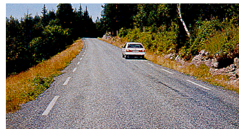
Purustatud kivimaterjalist Otta pindkate esimese järgu teel pärast 6 kasutusaastat. (Norra).
