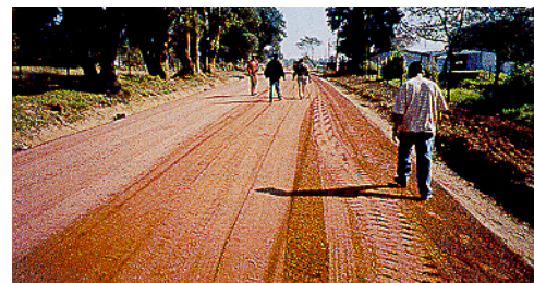
Vahetult pärast ühekordset Otta pindkatet puistati kivimaterjali. Selles järgus näeb pindamine välja nagu kruusatee. Kuid aja jooksul Otta pindkate kinnistub ja ilmneb veidi eelsegatud segu sarnane välimus. (Lõuna-Aafrika).
