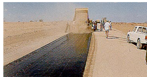
Ümbruskonna loodusliku kruusa kasutamine koos peenosistega on üks tegureid, mis soodustab Otta pindkatete kasutamist. (Keenia).
