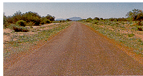
Vaade samast teest (ühekordne Otta pindamine) pärast enam kui 8 aastat kasutust. (Botswana).
