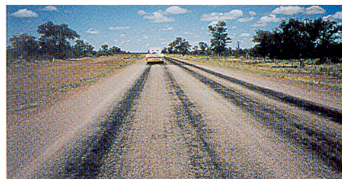
Otta pindkattel esineb mõne esimese kuu jooksul pärast liikluse avamist bituumenirohkust, näib esialgu ebaühtlane ja halvem kui tavaline killustikpindamine. (Botswana).
