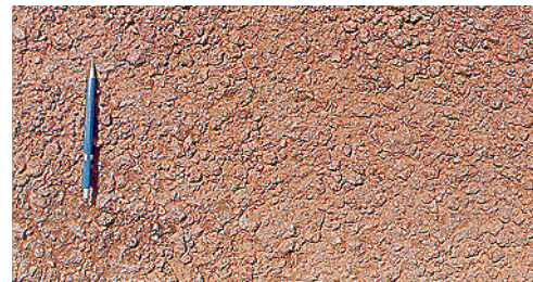
Sulgunud pooridega Otta pindkate, kus kivimaterjalina kasutati looduslikku kohalikku lateriiti. (Keenia).
