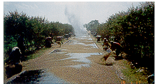
Otta pindkatte kivimaterjal laotati käsitsi meetodil, eelnevalt varudes vallidesse käsitsi purustatud kivimaterjali. 100 meetri pikkune ja 3,7 meetri laiune lõik kaeti kivimaterjaliga 7 minuti jooksul ning lõik avati liiklusele. (Bangladesh).
