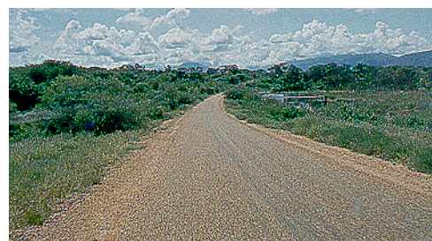
Turkana tee, umbes 20 km Marich' ümbersõidust põhja pool. Otta pindamise kivimaterjalina kasutati sõelutud kvartsiitkruusa. Pärast mitmeid aastaid kasutust nägi kate hea välja. (Keenia).
