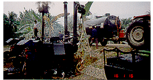
Ümbruskonna katseteel Faridpur'is, bituumen vedeldati ja ka pehmendati, et anda bituumenile õige konsistents. See viidi edukalt läbi lihtsate, kuid sobivate meetoditega. (Bangladesh).
