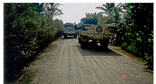
Pneumorullide puudumisel võib Otta pindkatte rullida koormatud veokitega, järgides eelnevalt kindlaksmääratud rullimiskava. (Bangladesh).
