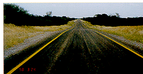
Mõni kuu pärast kasutamist on Otta pindkate kinnistunud ja näeb ühtlane välja. (Botswana).
