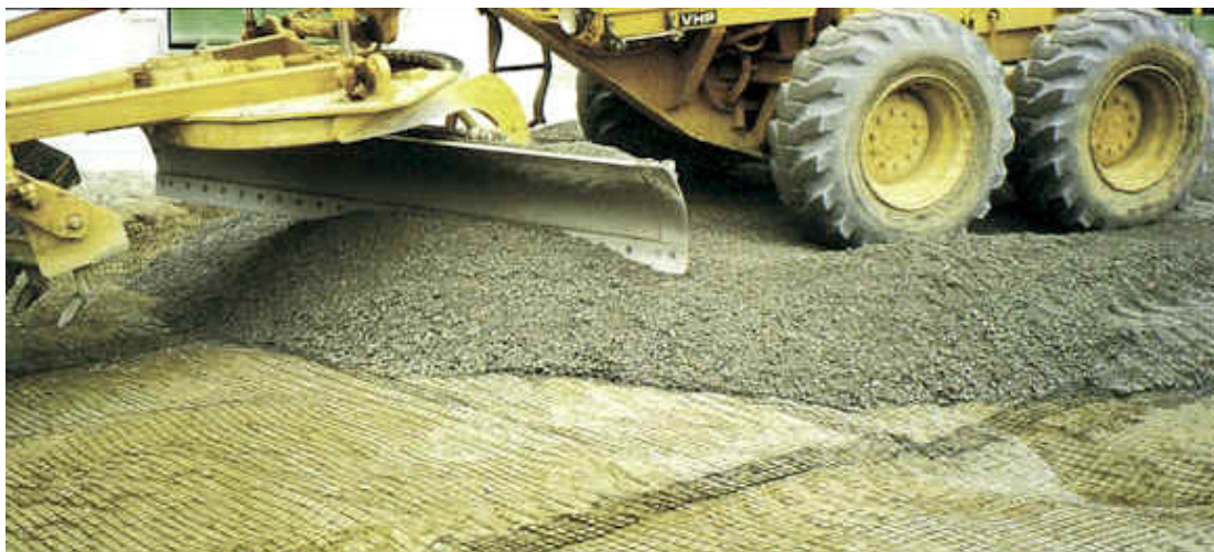
Joonis 1.25 Mineraalmaterjali laotamine geovõrgule
