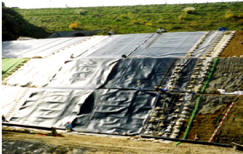
Joonis 1.6 Puhutud lehe ekstrudeerimismeetodil toodetud geomembraan [17]
