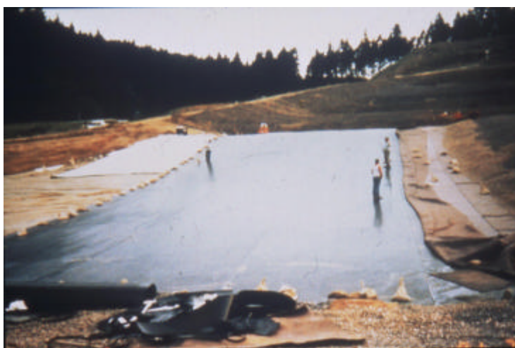
Joonis 1.5 Lameda lehe ekstrudeerimismeetodil toodetud geomembraan [17]
