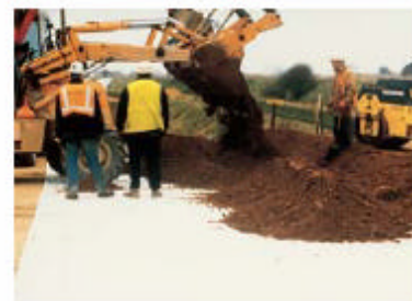
Joonis 1.12 Suure tugevusega geosünteed nõrga aluspinnase armeerimiseks [23]
