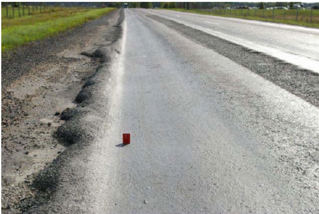
Joonis 2.6 Roobas maanteel nr. 18 Niitvälja-Kulna vasakpoolsel sõidurajal aadressil 18_1_1_1150
