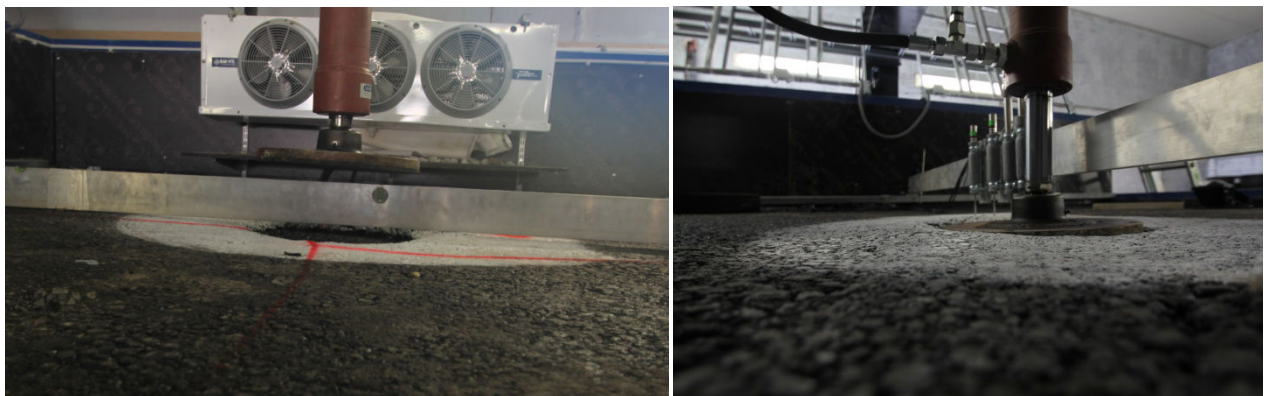
Joonised 28 ja 29. Asfaltbetooni pealmine pind pärast lubjakivikatset
