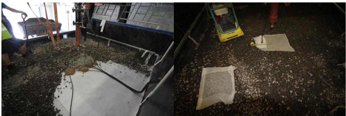
Joonised 3 ja 4. Andurite paigutus killustikukihi alla ja keskele. Kasutatud marli killustikukihtide vahel
