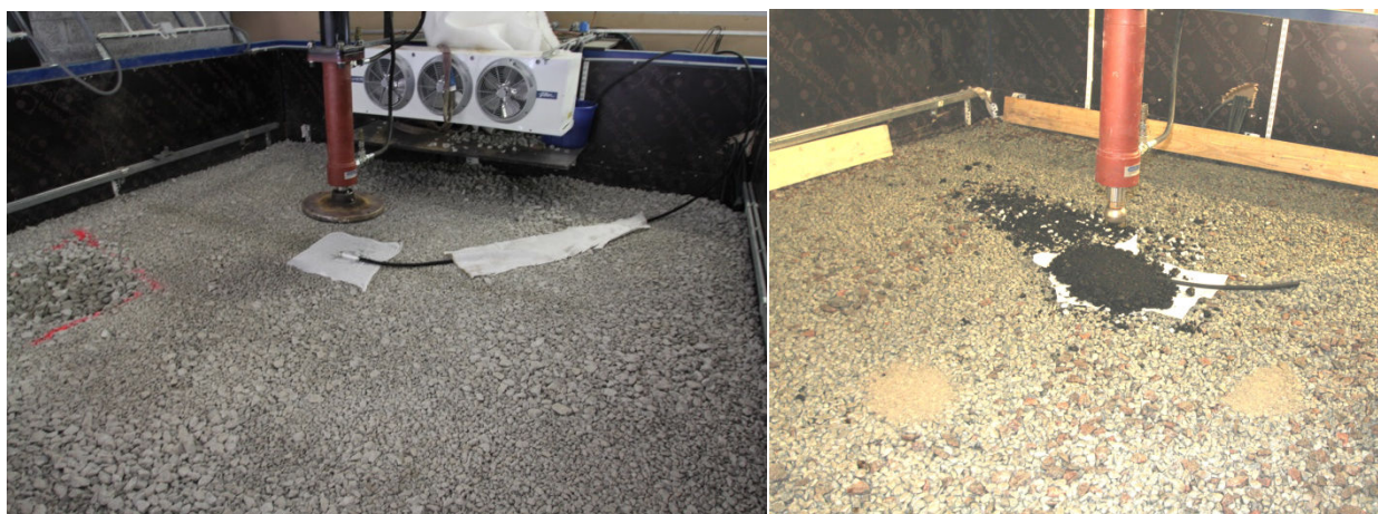
Joonised 7 ja 8. Asfaltbetoonkihi alla paigaldatud tõmbeandur
