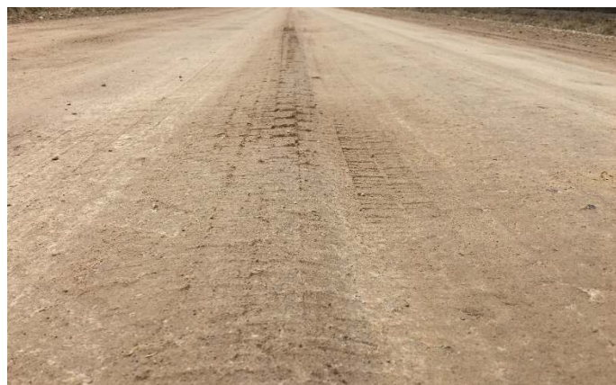
Foto 13. Tee km 9.6...11.4 oli selgesti kattekrusa terakoostis liiga liivane ja peenosiserikas, mistõttu deformeerub see kergesti.
