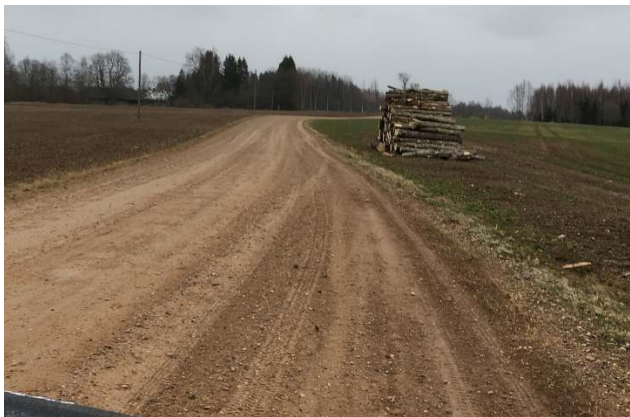
Fotod 3 ja 4. Tee on suhteliselt lai, teeääred on väga liivased, mis mõjutasid kandevõimeväärtusi.
