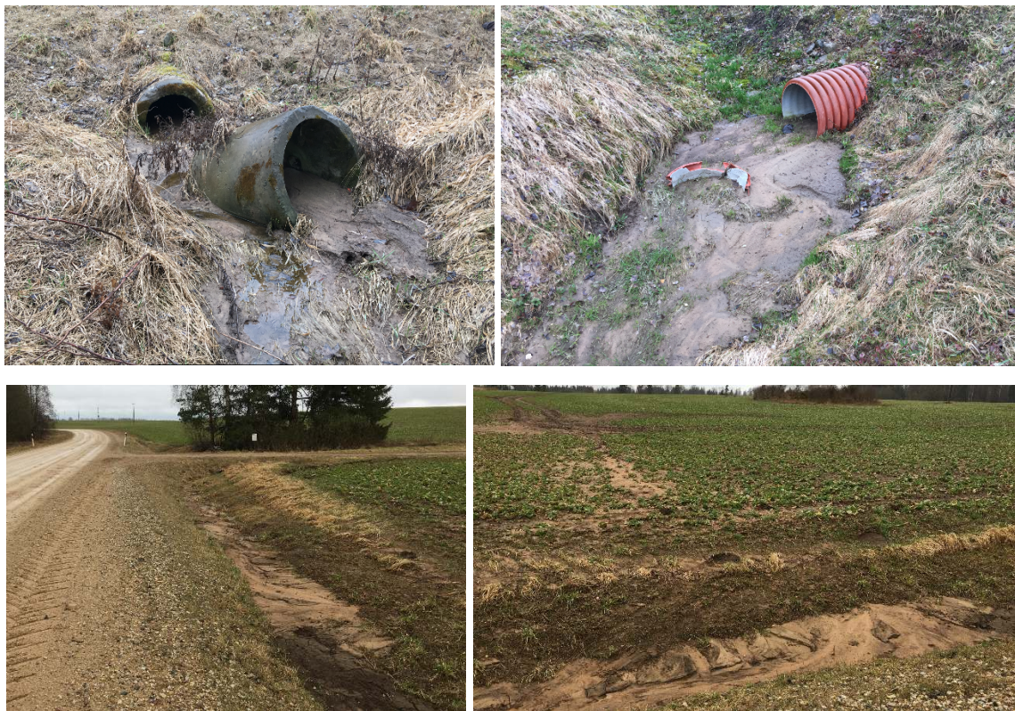
Fotod 9...12. Põllumaa erosioon oli osaliselt ummistanud kraavi ja truubid.
