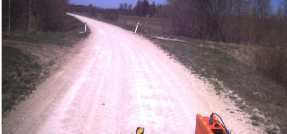
Foto 8. Km 3.7...3.8 mõõdeti mõnevõrra kõrgem kandevõime, kui mujal teel üldiselt, kuid antud koht on ristmik, mistõttu täitekiht on paksem (v.t maaradari profiil joonisel 15).
