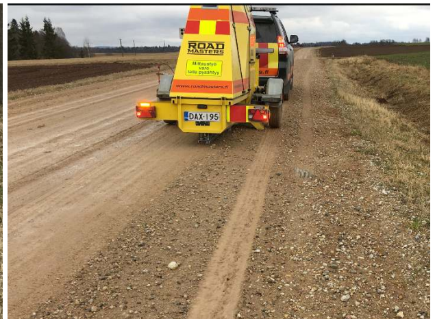
Fotod 8, 9, 10 ja 11 erinevatest kohtadest teel näitavad, et tee servad on kevadeti väga pehmed ning suures osas teest on ääres servad üleval, mis takistab vee äravoolu.
