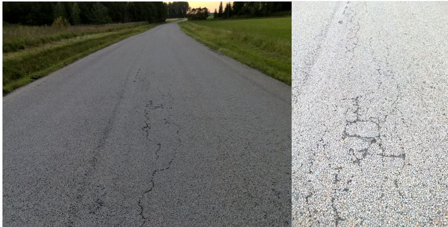
Joonis 1. Pinnatud kihti on tekkinud võrkpragunemine, kuna selle alla jäänud kruusatee on olnud liiga madala kandevõimega.
