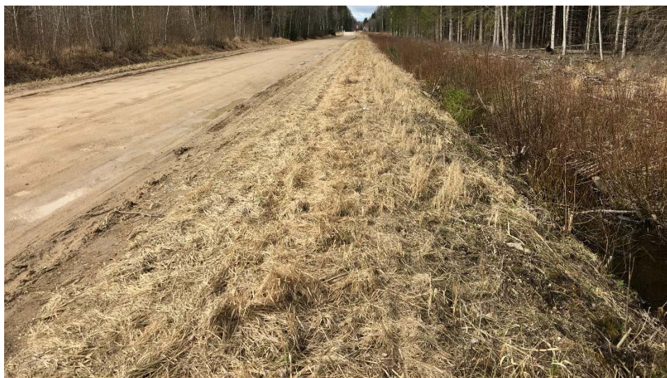
Foto 9. Lõigus 1 on tee ääres laiad peenrad, mis takistavad vee äravoolu kraavi.
