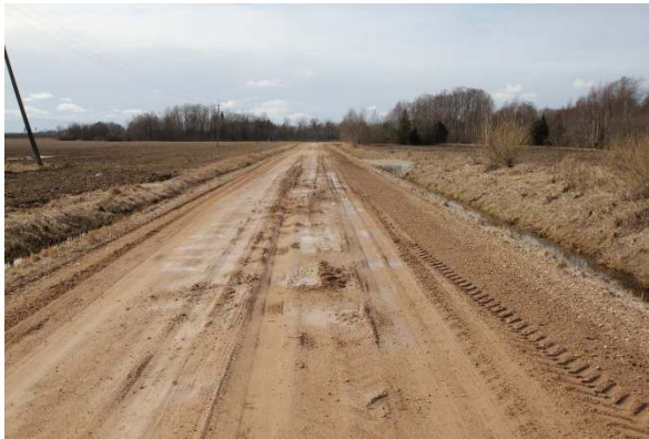
Fotod 11 ja 12 asukohast km 11.2...11.4 näitavad tõsiseid probleeme kandevõime ja kattekrusaga. Fotolt nähtub samuti, et vesi on alt üle pressinud.
