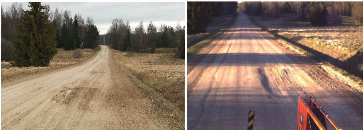
Fotod 6 ja 7 asukohast km 9.60 näitavad probleeme kandevõimega. Nähtava defekti olemusest võib oletada, et keset tõusu pressib vesi välja, mis nõuab dreniiva kihi kasutamist.
