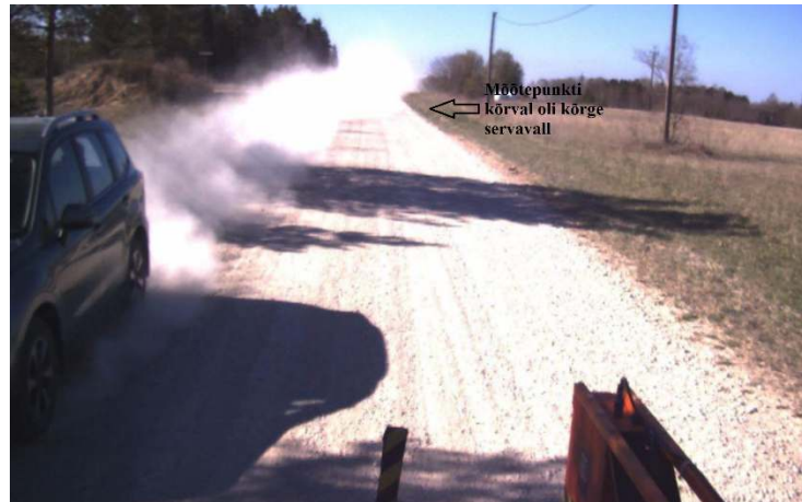
Foto 10. Km 2.500 mõõtepunkti kõrval oli vee äravoolu takistav servavall.
