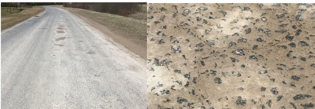
Joonis 2. Tolmuvaba katte all olev kiht ei suuda toetada katet piisavalt, sisse on tekkinud võrkpragu ja peenosis on tunginud läbi pindamise.
