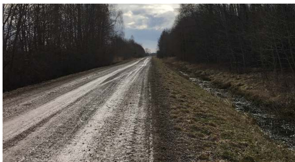
Fotod 5 ja 6. on võetud km 3.6 ja teelõigu lõpust suunal 2, mis näitavad kraavides olevat kõrget veetaset.
