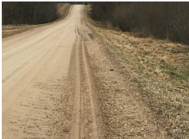
Fotod 8, 9, 10 ja 11 erinevatest kohtadest teel näitavad, et tee servad on kevadeti väga pehmed ning suures osas teest on ääres servad üleval, mis takistab vee äravoolu.
