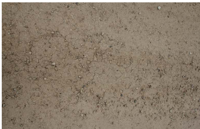
Foto 4. Võrkpragunemine viitab, et katte all on nõrk kiht.
