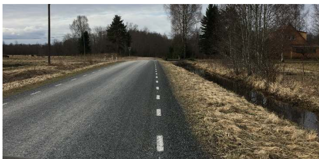
Fotod 5 ja 6. on võetud km 3.6 ja teelõigu lõpust suunal 2, mis näitavad kraavides olevat kõrget veetaset.
