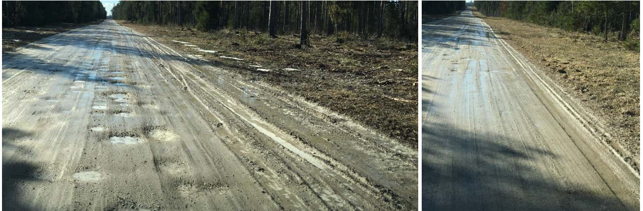
Foto 6 asukoht km 12.5. Veel ei ole võimalust pääseda teekattelt ära, tee on olemasoleva maapinnaga tasa ja tee ääres on vallid; kraave ei ole
