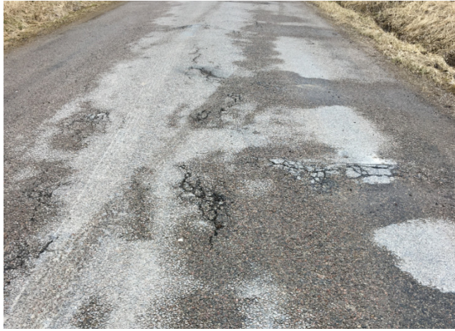
Joonis 3. Tee kandevõime on väga madal, katend ei ole dreniiv, mistõttu vesi on kogunenud kattekihi alla.
