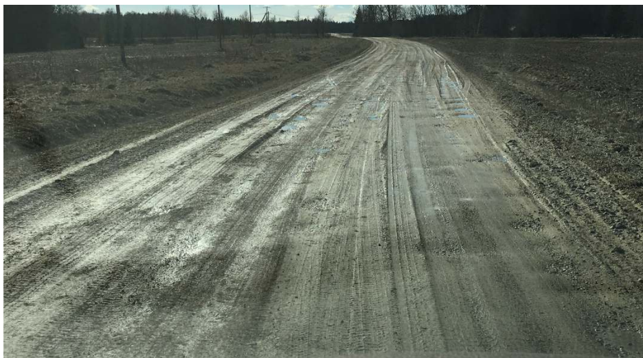
Foto 1 asukohas km 6.7 näitab, et teekate on märg, tee asub kohati maapinnast madalamal, mistõttu veel ei ole võimalik ära voolata tekitades probleeme kandevõime, roobaste ja aukudega.
