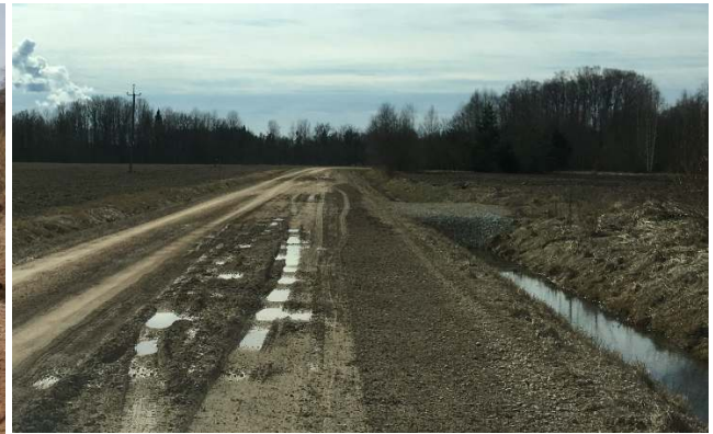
Fotod 11 ja 12 asukohast km 11.2...11.4 näitavad tõsiseid probleeme kandevõime ja kattekrusaga. Fotolt nähtub samuti, et vesi on alt üle pressinud.
