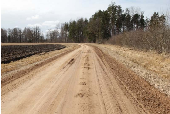
Foto 14 asukohast km 13.1...13.2, kus tee oli pehme ja halvasti läbitav.
