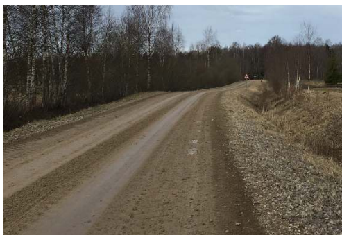
Fotod 3 ja 4. Mida kaugemale sõita, seda sügavamaks lähevad kraavid ja vesisemaks muutub nii keskkond kui teekate. Fotod on tehtud vastavalt ca km 2.5 ja 2.9 juurest.
