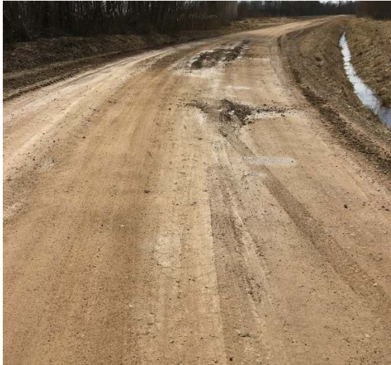
Fotod 9 ja 10 asukohast km 11.1 näitavad kohta, kus sõidukid on kattekrusa sisse vajunud.
