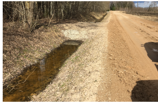
Fotod 4 ja 5 piirkonnast km 10.5...10.7, kus oli teekate oli väga pehme ning autod olid kattest läbi vajunud.
