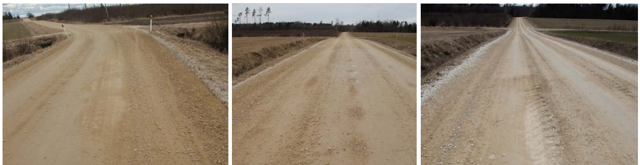
Fotod 1, 2 ja 3. Ka peale hiljutist hõõveldamist oli võimalik tuvastada kohti, kus teekatend on nõrk.
