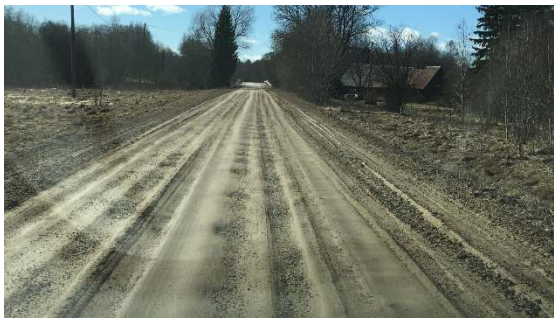
Fotod 3 ja 4 asukoht km 10.1. Tee on olemasoleva maapinnaga tasa, kraave pole, tee kalle on ebapiisav, teekattes on näha sügavaid roopaid. Tee ääres on vettinud lahtine kruusakiht, millesse sõiduautoga sisse sõites võib tekkida liiklusohhtlikke olukordi.
