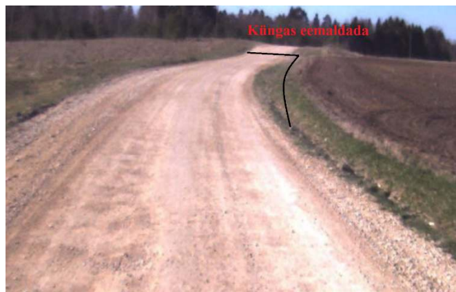
Foto 20. km 7.00 on küngas, mis võib tekitada liiklusohutlikke olukordi ja tuleb seega eemaldada koos kurvi õgvendamisega.
