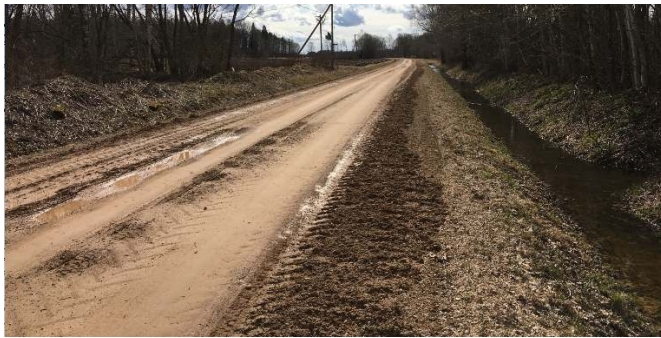
Fotod 4 ja 5 piirkonnast km 10.5...10.7, kus oli teekate oli väga pehme ning autod olid kattest läbi vajunud.
