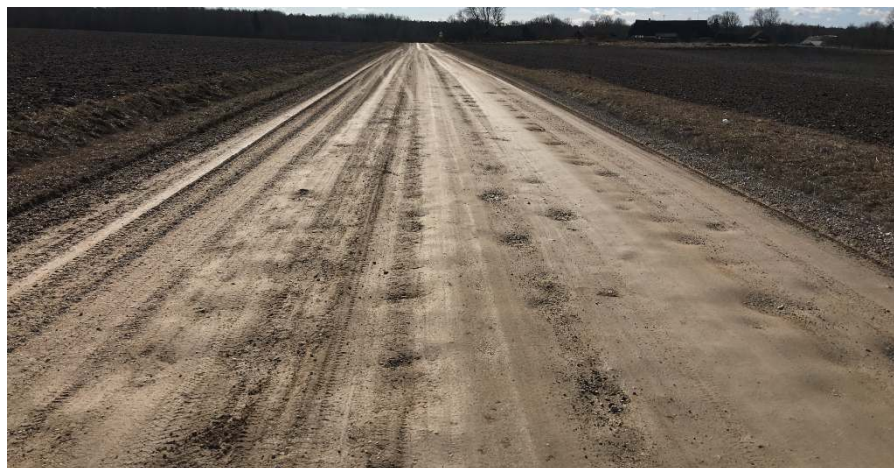
Foto 5 asukoht km 11.0. Teekattes on rohkelt auke. Vee äravool teekattelt on takistatud, kuigi tee äärtes on madalad kraavid
