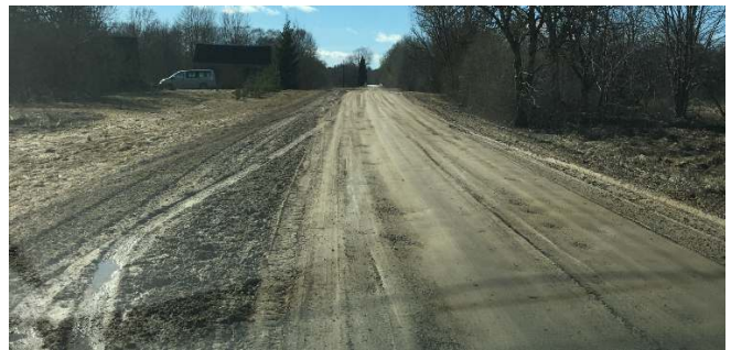
Fotod 3 ja 4 asukoht km 10.1. Tee on olemasoleva maapinnaga tasa, kraave pole, tee kalle on ebapiisav, teekattes on näha sügavaid roopaid. Tee ääres on vettinud lahtine kruusakiht, millesse sõiduautoga sisse sõites võib tekkida liiklusohhtlikke olukordi.
