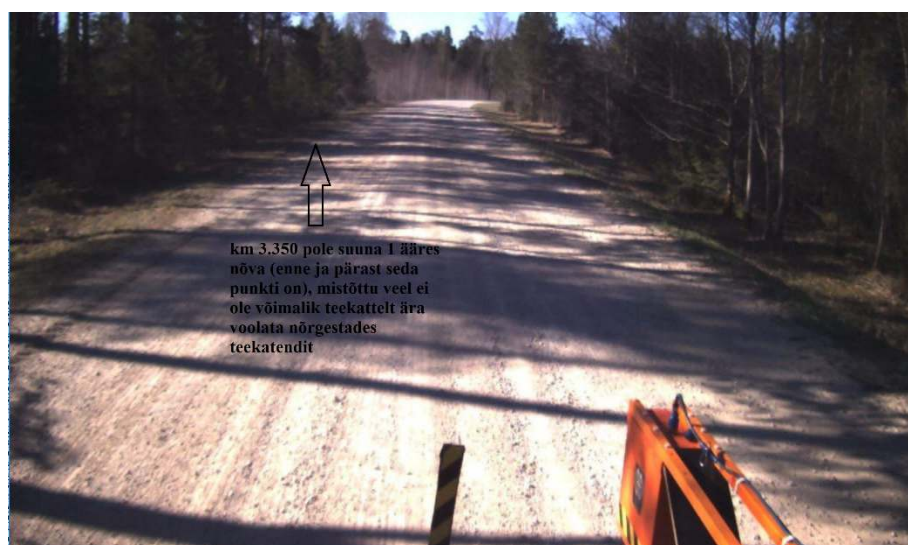
Foto 12. Km 3.350 piirkonnast, millest nähtub, et madalama kandevõimega kohas pole tagatud vee äravool teekattelt.
