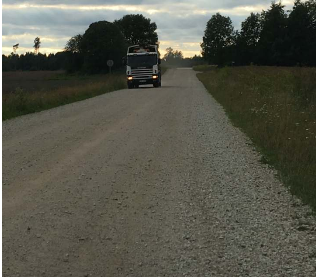
Fotod 5 ja 6. Suur osa Väätsa – Nõmme teel liikuvatest autodest on teed otseteena kasutavad prügiautod. Tee üheks probleemiks on esimesed 368 m, kus tee laius on vaid 5 m ning 160 m peal on halva nähtavusega kurv.
