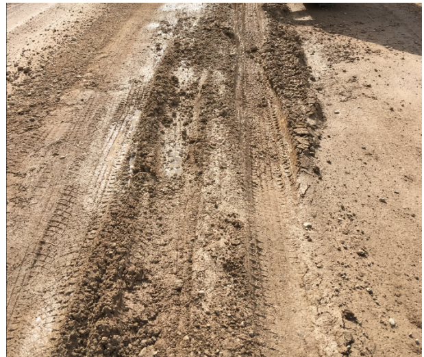
Fotod 9 ja 10 asukohast km 11.1 näitavad kohta, kus sõidukid on kattekrusa sisse vajunud.
