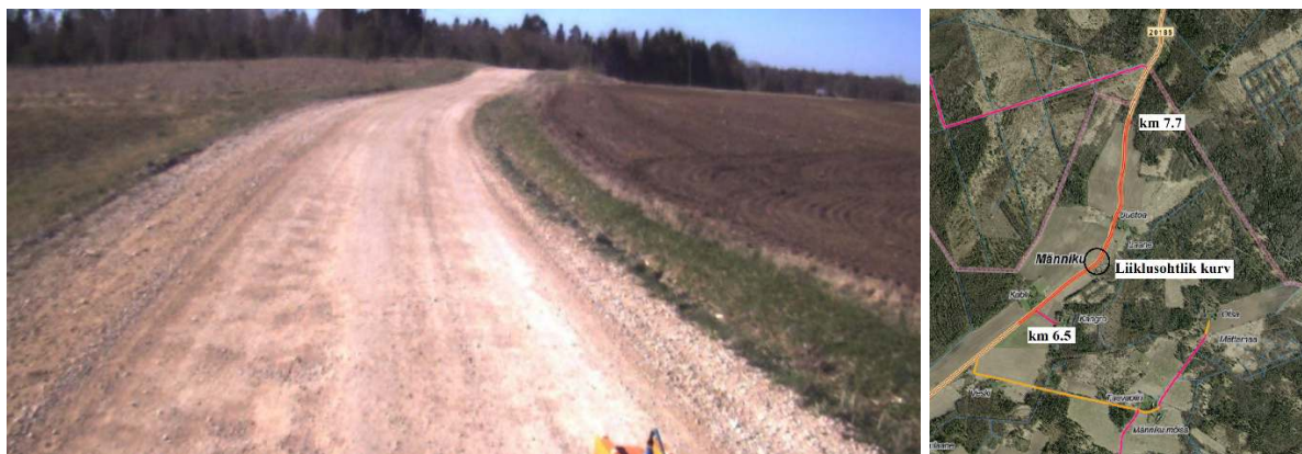
Foto 14. ja joonis 17. Vahemiku km 6.5...7.7 on tee laius alla 6 m, mistõttu tuleks teed laiendada. Km 7.0 on kurvi peal kungas, mis võib tekitada liiklusohhtlikke olukordi ja mis seega tuleks eemaldada.
