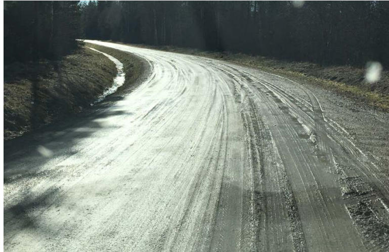
Foto 2 asukoht km 9.0. Kohad, mis olid piisava kaldega ja mille ääres olid kraavid ning vee äravool nendesse ei olnud takistatud, olid paremas seisus.
