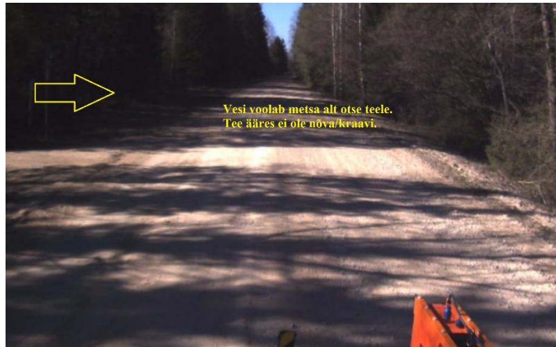
Foto 11. Km 3.050 madal kandevõime on seostatav sellega, et metsast on maapind kaldus tee poole ning tee ääres pole kraavi.
