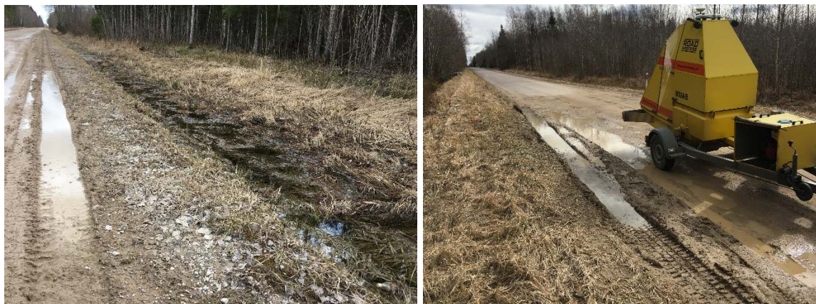
Fotod 2 ja 3. Pinnavesi on väga kõrgel ja vee äravoolu teekattelt takistavad äärevallid, mis muudavad kattekihi (ja ka kogu teekonstruktsiooni) pehmeks.
