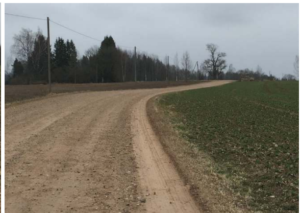
Fotod 3 ja 4. Tee on suhteliselt lai, teeääred on väga liivased, mis mõjutasid kandevõimeväärtusi.
