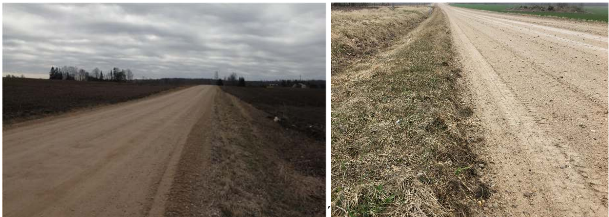
Fotod 1 ja 2. Teekate on liivane, mistõttu tekivad kergesti augud ja „trepp“. Tee ääres on servavall, mistõttu teekate on pehme.
