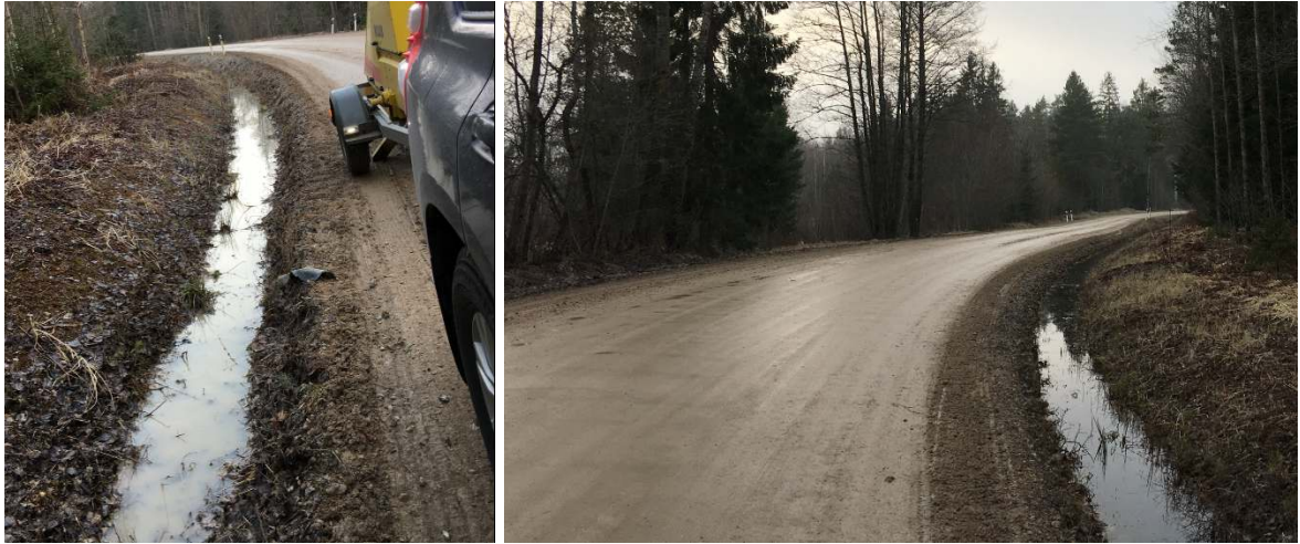
Fotod 6 ja 7 asukohtadest km 2.10 ja 2.45 kujutavad madalat kraavi, mistõttu vesi on kevadel väga katte lähedal.
