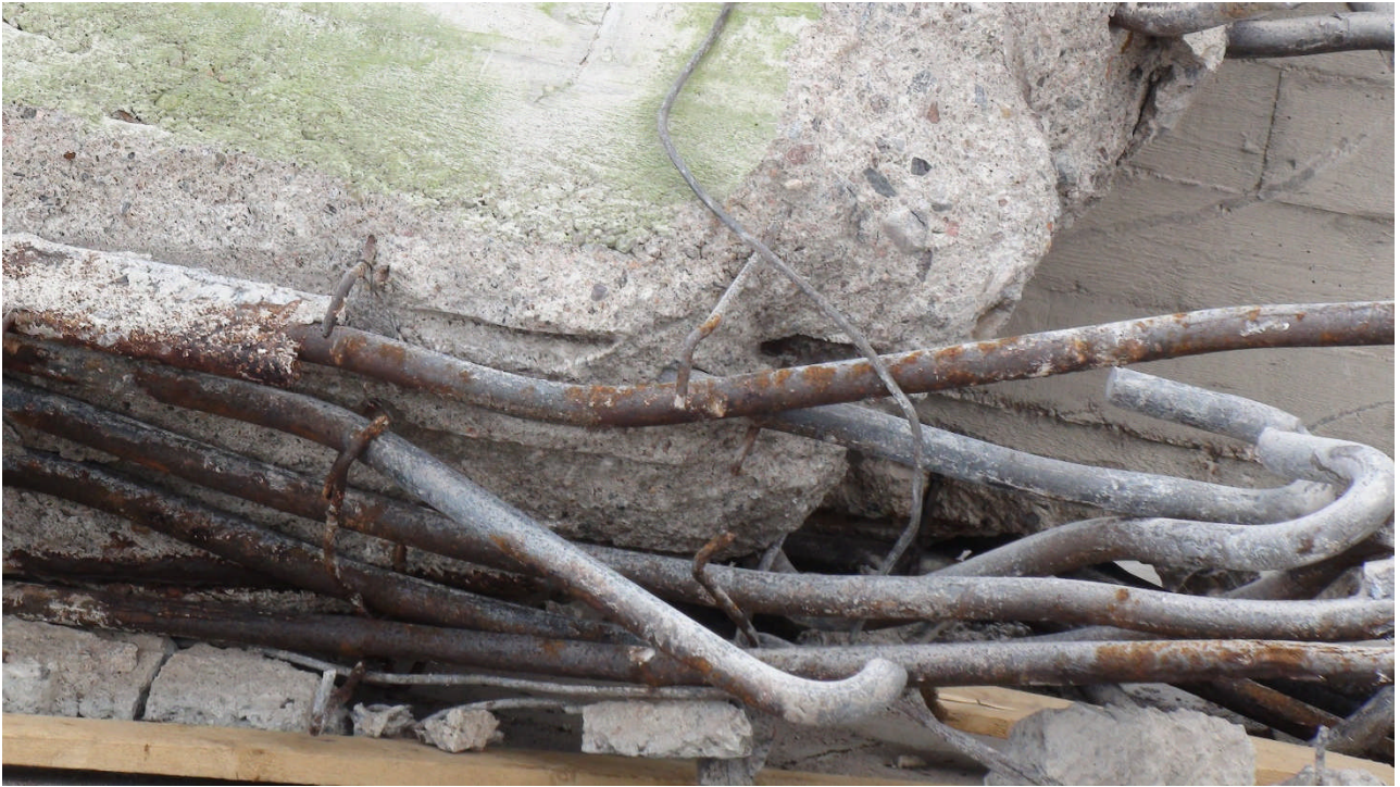
Foto 2. Armatuur peatalas. Armatuuri varraste paigutus vastas tüüpprojektile.
