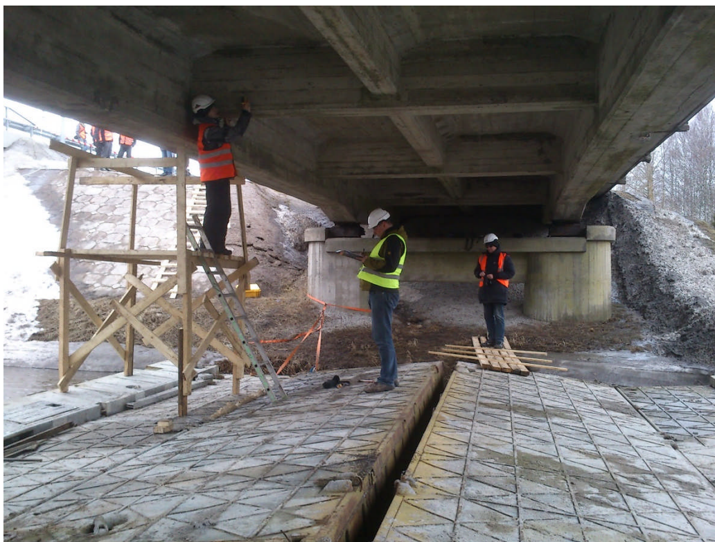
Joonis 26. Põhitalade varju jäänud situatsioon silla all
