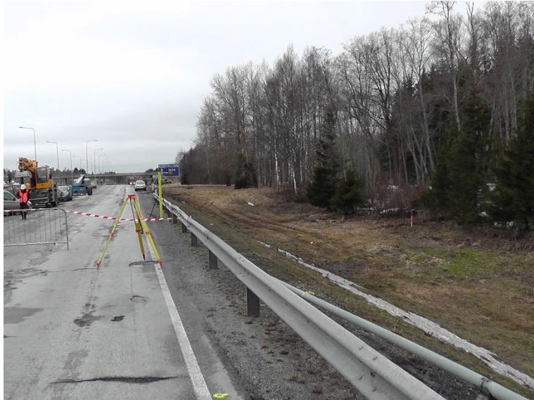
Joonis 9. Loobu maanteevilla põhjapoolse serva nivelleerimisjaama asukoht (vaade läänesuunale), tagaplaanil ajutisele reeperile asetatud mõõdulatt
