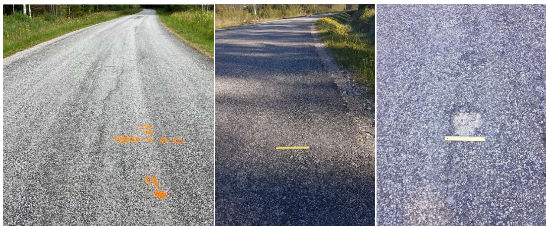
Joonis 7.10. Mass-stabiliseerimata turbaga lõigul tõenäoliselt külmakergetest johtuv pikipragunemine; KS lõigul leiduv võrkpragunemine; CFB tuhaga lõigul pindamiskihi irdumine/lagunemine.
