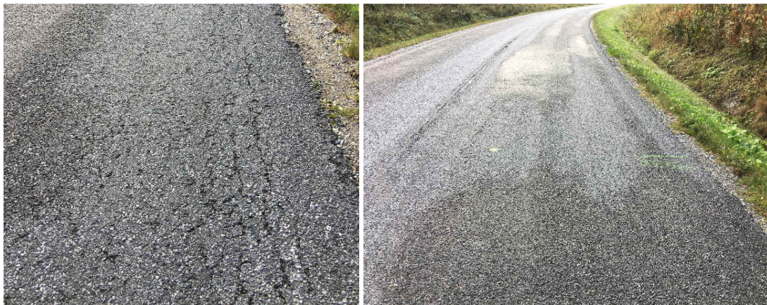
Foto 7.11. Võrkpragu lõigu 4 alguses, tee keskel on näha ka pikipragu.
