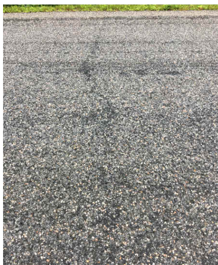
Foto 7.12. Põikpragu tuhkstabiliseeritud sektsioonis (mass-stabiliseerimise peal).
