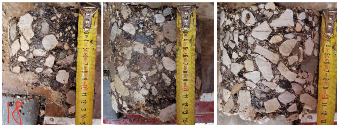
Foto 7.15. Simuna-Vaiatu objekti puurkehad PK 35+50, PK 36+00 ja PK 37+00.
