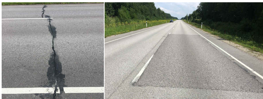
Foto 7.2. Põikpragu katselõigul A ja näidis sellest, kuidas on välja vahetatud asfaltkatet.
