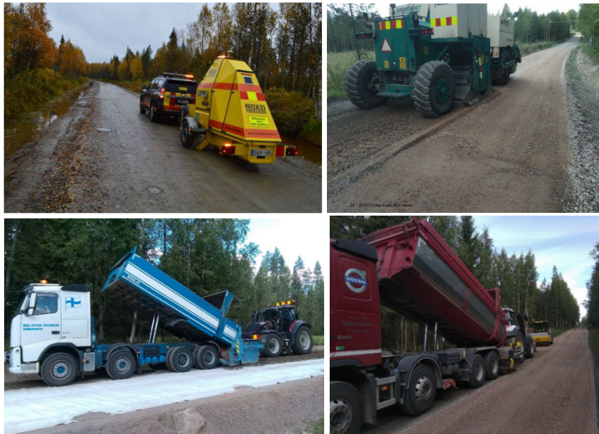
Foto 4.23. Kruusatee kandevõimemõõtmised, aluse homogeniseerimine ja uue katendi ehitamine geotekstiili kasutamisega, kus kattekruusa paigaldamine toimub traktori külge haagitud laoturiga. [fotod: Eino-Matti Hakala]
