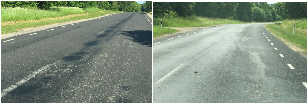
Fotod 1.1 ja 1.2. Võrkpragu tee keskel km 35.4 ja pikipragu km 35.5.
