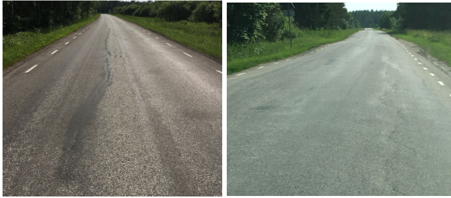
Fotod 3.7 ja 3.8. Mõned näited esinevatest pikipragudest ja ebatasasusest.
