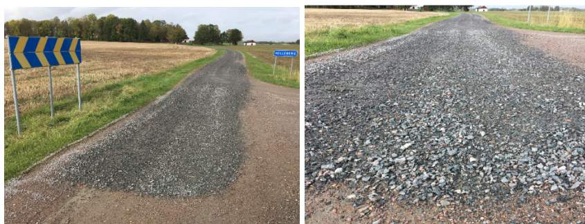
Foto 4.11. Lõuna – Rootsi kruusateed, kulumiskihi uuendamine graniidist optimaalse seguga (visuaalselt võis hinnata fr 0/31.5 mm).
