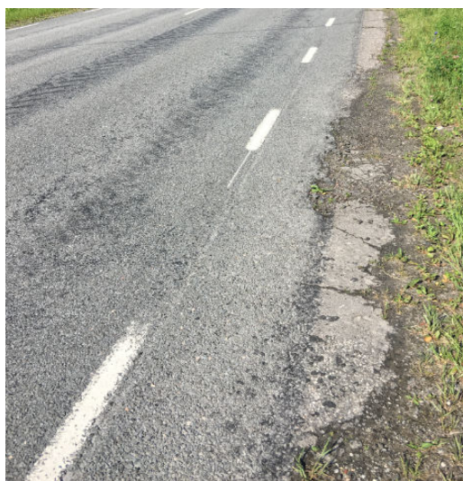
Foto 2.13. Pinnatud katte alt paljastuv stabiliseeritud kiht.
