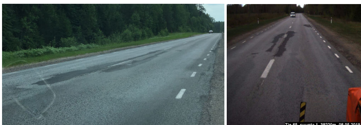
Fotod 1.9 ja 1.10. km 38.27 tee keskel olev nõrk piirkond.
