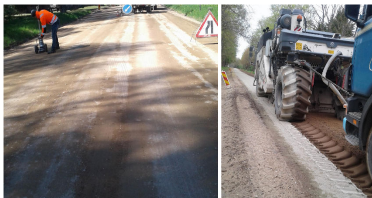
Fotod 4.3 ja 4.4. „Postitee“ ehitusel kasutati ehitaja poolt üheks kvaliteedi hindamise meetodikaks kandevõimemõõtmisi Dynatesti LWD-ga. Stabiliseerimisel kasutati 1.5% tsementi. [autor: Jaanu Mühlberg]
