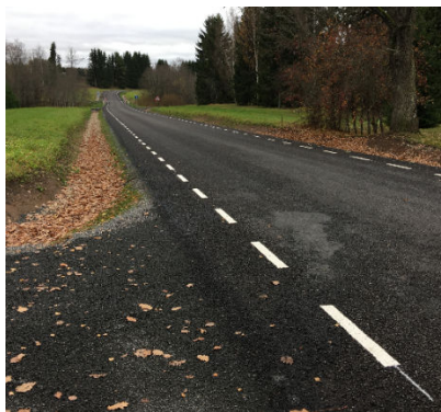
Foto 4.9. 2019. a. valminud „Postitee“ lõik, kus mulde ülemine kiht stabiliseeriti 20 cm sügavuselt hüdraulilise sideainega.
