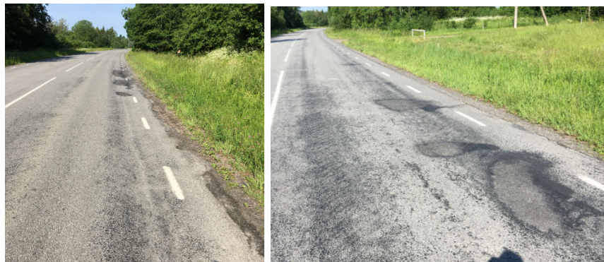
Fotod 2.9 ja 2.10. Km 4.8...5.0 on sõidusuuna 2 tee servas vajumisi (pikiroobas) ja lapitud teekatet. Võimalik, et tee on pinnatud laiemaks, kui on all olev stabiliseeritud kiht.
