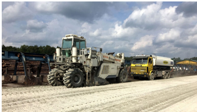
Foto 4.7. StoraEnso palgisorteerimisliini platsi stabiliseerimine aastal 2016 tsemendi ja StabilRoadiga [21].
