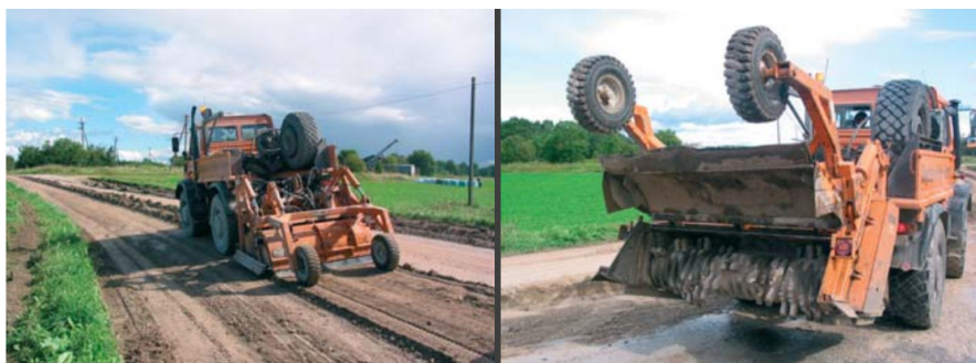
Foto 4.26. Eestis aastal 2004 tehtud katsetööd PÖMA tehnoloogiaga. [22]
