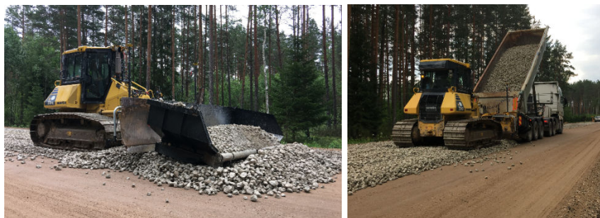
Foto 4.2. riigiteel nr 35 Tudulinna – Iisaku km 1...16 ehitusel kasutatud killustikulaotur [autor: Sven Sillamäe]
