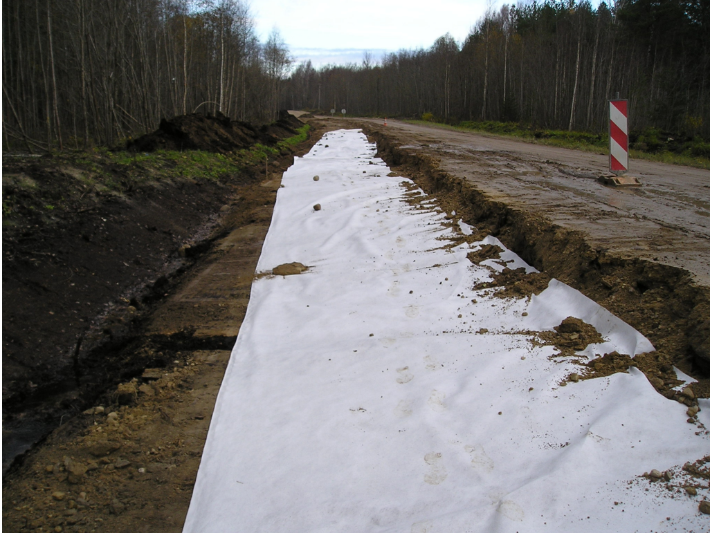
Joonis 1.9. Soolõigul muldkeha laienduse alla paigaldatud geotekstiil
