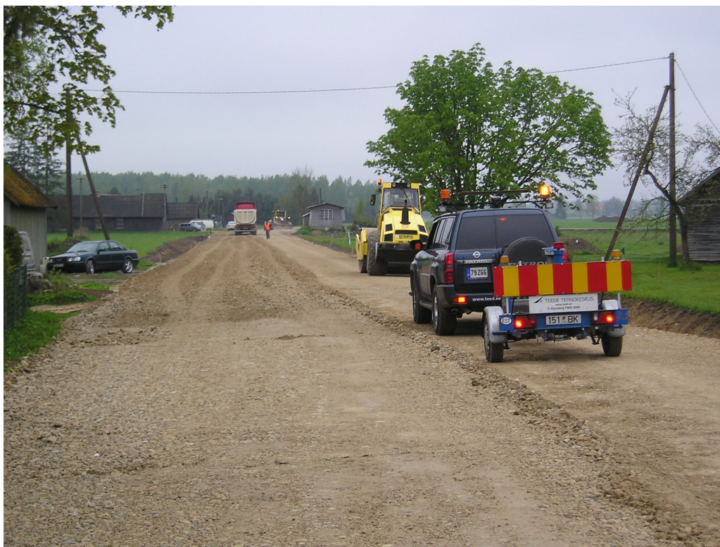
Joonis 1.14. Aluse ehituse tööfront liikumas vahetult FWD mõõteseadme ees
