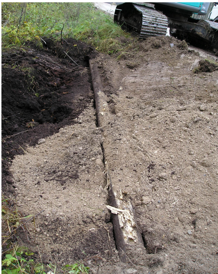
Joonis 1.8. Soolõigul vanast muldkehast välja tulnud palgid
