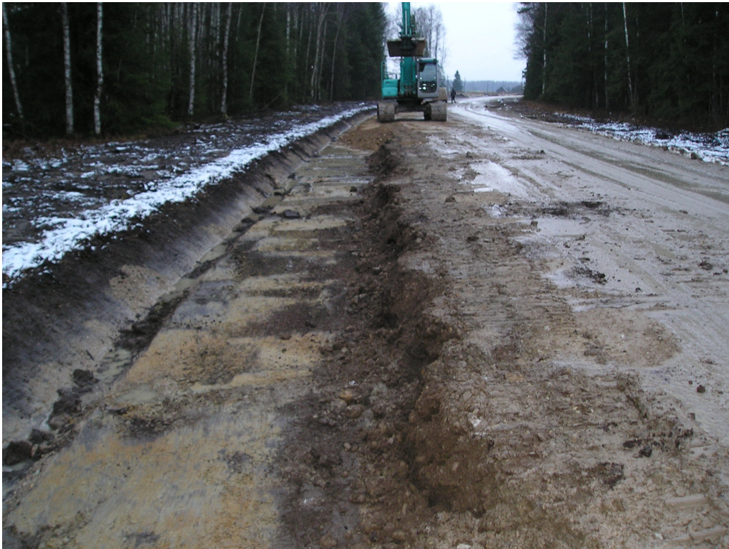
Joonis 1.13. Muldkeha laiendamine PK 75 juures
