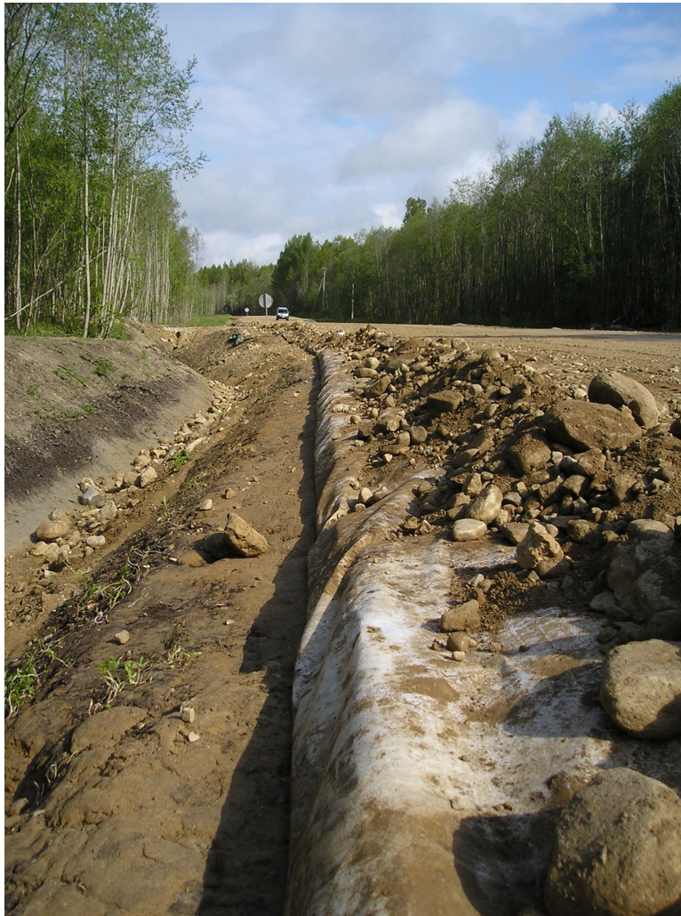
Joonis 1.11. Soolõigul telje suunas tagasi keeratud geotekstiili ja –võrgu servad
