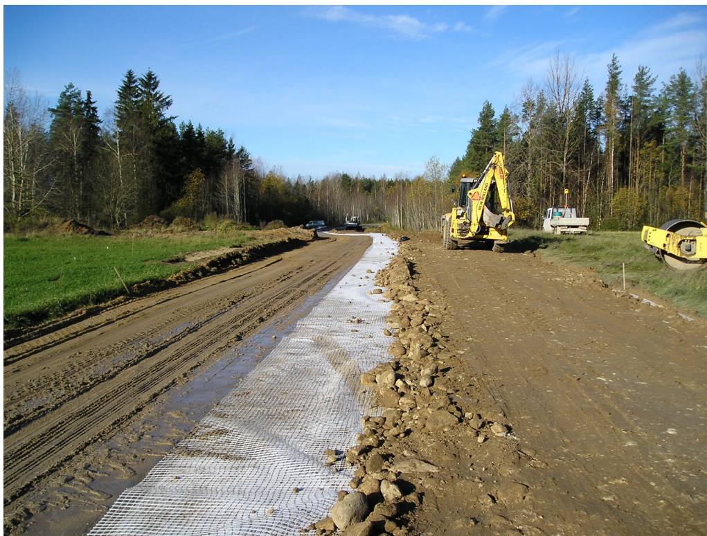
Joonis 1.10. Geotekstiili ja –võrgu katmine kruusaga soolõigu alguses
