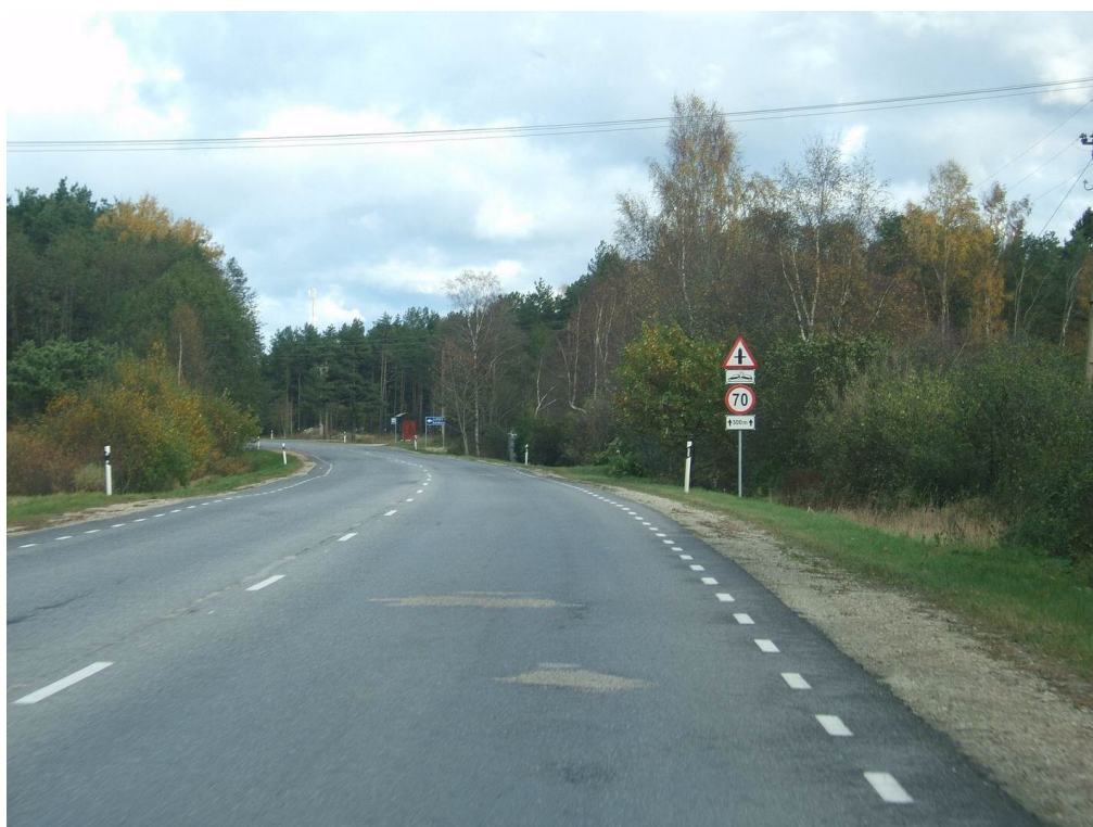
Km7,9( suunaga Tallinna poole). Piiratud kohtumisinähtavus, kehtestada möödasõidukeeld, ees on ka keskmisest suurema liiklusohtlikkusega lõik, kindlustatud teepeenar väga kitsas
