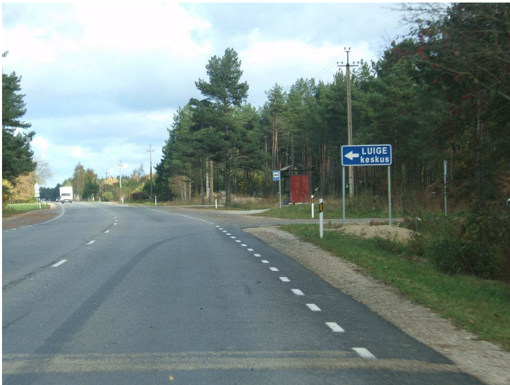
Km 7,5. Tammetalu bussipeatuse vahetus läheduses on mitmed juurdesõiduteed, buss võib varjata külgnähtavust
