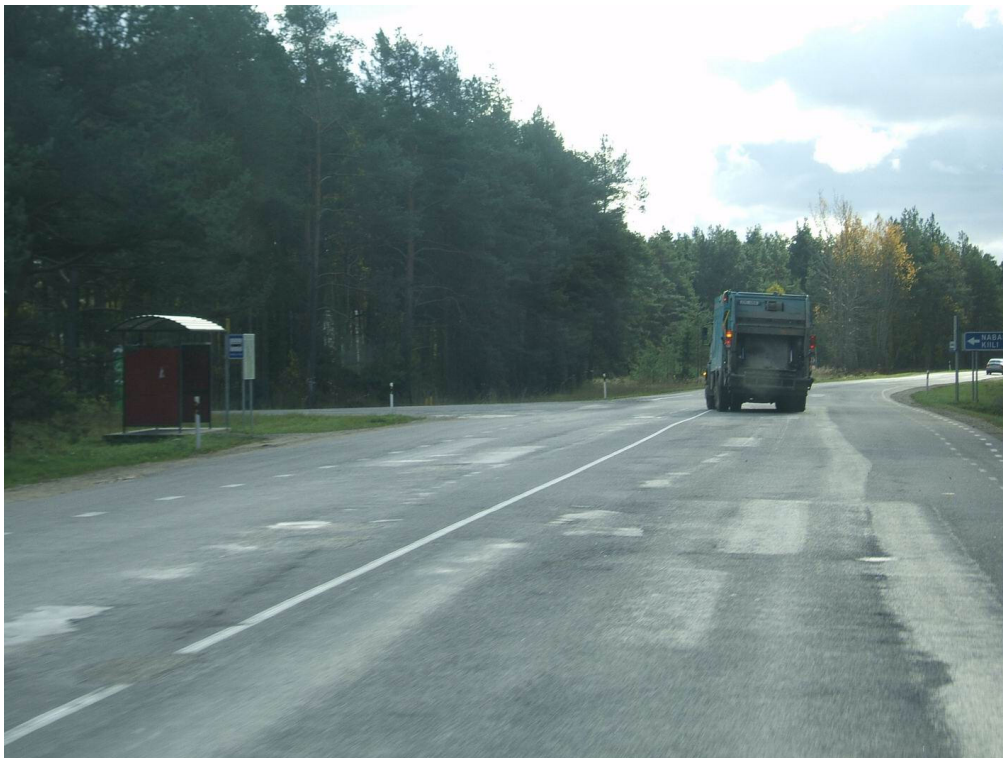
Km 5,3. T11115 ristmikul puudub vasakpöörderada, teelaiend on olemas paremalt möödumiseks (see võib samas ohustada jalakäijat)
