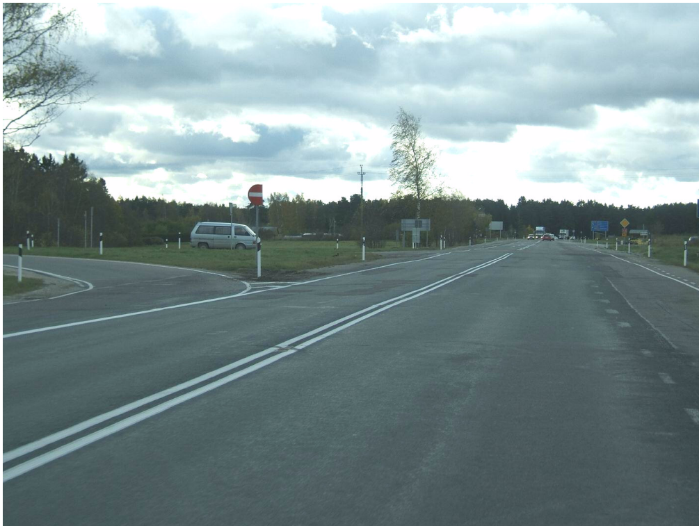
Km 8,4. Oleks vajalik märgistada eraldi vasakpöörderada (praegune märgistus on vaevumärgatav), ajutiselt aitaks ka märgi 532 paigaldamine
