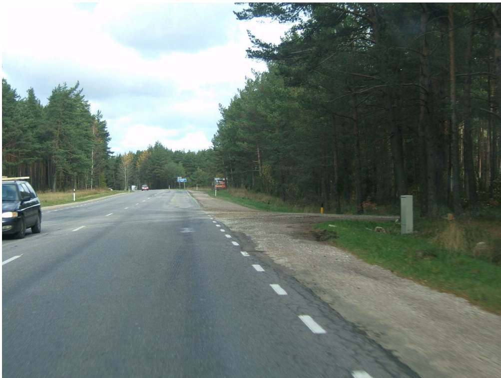
Km 6,0. Väiksemate juurdepääsuteede suudmed ei ole asfalteeritud, mis toob endaga kaasa killustiku ja pinnase kandumise peateele
