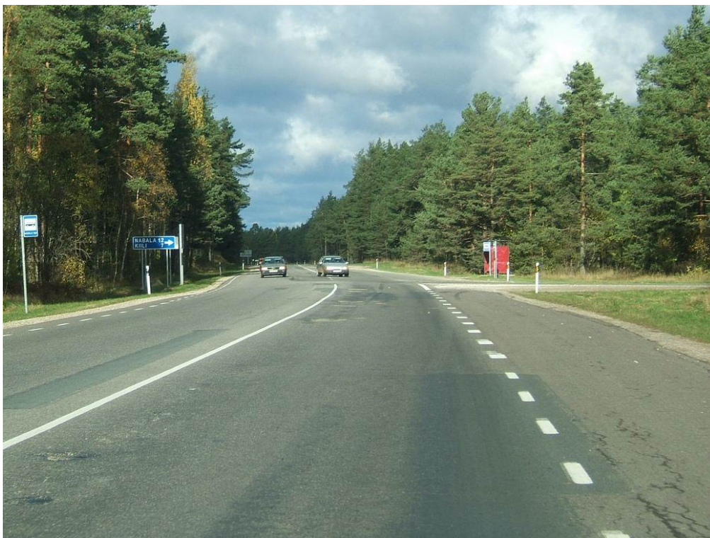
Km 5,3. T11115 ristmikul linnasiseneval suunal kandub parempöördel kurvi lõikamise tulemusena teele killustikku, mis võib põhjustada juhitavuse halvenemist kurvis
