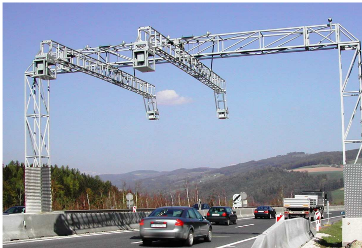
Joonis 6.1. ASSC seadmed kiirteel Kesk-Euroopas ( www.efkon.com )
