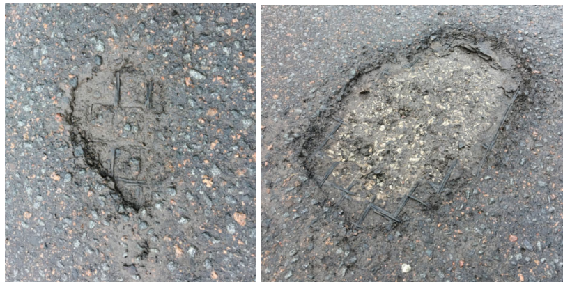
Joonis 5.30. Halva nakke ja liiga väikse AB paksuse tõttu tekkinud augud teekattes.
