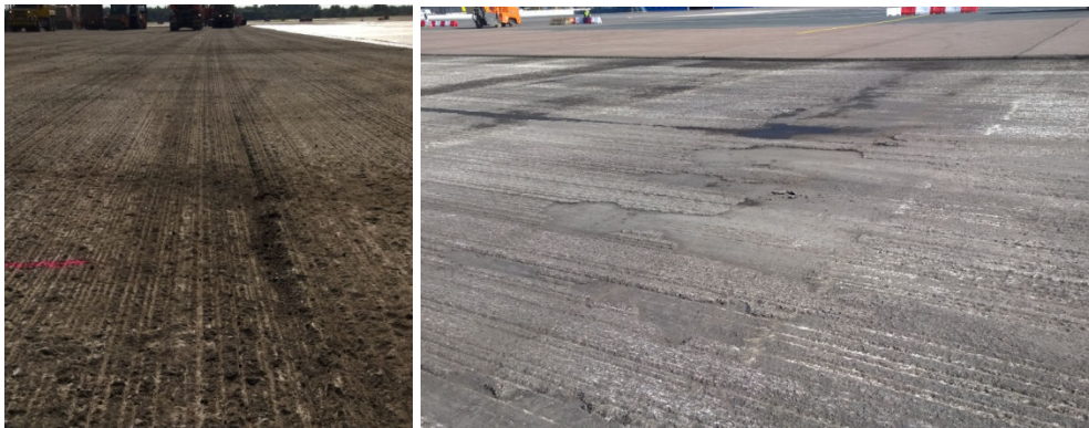
Joonised 5.34 ja 5.35. Freesimisjalg oli liiga sügav ja terav. Suuri probleeme oli aluse puhtuse ja tasadusega.
