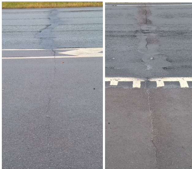
Joonised 5.11 ja 5.12. Põikpraod klaaskiudvõrguga sektsioonis olid visuaalselt kitsamad, mis võib johtuda ka parandusmetoodikast.
