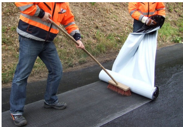
Joonis 3.1. Asfaldigeosünteedi paigaldamine vaid prao kohale. [Tensar]
