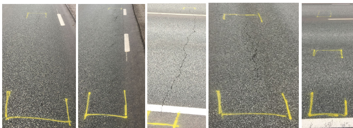
Joonis 1.64. Muud objektile leitud praod olid nii põik- kui pikipraad.
