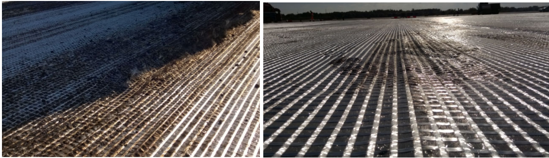
Joonised 5.38 ja 5.39. Probleem oli selles, et kui auto sõitis materjali peal, hakkas see tõmbeelemente puruks rebima, kuna materjal ei olnud aluse küljes piisavalt tugevalt kinni. Teise joonise keskel on näha, kuidas asfaldivõrk kaardub ebatasasuse all. See on potentsiaalne koht, kus klaaskiud rebeneb.
