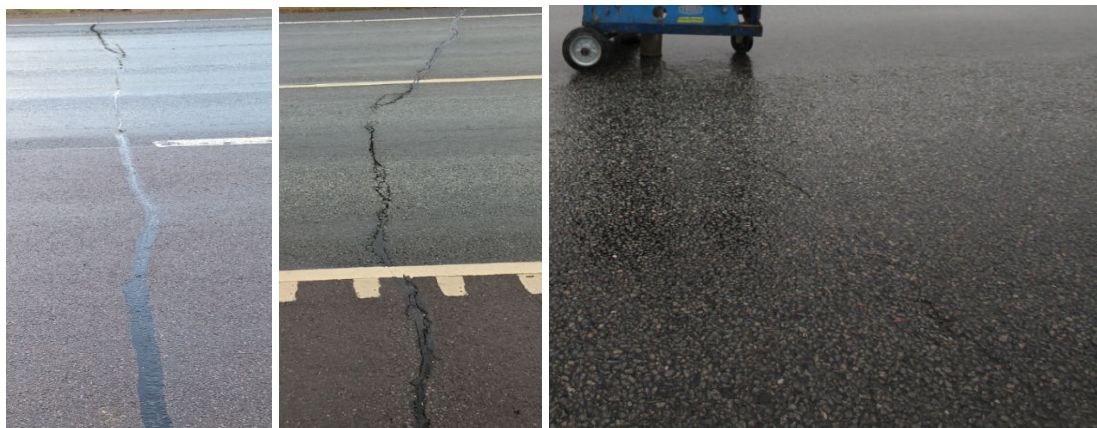
Joonised 5.3...5.5. Enamus põikpragudest olid täidetud, osad juba lagunenud, osad veel vaevunähtavad ehk värskest tekkinud.
