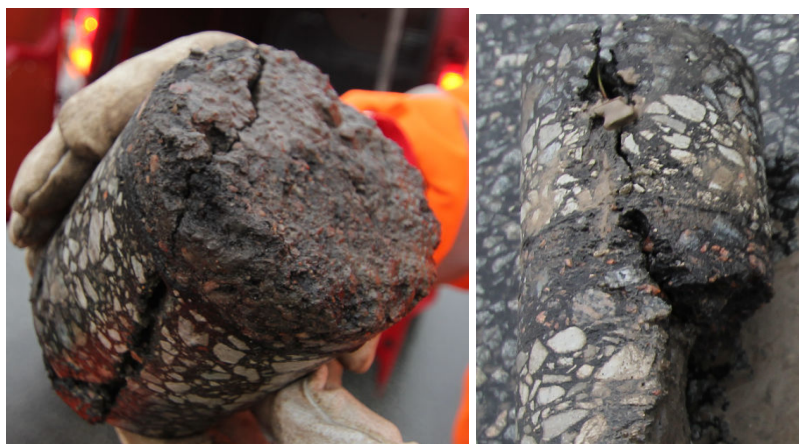
Joonised 5.9 ja 5.10. Praod on läbistanud kogu asfaltkatet, kuid geosünteeet oli terve.
