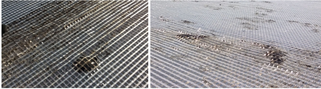
Joonis 5.37. Nakke- ja puhtuseprobleemid. Palju oli gudrunaatori rehvide küljest jäänud „bituumenilärakaid“.
