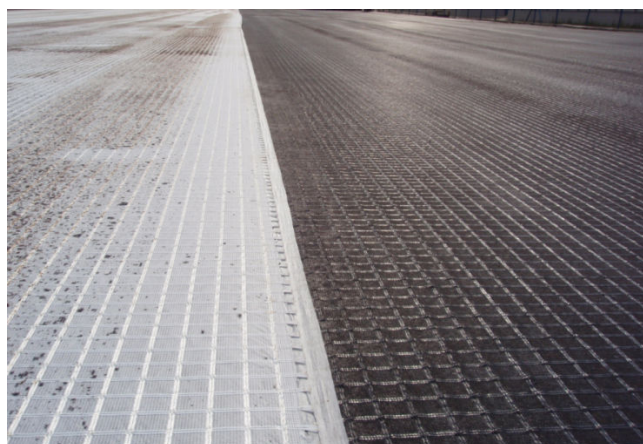
Joonis 5.28. Parempoolne on õige küllastusaste, vasakpoolsele pole piisavalt bituumenit. Foto on saadud tootjalt.
