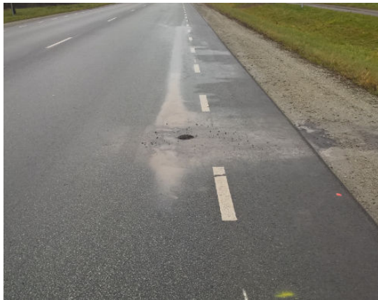
Joonised 1.91 ja 1.92. Puurkeha puurimine kõige sügavama roopaga kohast.
