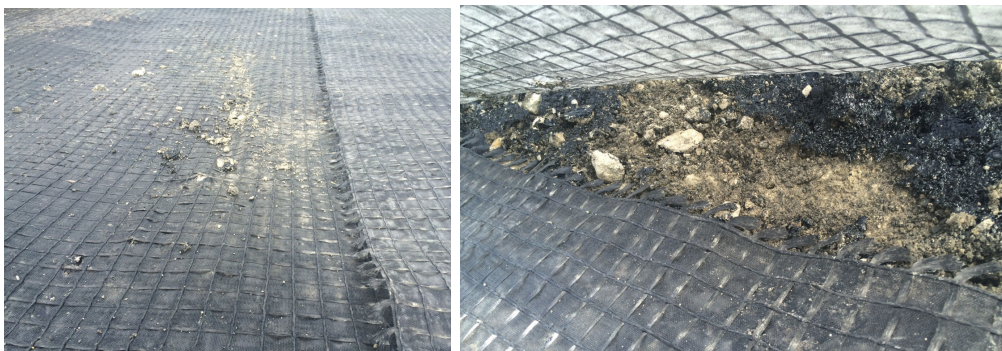
Joonised 5.43 ja 5.44. Kohati paigaldati asfaldivõrk isegi killustikalusele, kus pole võrgust mingisugust kasu.
