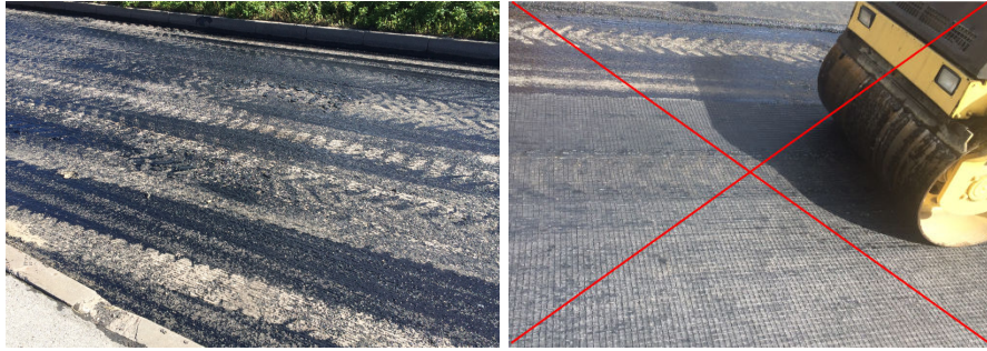
Joonised 5.43 ja 5.44. Objektil ei olnud olemasolev alus piisavalt puhas ja tasane ning otse klaaskiudvõrgul sõideti metallvaltsidega rulliga, mis hävitab võrgu tõmbeelemendid.
