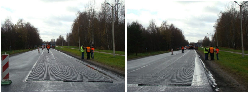
Joonised 1.51 ja 1.52. Geosünteedi kõver paigaldus.
