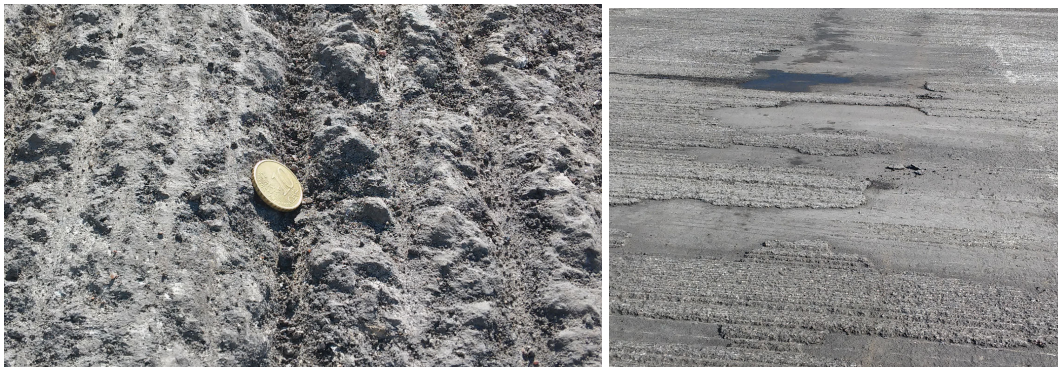
Joonised 4.1 ja 4.2. Taolisele pinnale ei tohi asfaldivõrku paigaldada – freesijalg on liiga sügav, asfaltkatte must, ebatasane ja õline.
