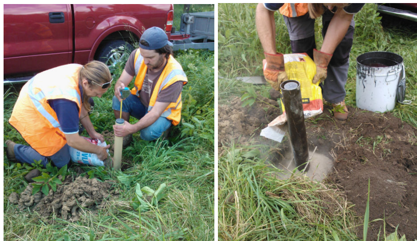
Joonised 1.15 ja 1.16. Vaatluskaevu rajamine.
