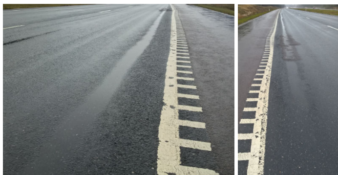
Joonised 5.13 ja 5.14. Klaaskiudvõrgu sektsioonis oli arenenud märkimisväärne pikiroobas.
