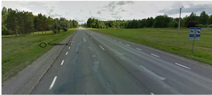
Joonis 1.18. Vaatluskaev nr 2 asub Tensari sektsioonis.
