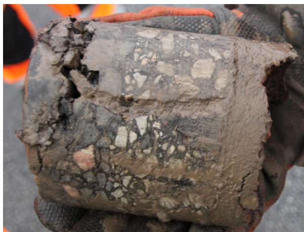
Joonis 5.6. Temperatuuripragu on arenenud ülalt alla kohta, kus varasemalt pragu olnud ei ole. Tekkinud pragu ei ole arenenud ka edasi vaid on peatunud geotekstiili tasapinnas.
