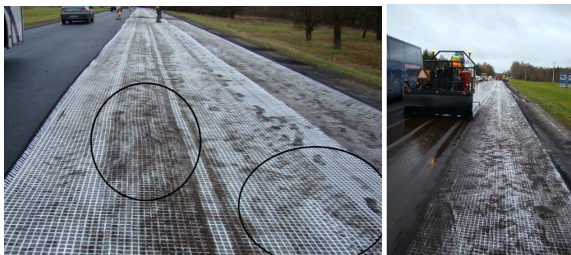
Joonised 1.37 ja 1.38. Geosünteedi tekkinud ja jäänud voldid.
