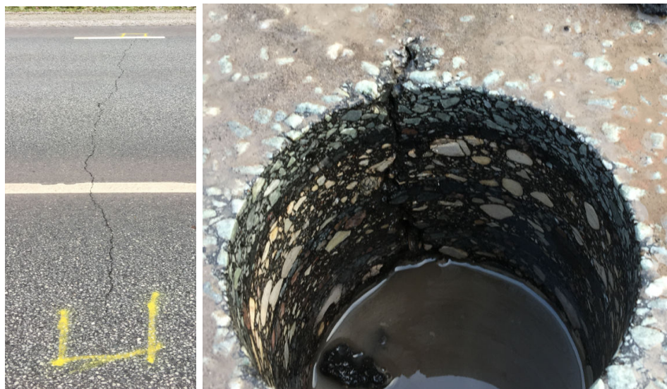
Joonised 1.62 ja 1.63. Põikpragu on peegeldunud ülekattes pea kogu tee ulatuses.
