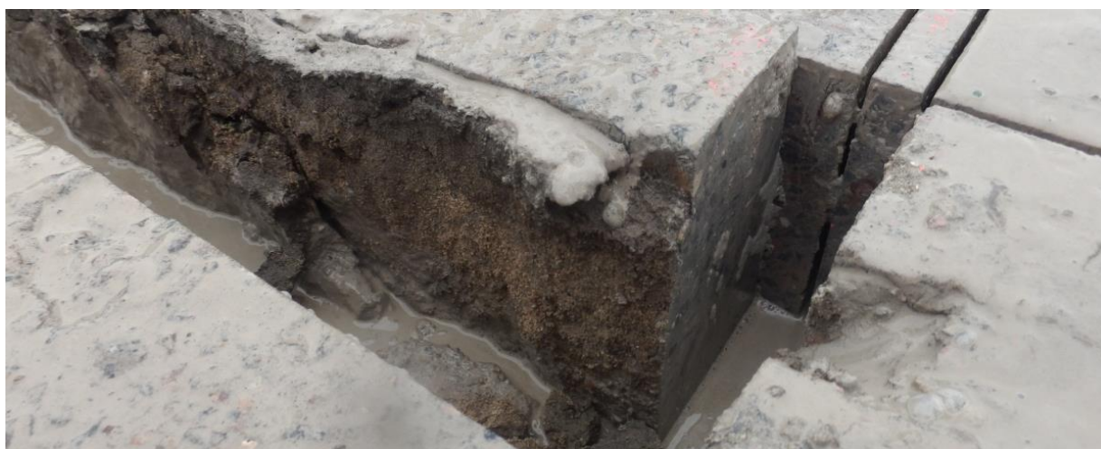
Foto 9. Halvasti säilinud vuugi avamine. Fotolt näha bituumenliiva vuugis
