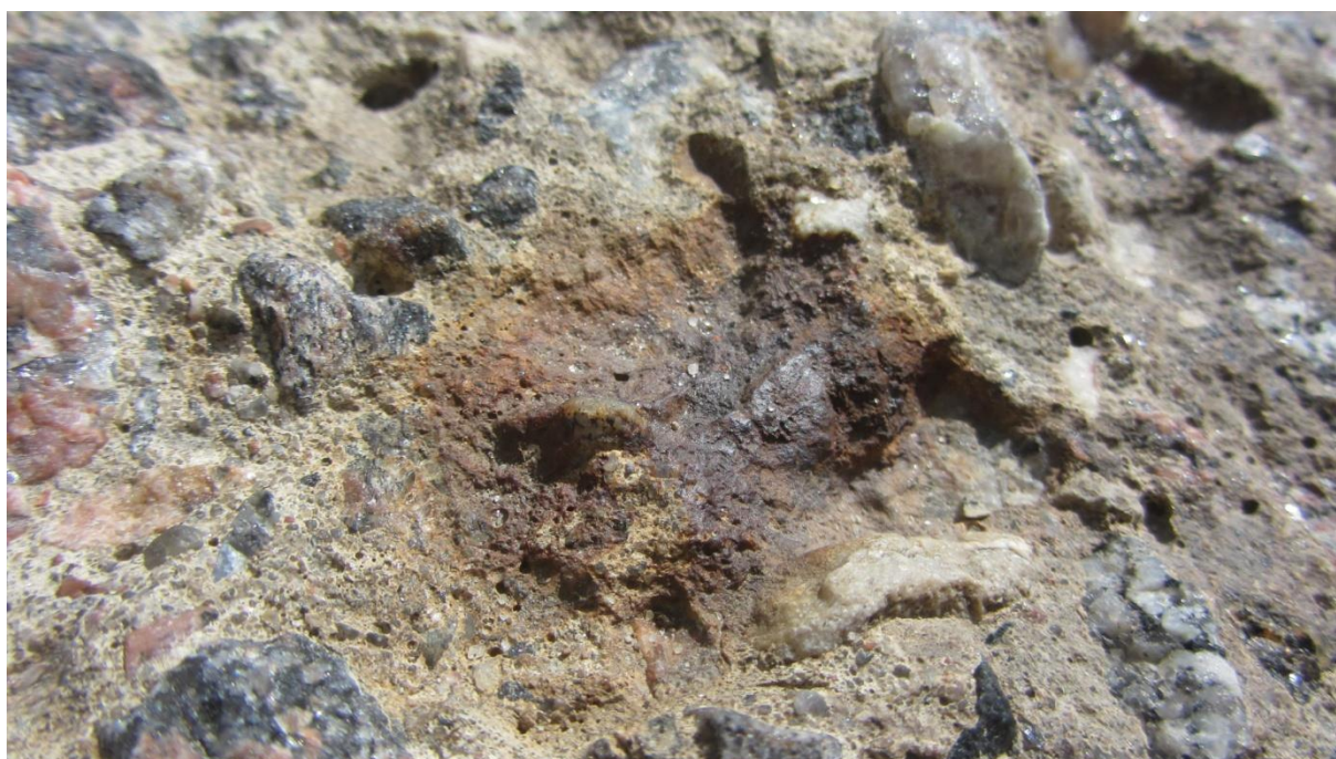
Foto 12. Korrodeerunud armatuur.
