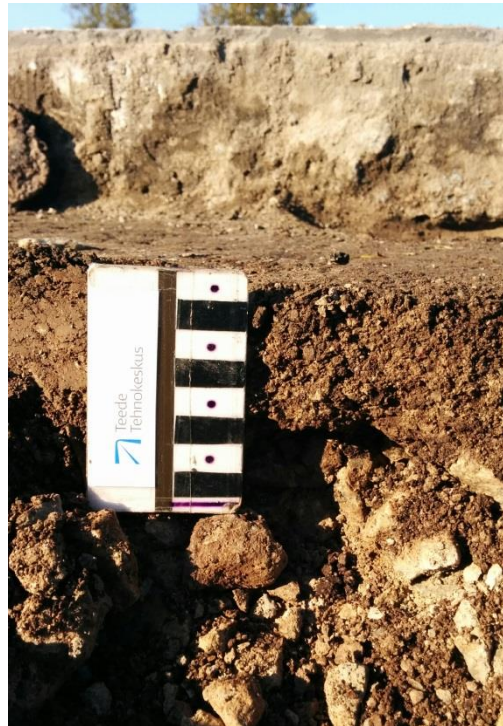
Foto 14. Vasakul fotol näha killustikukiht 17 cm, paremal bituumenliiv 5 cm
