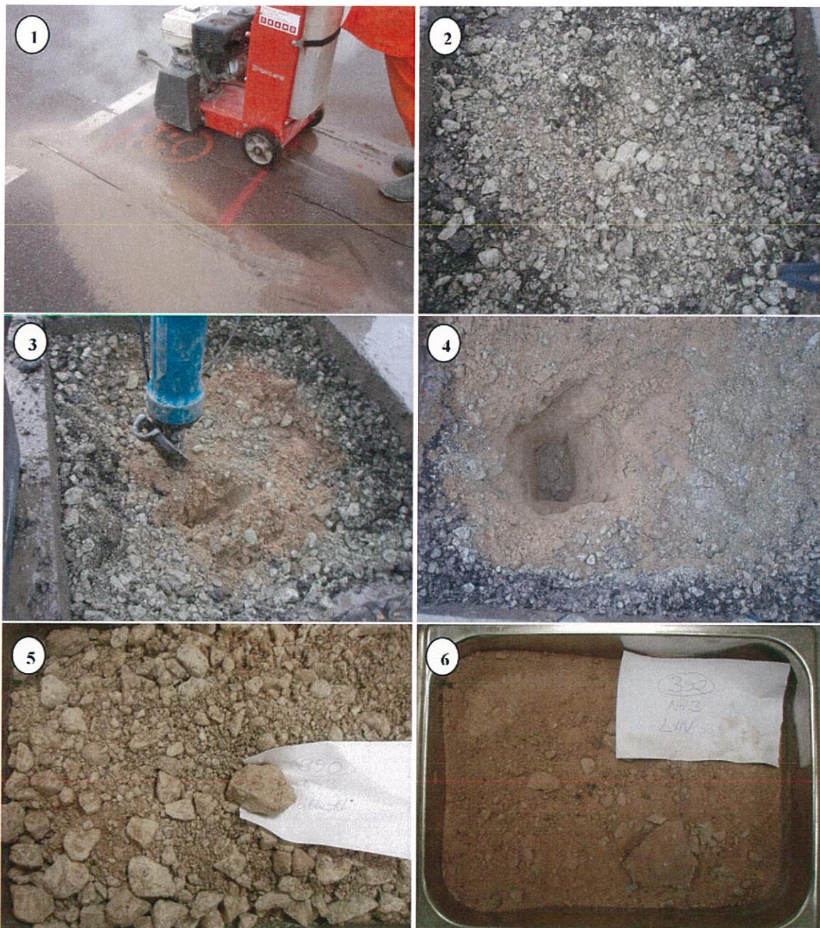
1- pragudega asfaltkatte lahtilõikamine 2- paekillustik 3- killustiku-liiva segu 4- avatud liivakiht 5- paekillustik peale kuivatamist laboris 6- liiv peale kuivatamist laboris
