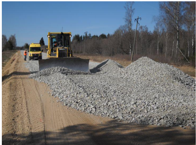
Joonis 11 Sidumata segust killustikaluse ehitus liivalusel Kohila-Tõngi teelõigul 2010
