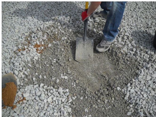
Joonis 7. Sidumata segu ulatuslik vertikaalne segregeerumine tööprotsessis
