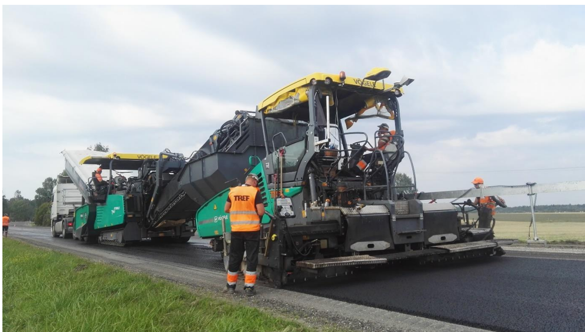
Joonis 13. Paralleelsed katte paigaldustemperatuuride mõõtmised
