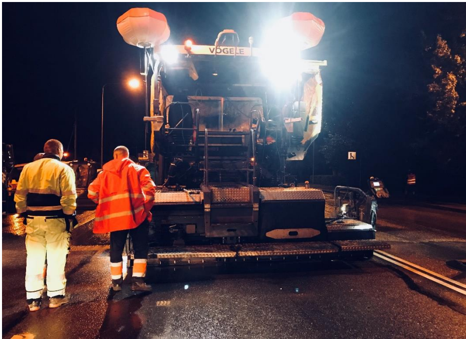
Joonis 2.2 Asfalteerimistööd objektil tee nr 3 Jõhvi-Tartu-Valga km 138.3-139.9 ülekate
