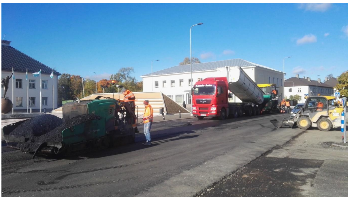
Joonis 32. Asfalteerimistööd kahe laoturiga 2
