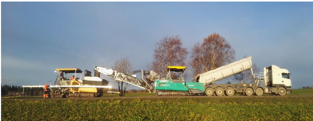
Joonis 42. Ühtlase paigaldustemperatuuri tagamine läbi termokastide ja söötja kasutamise, tulemuste operatiivseks jälgimiseks TGS
