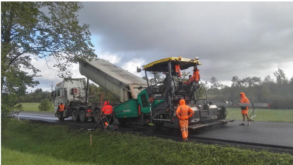
Joonis 29. Asfaltkatte laotamine tavameetodil (ilma söötjat kasutamata)
