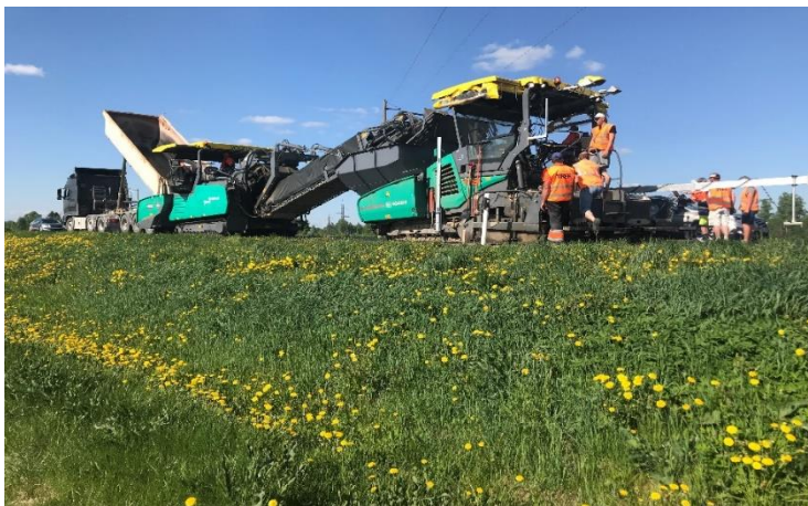
Joonis 2.1 Asfalteerimistööd objektil riigitee 39 taastusremont ning riigitee 39 Vahi-Maramaa lõigu ristmiku rekonstrueerimine
