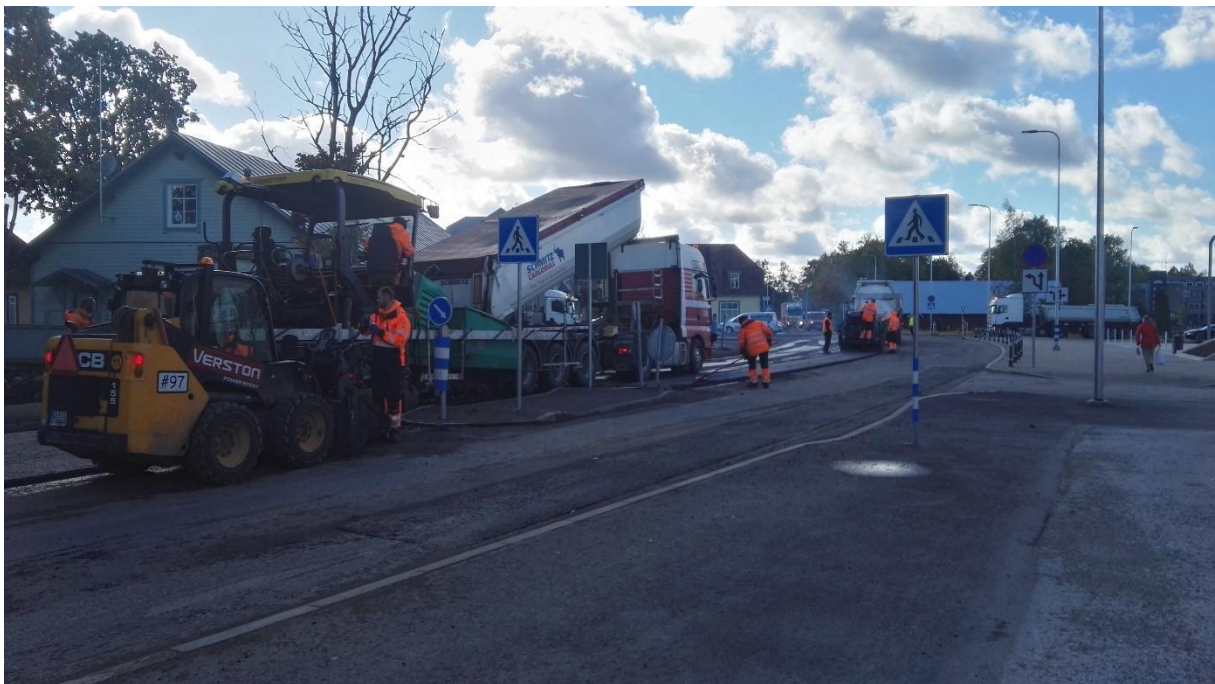
Joonis 30. Asfalteerimistööd kitsastes tingimustes
