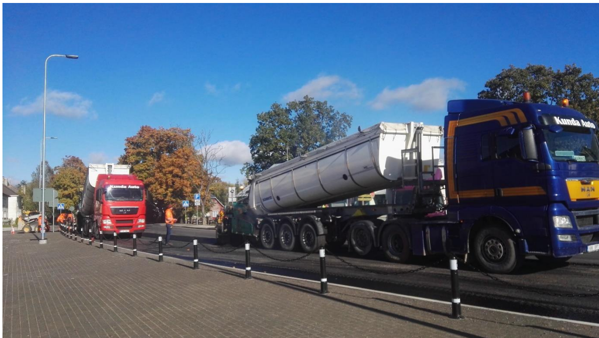
Joonis 31. Asfalteerimistööd kahe laoturiga 1
