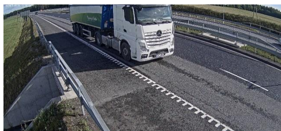
Foto 81. Piuga jalakäijate tunneli Tartu suund – 76,8 t [mõõtmiste 2. etapp]
