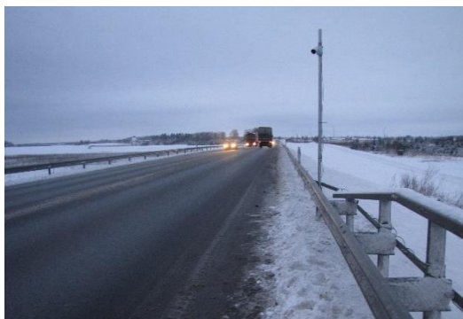
Foto 50. Seadmed Aseri viaduktil
