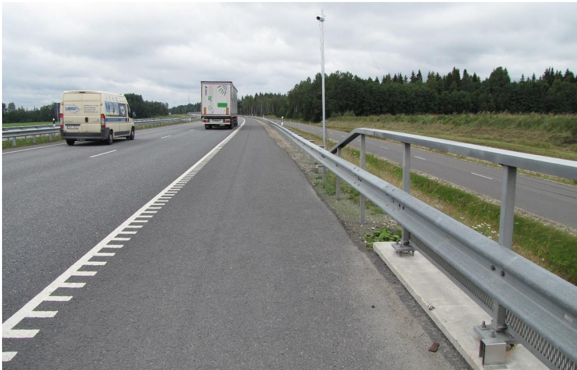
Foto 35. Seadmed Piuga jalakäijate tunnelis (Tallinna suund)
