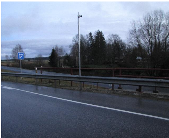
Foto 42. Seadmed Pinska viaduktil
