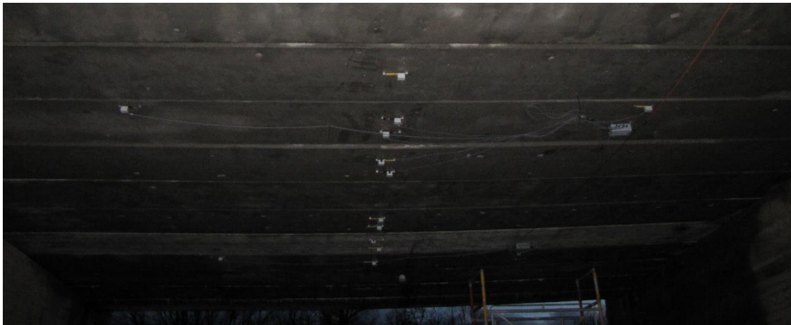
Foto 41. Seadmed Pinska viaduktil
