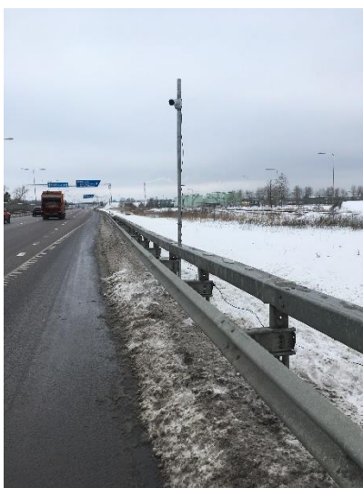
Foto 55. Seadmed Maardu järve jalakäijate tunnelis
