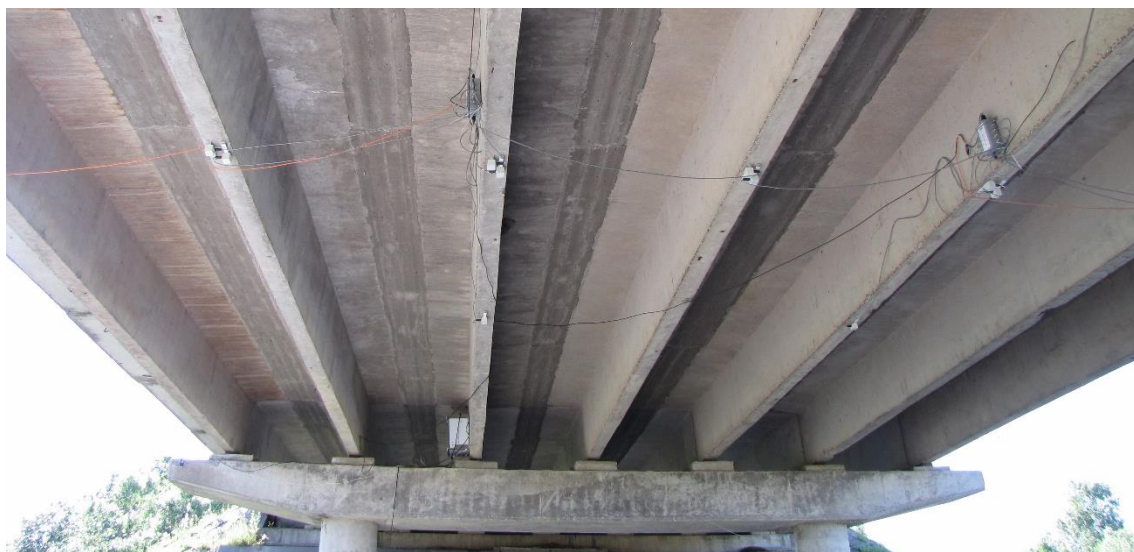
Foto 26. Seadmed Sanga viaduktil
