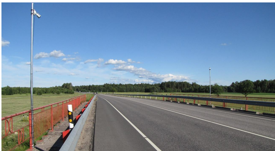
Foto 27. Seadmed Sanga viaduktil
