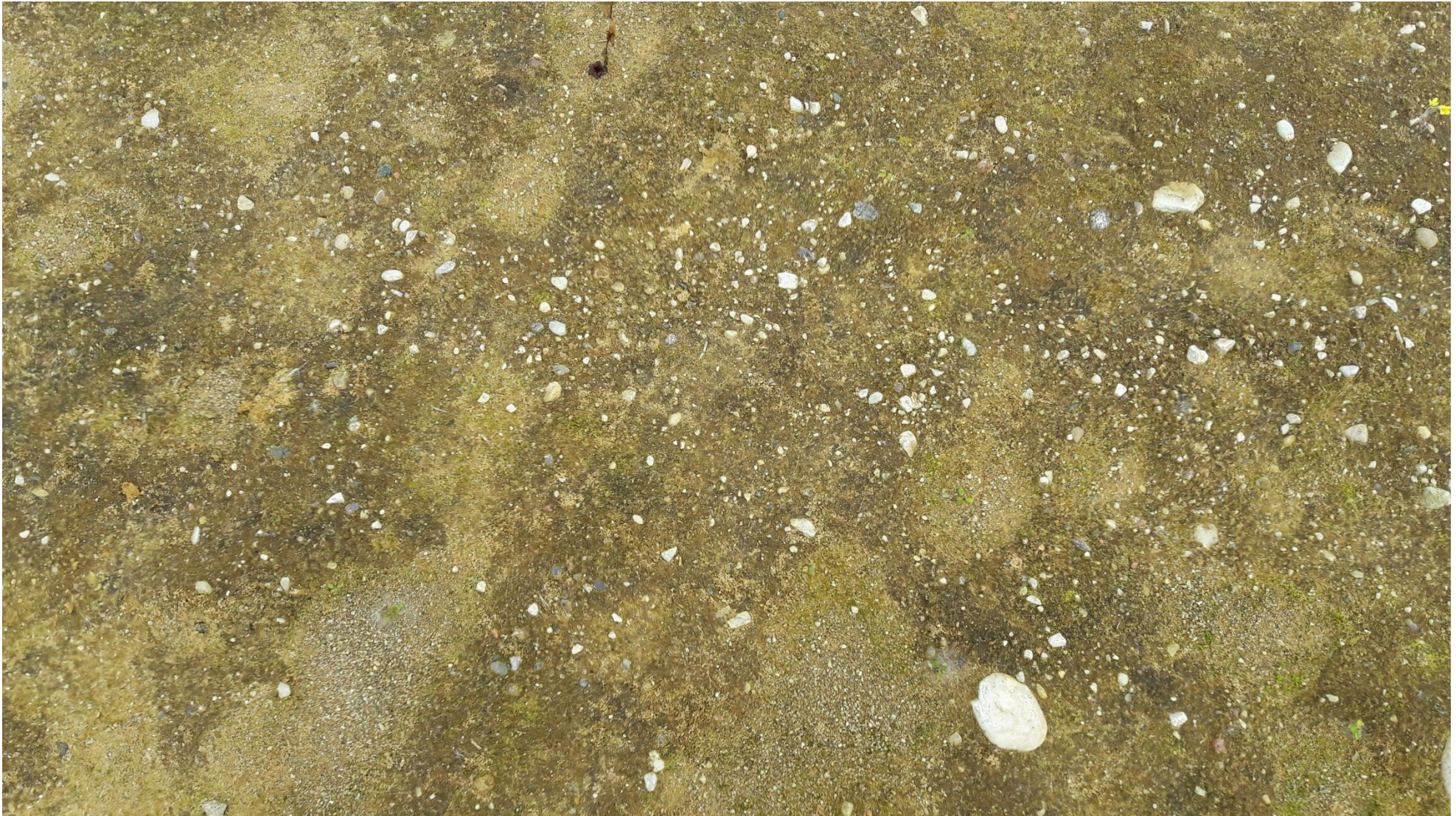
Foto 3. Eelnimetatud kohtade niiskuse tõttu sambla tekkimine. Formation of moss (due to moisture) in the middle of Sections 4 and 5
