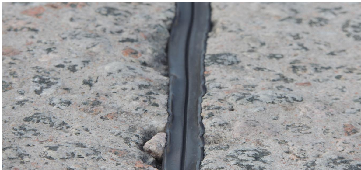
Foto 17. E4 Uppsala, remondi käigus paigaldatud uus vuugitihend, september 2013
