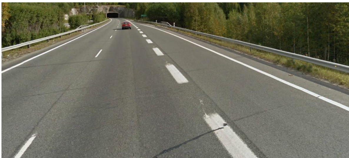
Foto 4. Vt 9 Lakalaiva, betoonplaadi ülekate asfaltbetooniga, august 2011
