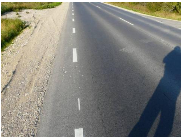
Foto 31. Paigaldusdefektid tihendamisel (samam risti lõikes 2008 ja 2009)
