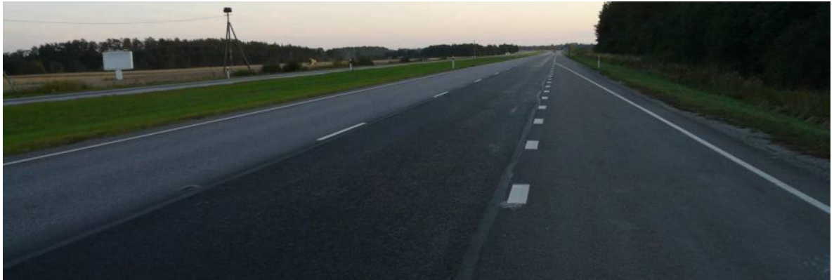
Foto 13. Gilsoniidilisandiga SMA/KMA paigaldusala algus, 2008
