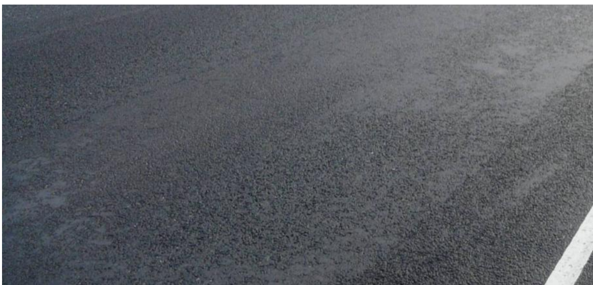
Foto 43. T4 km 78,42, iseloomulik katte poorne tekstuur (2009)
