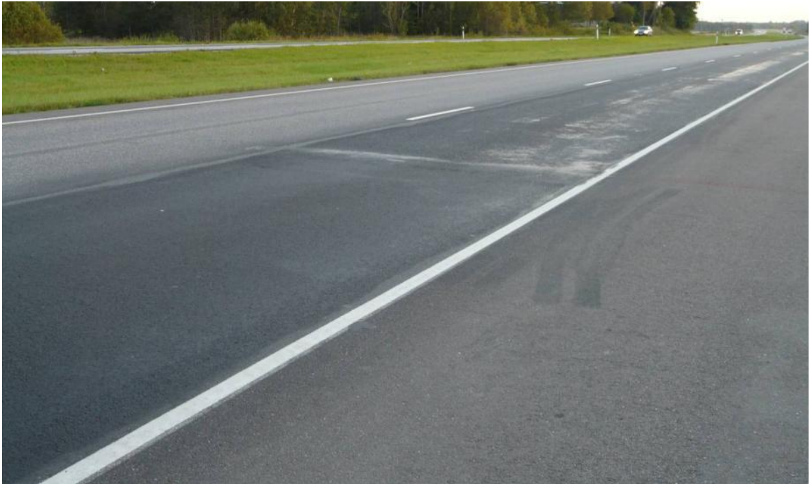
Foto 8. TAB ja KMA paigaldusala piir, 2008
