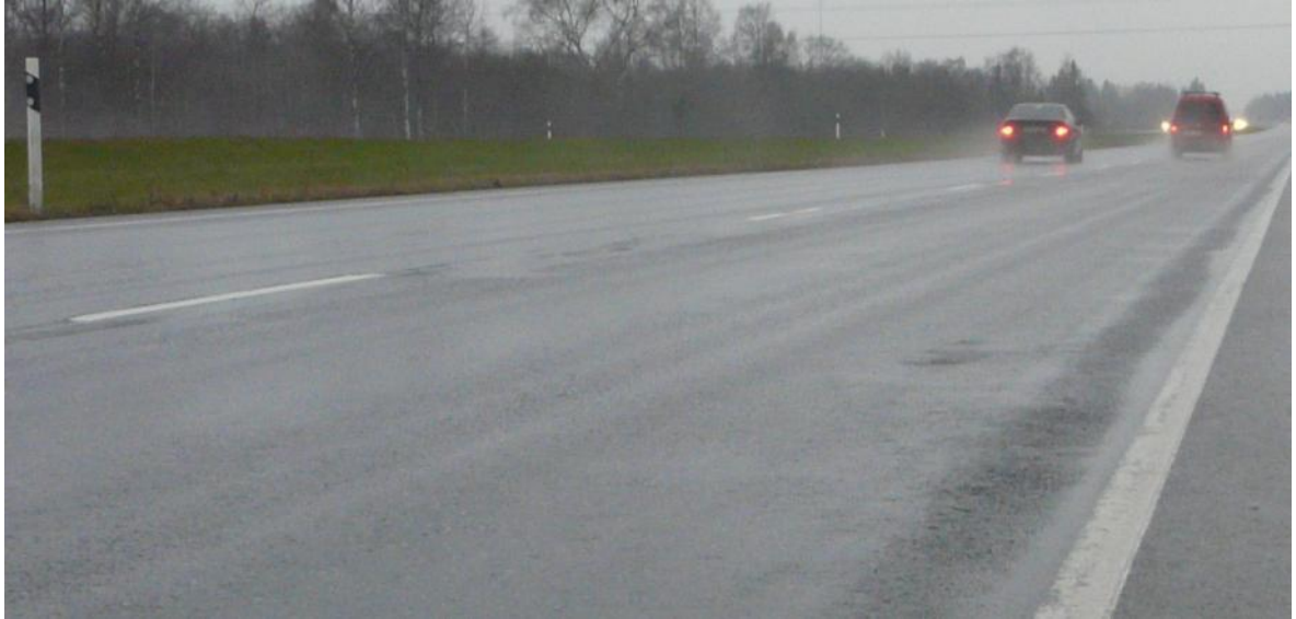
Foto 6. Roopad formeerunud lisandiga TAB alal, 2010
