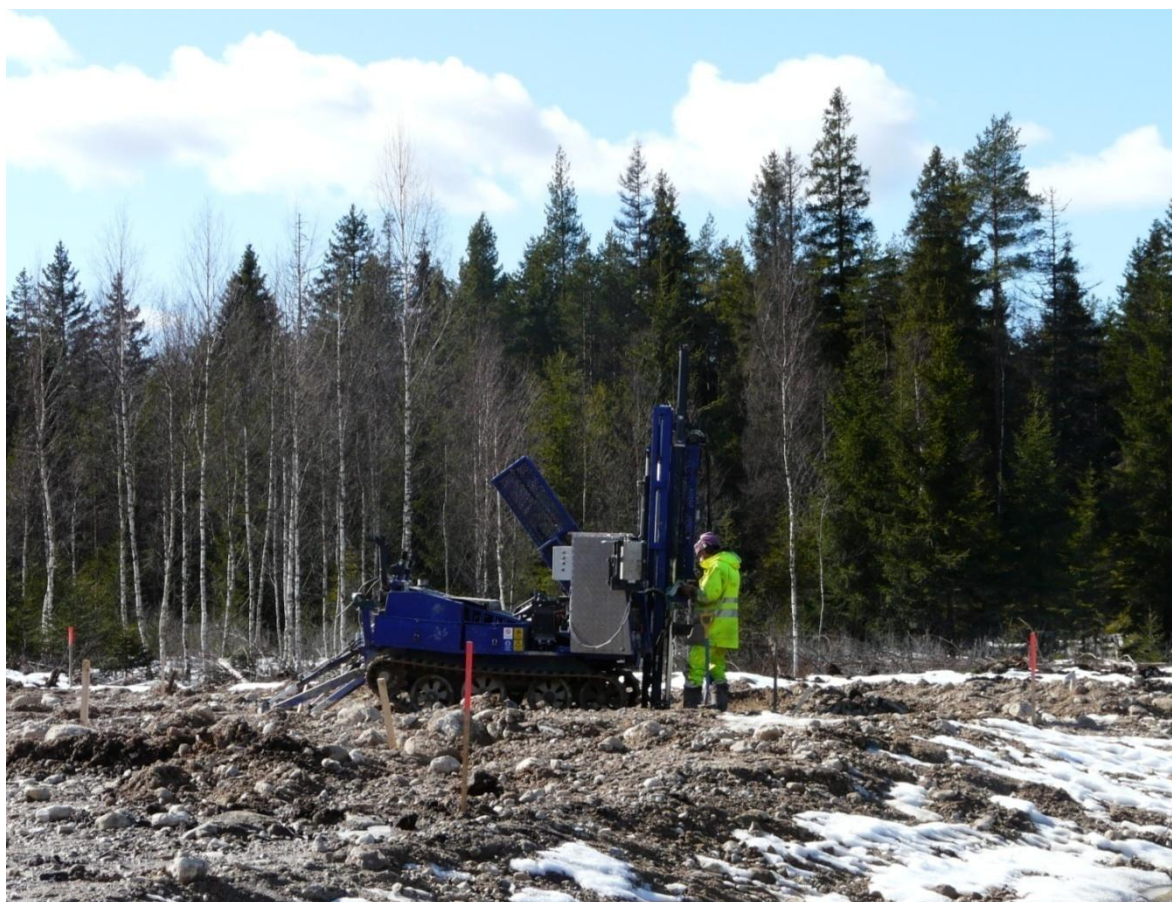
Joonis 5. Penetratsioonikatsete läbiviimine katselõigul
